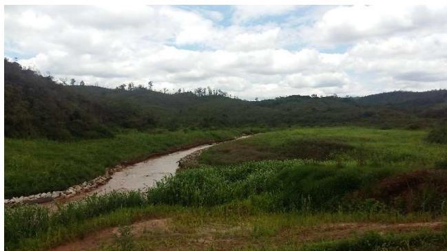
Serviços de bioengenharia executados na área prioritária 03- Mariana (MG) / (Crédito: Divulgação Fundação Renova).
