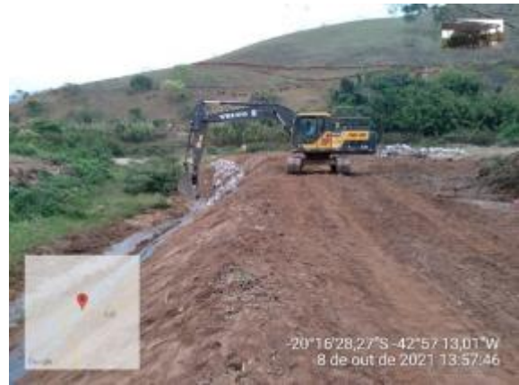
Proteção de talude com enrocamento
