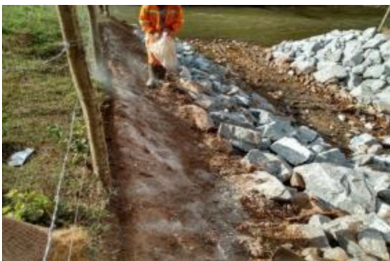
Revestimento de drenagem com pedra de mão
