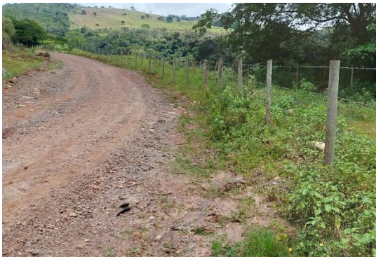
Reestabelecimento de drenagem da via
