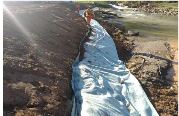
Aplicação de geotêxtil
