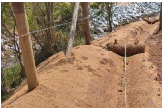
Proteção de canaleta e revestimento com biomanta
