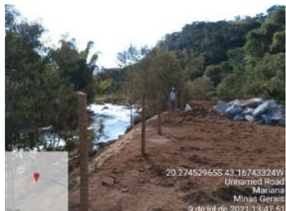
Proteção de talude com instalação de biomanta
