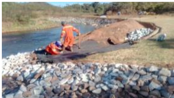
Reconformação de canaleta e revestimento com enrocamento com pedras de mão.
