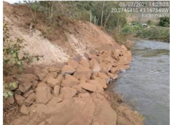
Proteção de talude com enrocamento
