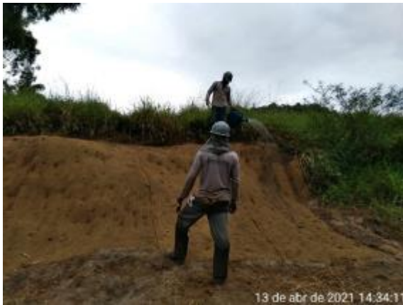
Revestimento de talude com biomanta
