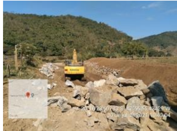
Proteção de talude com enrocamento
