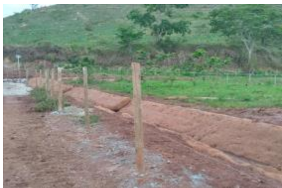
Proteção de canaleta e revestimento com biomanta
