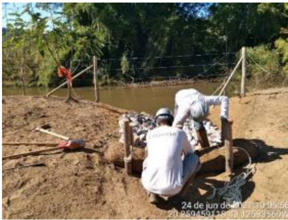
Manutenção de descida d'água
