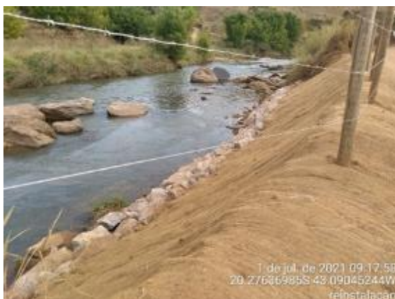
Proteção de talude com enrocamento e biomanta
