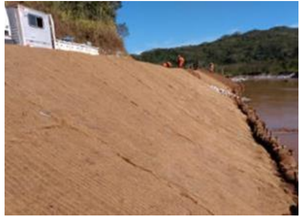
Instalação de descidas d'água e proteção de talude com mix de cimentos
