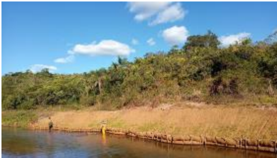
Proteção de talude com biomanta
