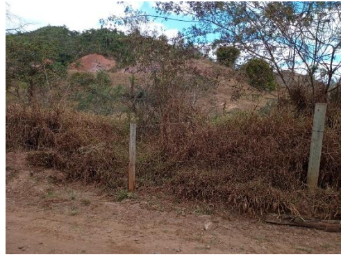
Drenagem do acesso
