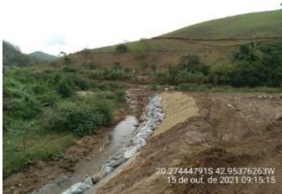
Proteção de talude com enrocamento e biomanta
