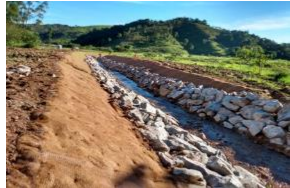
Reconformação de taludes de tributário com proteção com enrocamento
