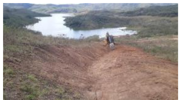
Reconformação da canaleta.
