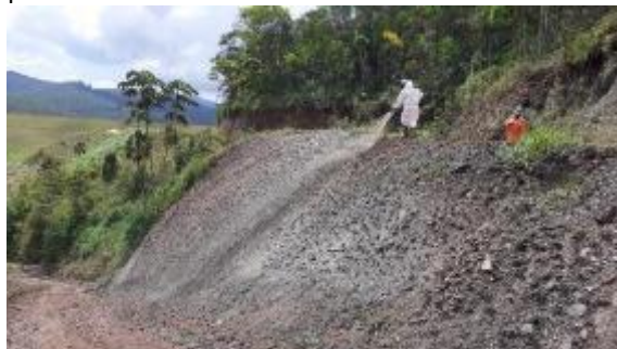
Aplicação de hidrossemeadura nos taludes.
