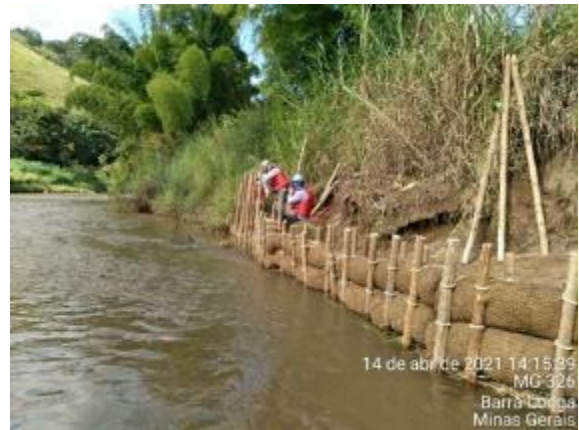
Instalação de biorretentores nas margens
