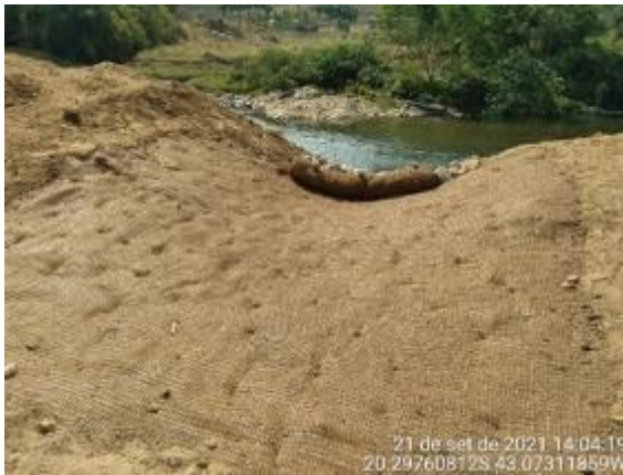
Revestimento de canaletas de drenagem com biomantas
