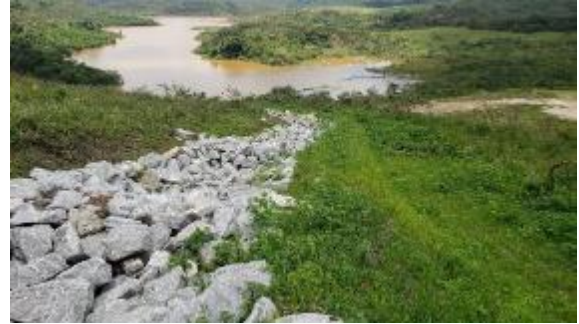
Canaleta revestida com enrocamento e revegetação das margens.
