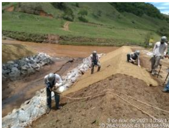
Instalação de biomantas em taludes
