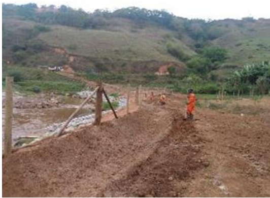
Instalação da drenagem de planície e cerca
