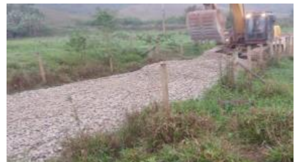
Recuperação de processo erosivo em acesso
