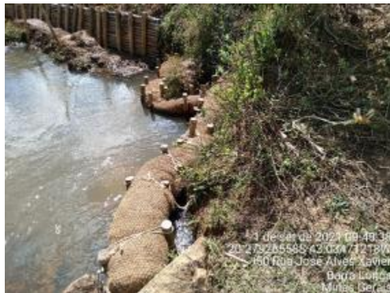
Instalação de biorretentores nas margens
