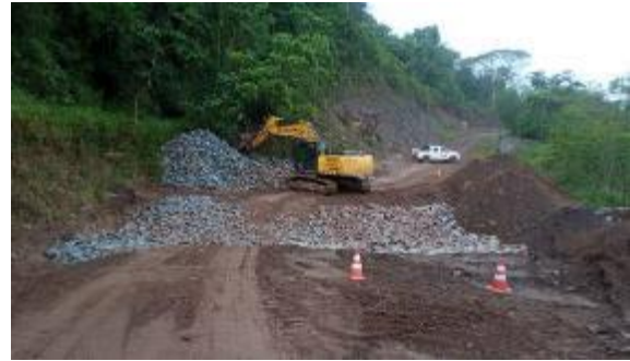
Construção de passagem Molhada no acesso
