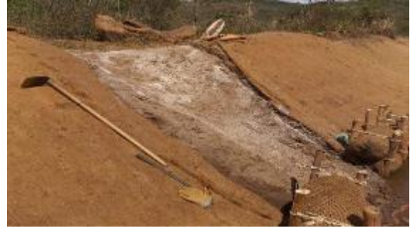
Proteção de talude com biomanta
