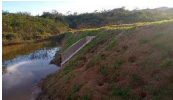
Visão de montante do bueiro concluído.
