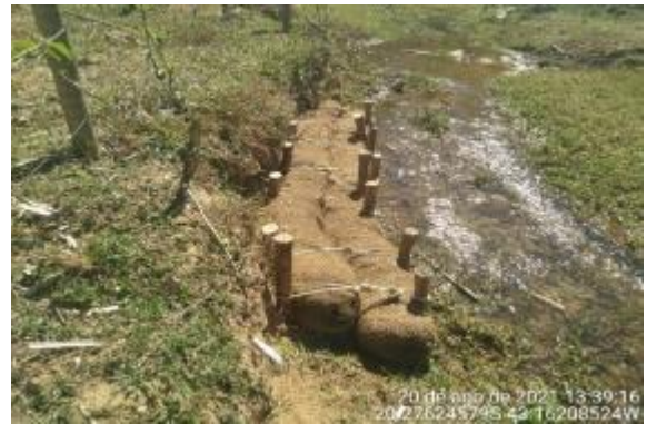
Instalação de biorretentores em margem
