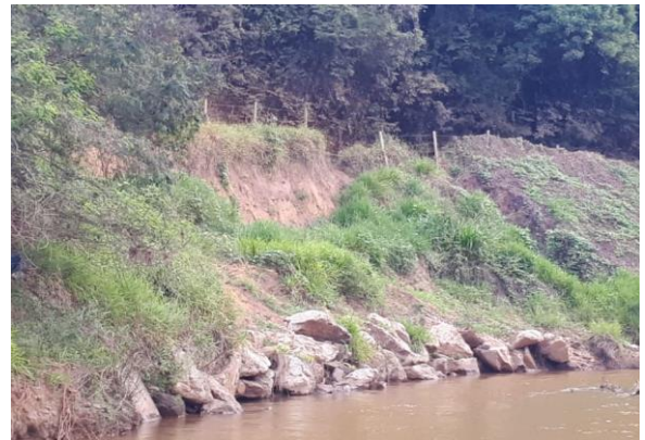
Revestimento com enrocamento
