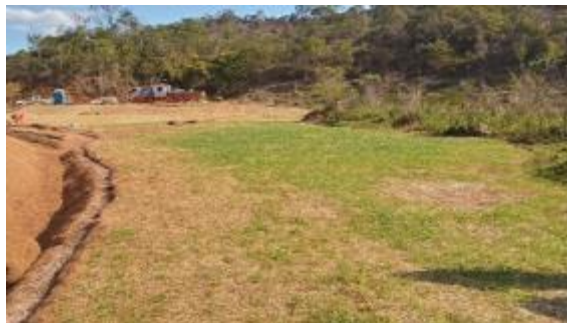
Manutenção das canaletas
