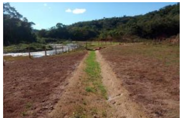
Proteção de canaleta e revestimento com biomanta
