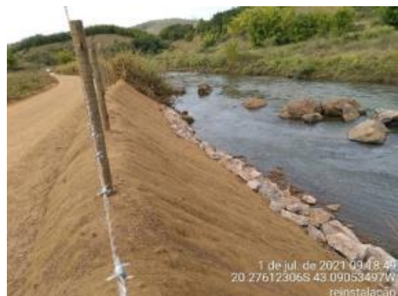
Proteção de talude com enrocamento e biomanta
