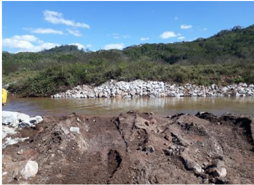
Revestimento com enrocamento
