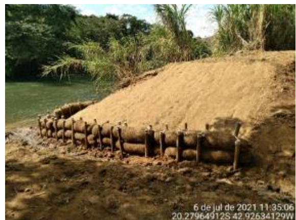
Instalação de biorretentores nas margens
