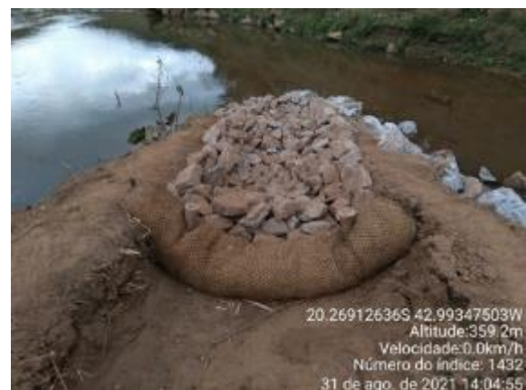
Descida d'água enrocada
