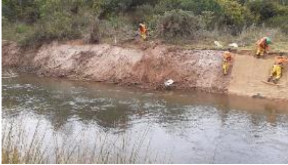
Reconformação de talude
