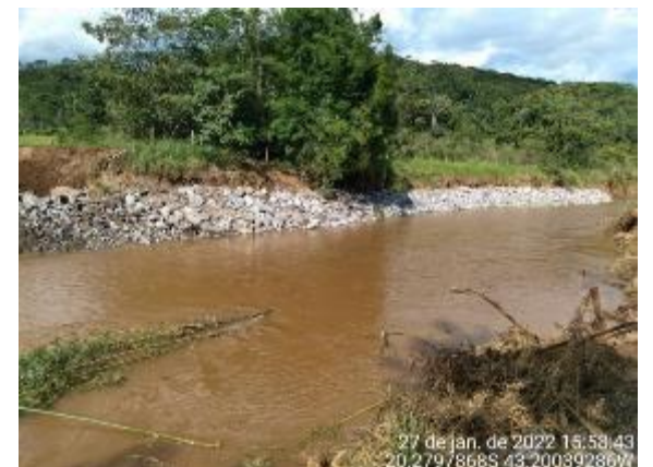
Proteção de talude com enrocamento
