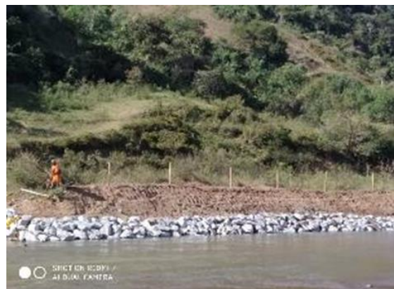
Revestimento com enrocamento
