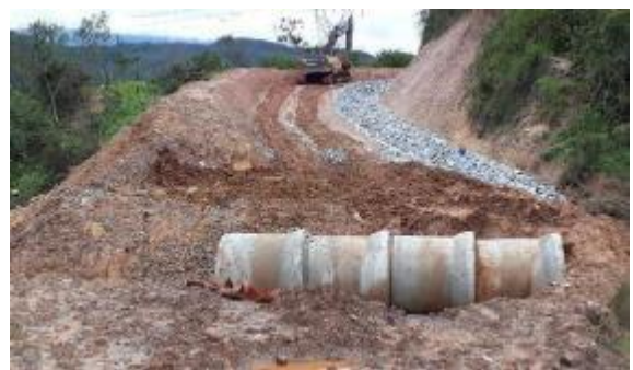
Instalação do bueiro simples celular de concreto.
