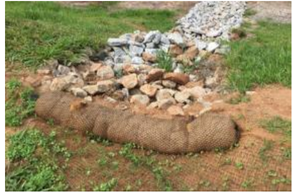
Manutenção de canaletas de drenagem com enrocamento e instalação de biorretentores
