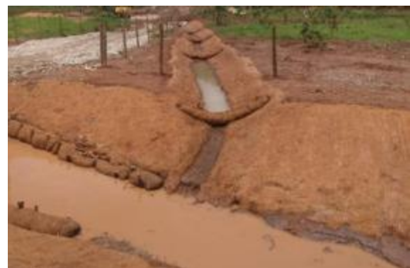
Proteção de canaleta e revestimento com biomanta
