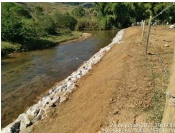
Proteção de talude com enrocamento e biomanta
