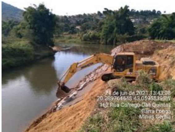
Proteção de talude com enrocamento
