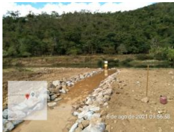
Proteção de talude com enrocamento
