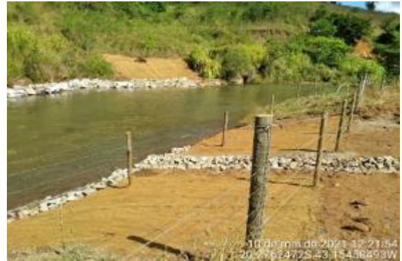
Aplicação de biomanta na face do talude
