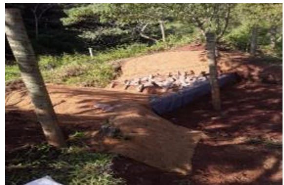
Revestimento de canaletas de drenagem com biomantas
