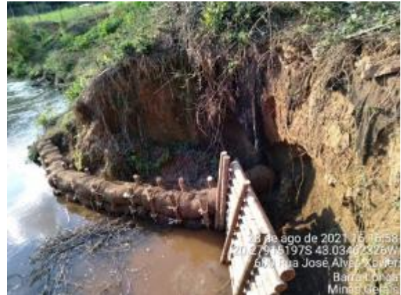
Proteção do talude com biorretentores e Instalação de paliçadas
