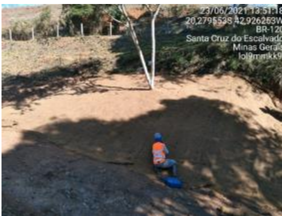
Instalação de biomantas
