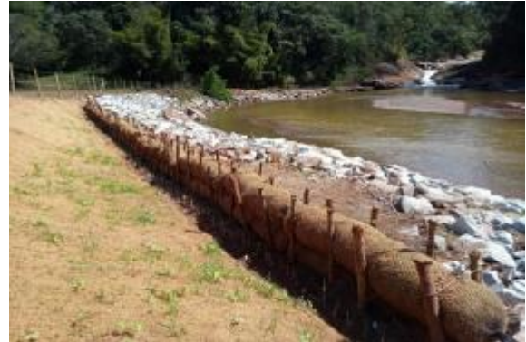
Instalação de biorretentores em margem
