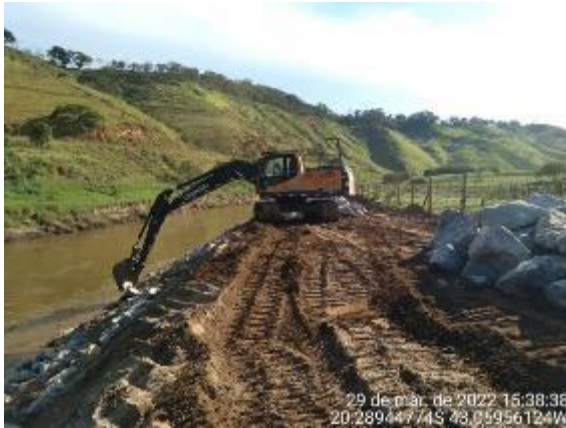
Proteção de talude com enrocamento e biomanta
