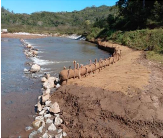
Drenagem de planície e proteção com bioretentor
