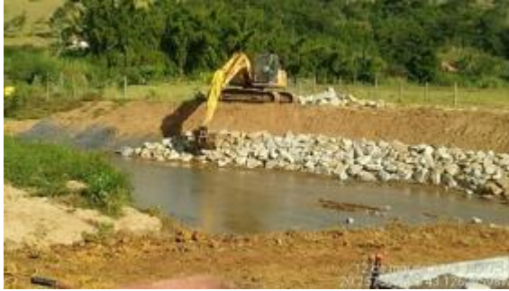
Proteção de talude com enrocamento
