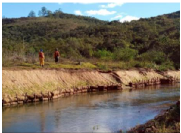
Proteção de talude com biomanta
