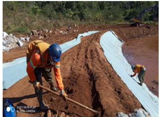
Fornecimento e aplicação de geotêxtil
