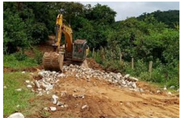
Recuperação de processo erosivo em acesso
