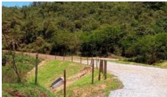
Visão parcial do local após a implantação do bueiro.
