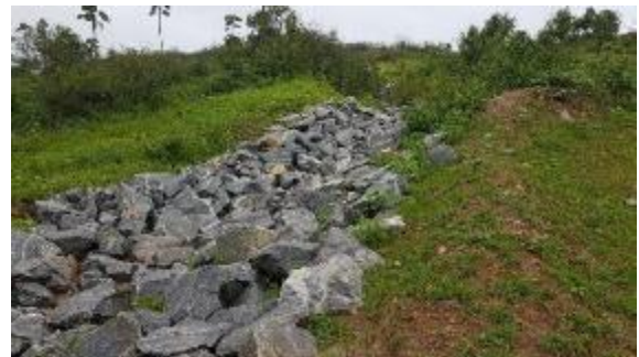
Canal de drenagem finalizado com revestimento vegetal nas margens.
