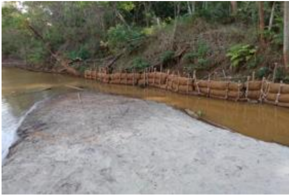
Instalação de biorretentores em margem
