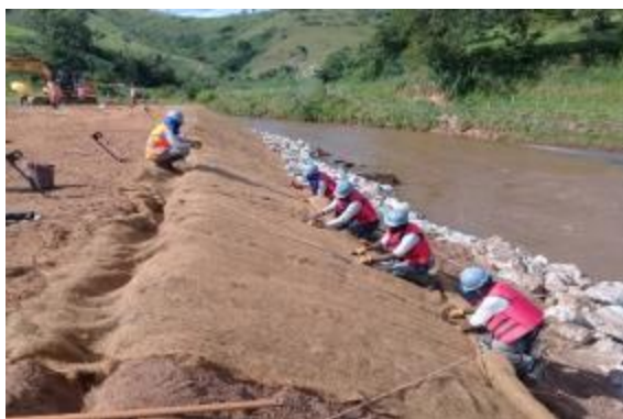
Aplicação de biomanta na face do talude
