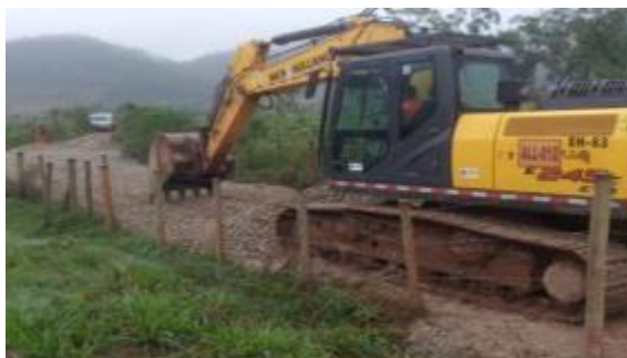
Recuperação de processo erosivo em acesso
