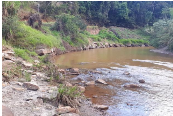
Revestimento com enrocamento
