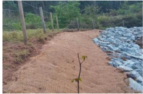
Reconformação de taludes de tributário com proteção com enrocamento e biomanta
