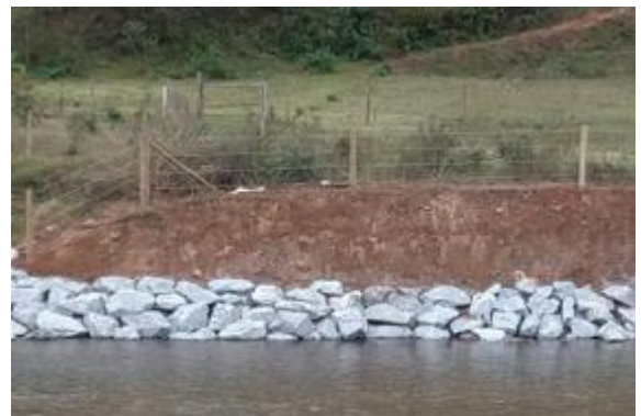
Reconformação de talude de margem com base em enrocamento
