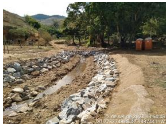
Proteção de talude com enrocamento
