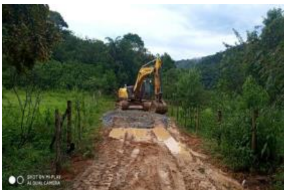
Recuperação de processo erosivo em acesso
