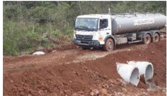
Instalação do bueiro duplo celular de concreto.
