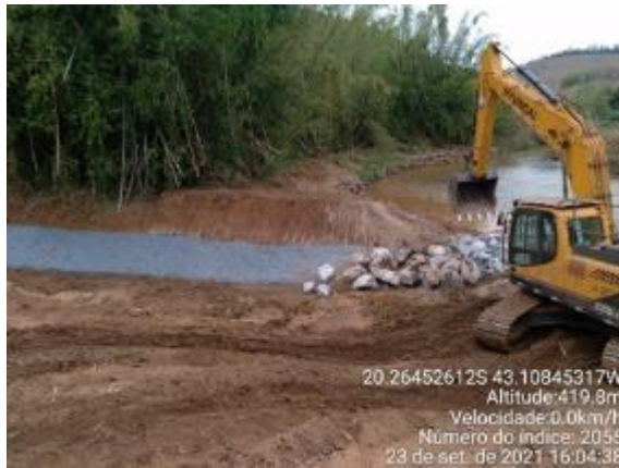
Proteção de talude com enrocamento
