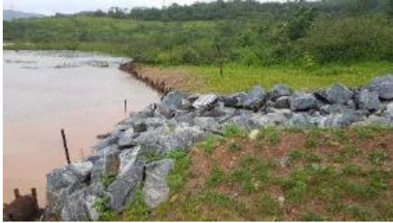
Ponto de desague do canal finalizado com enrocamento e revegetação das margens.
