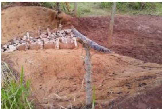
Revestimento de canaletas de drenagem com biomantas
