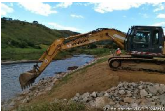
Proteção de talude com enrocamento
