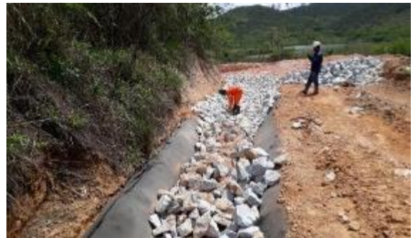
Reconformação do acesso e instalação de canaleta enrocada.
