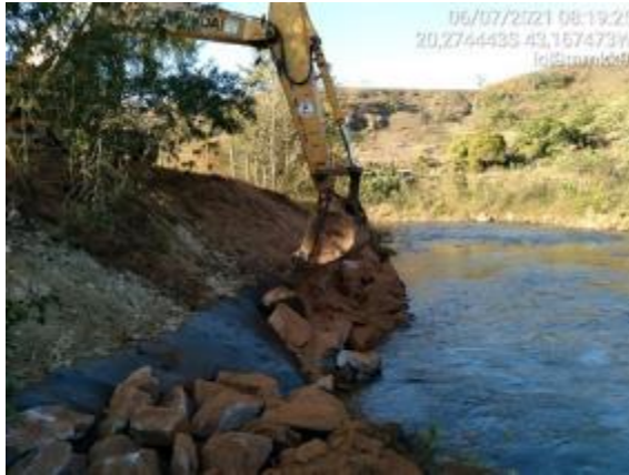
Proteção de talude com enrocamento
