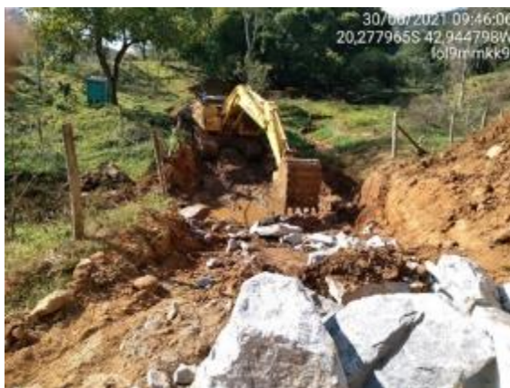
Instalação de passagem molhada
