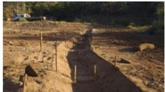
Reconformação de canaleta e revestimento com biomanta e biorretentores.
