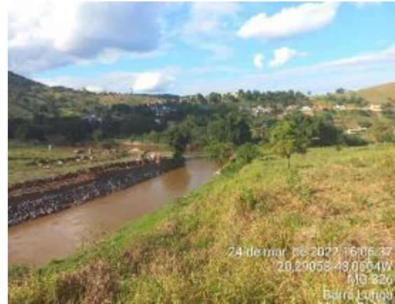
Proteção de talude com enrocamento e biomanta
