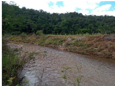
Revestimento com enrocamento
