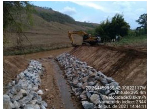
Proteção de talude com enrocamento
