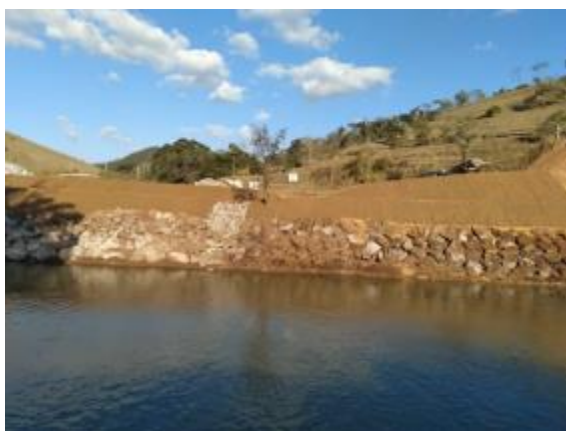
Proteção de talude com enrocamento
