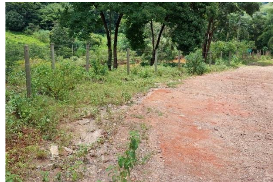
Reestabelecimento de drenagem da via
