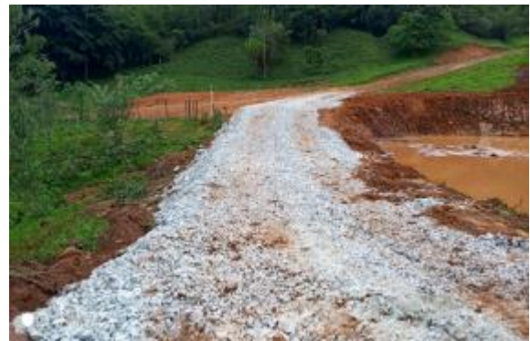
Recuperação de processo erosivo em acesso
