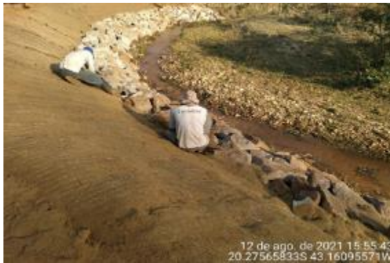
Aplicação de biomanta na face do talude
