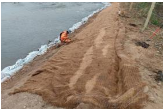
Aplicação de biomanta na face do talude
