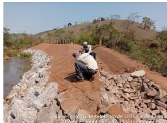
Reconformação de talude
