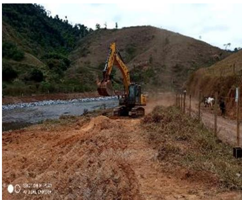
Regularização de terreno e drenagem
