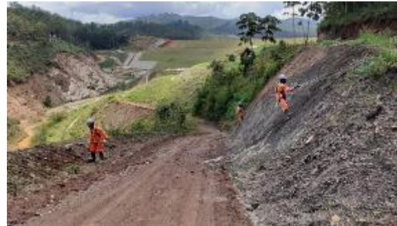
Acerto e regularização manual dos taludes e preparo para hidrossemeadura.
