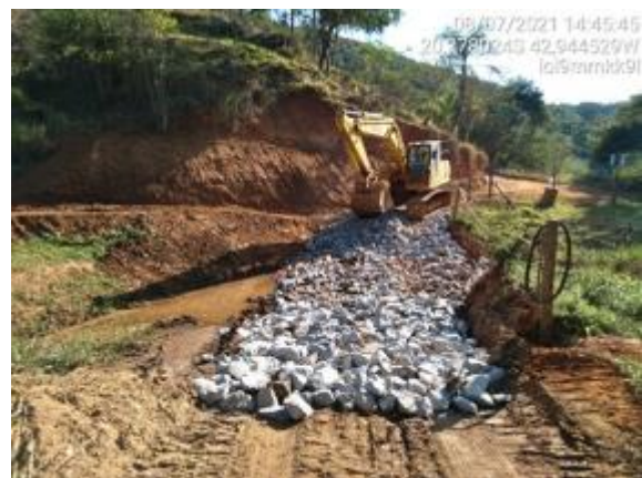
Instalação de passagem molhada
