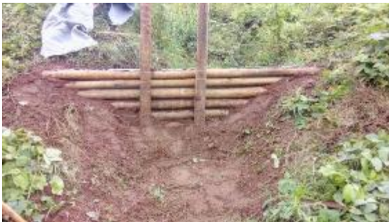
Instalação de paliçadas de madeira
