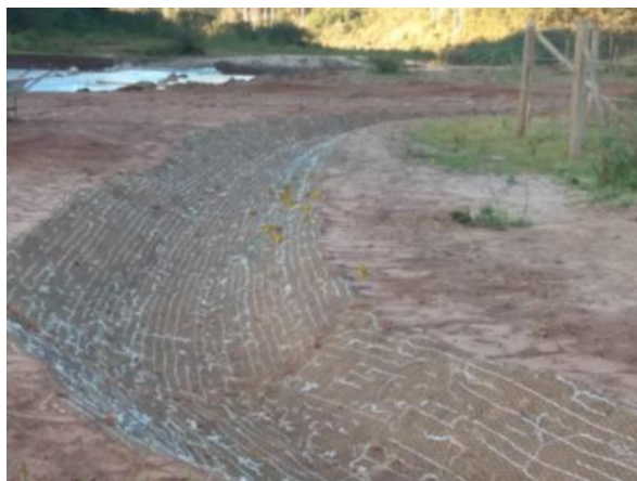
Reconformação da planície com implantação de drenagens e cobertura da área com mix de sementes
