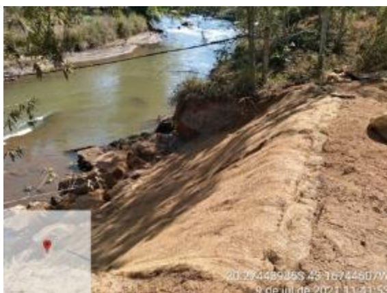
Proteção de talude com instalação de biomanta
