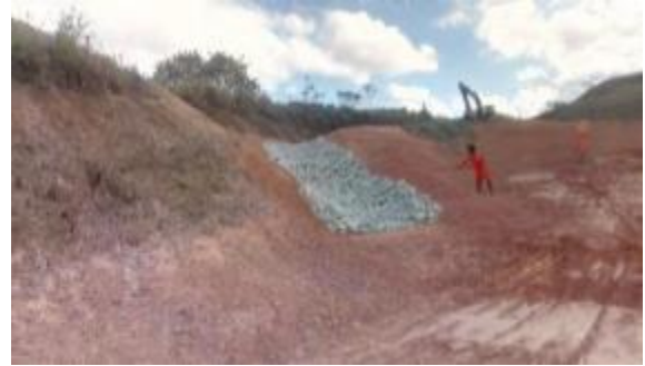
Reconformação e revestimento de canaleta com enrocamento.
