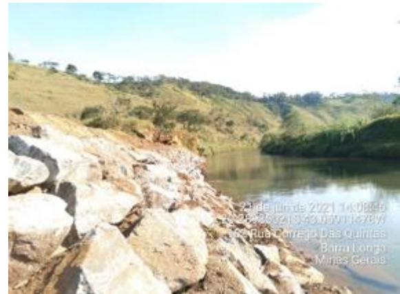
Proteção de talude com enrocamento
