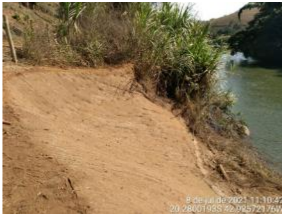
Instalação de biomantas
