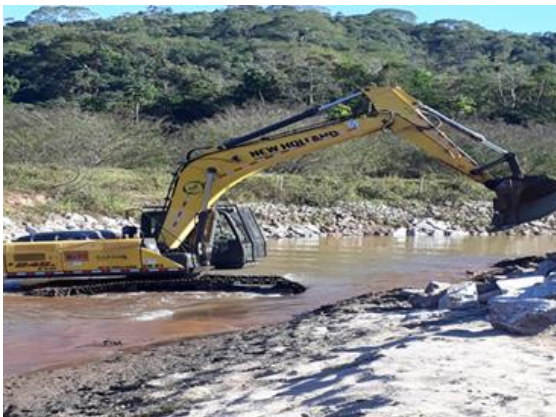
Revestimento com enrocamento
