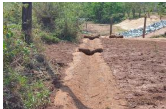
Proteção de canaleta e revestimento com biomanta
