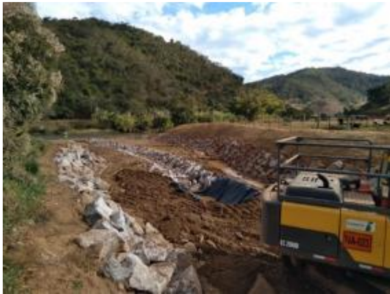
Proteção de talude com enrocamento
