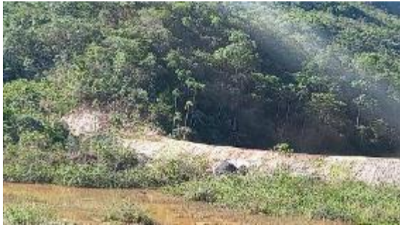
Visão de montante do bueiro concluído.
