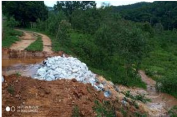
Recuperação de processo erosivo em acesso
