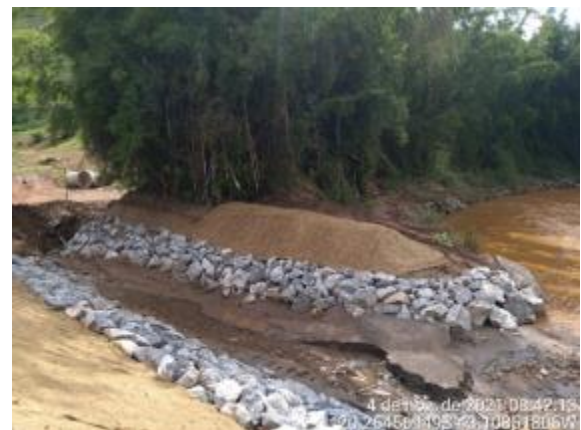
Proteção de talude com enrocamento
