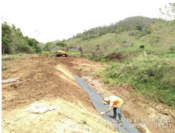
Reconformação de talude e instalação de filtro de transição
