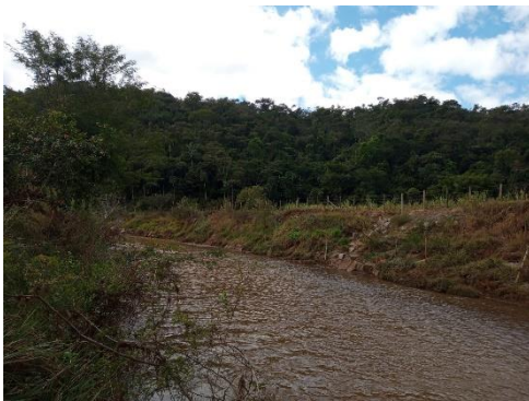
Revestimento com enrocamento
