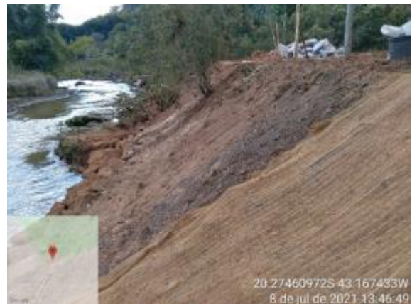
Proteção de talude com instalação de biomanta
