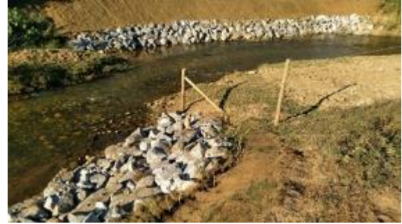
Proteção de talude com enrocamento
