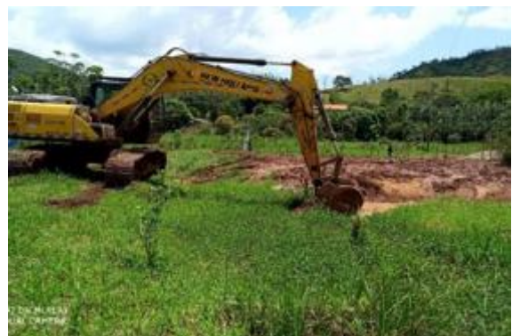
Manutenção de sistema de drenagem
