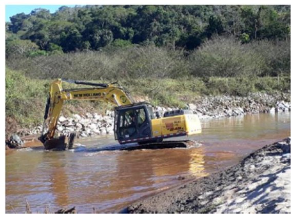
Revestimento com enrocamento
