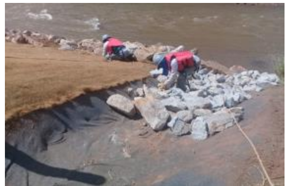
Revestimento de canaleta de drenagem com pedra de mão
