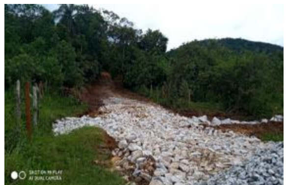
Recuperação de processo erosivo em acesso
