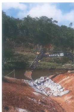
Instalação de descida d'água enrocada
