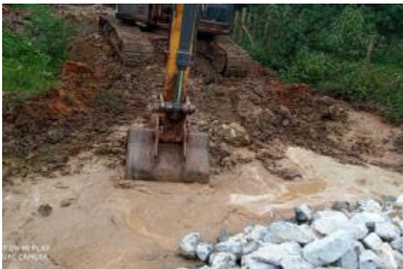
Recuperação de processo erosivo em acesso
