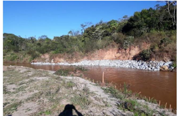
Revestimento com enrocamento
