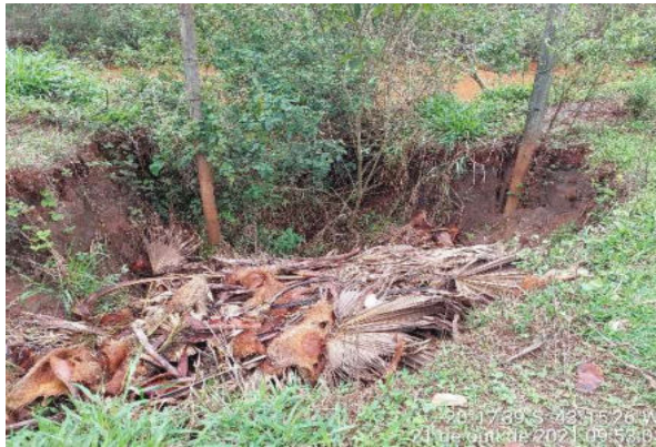
02. Trechos da área vistoriada.
