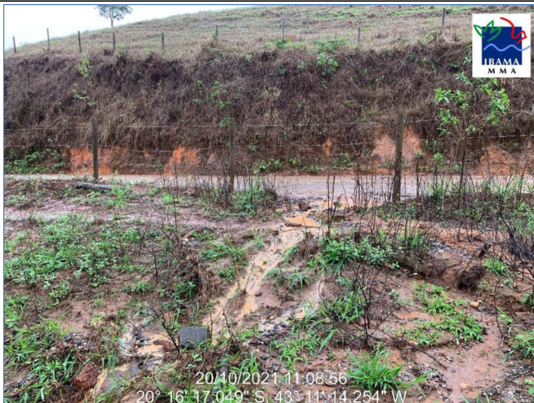
03. Trecho da área vistoriada.
