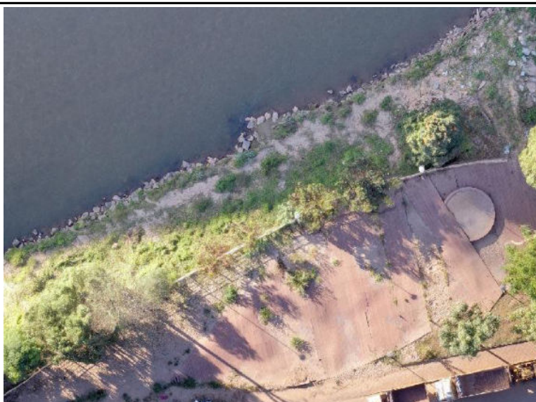
03. Imagem da área vitoriada. Necessidade de reparação da orla.
