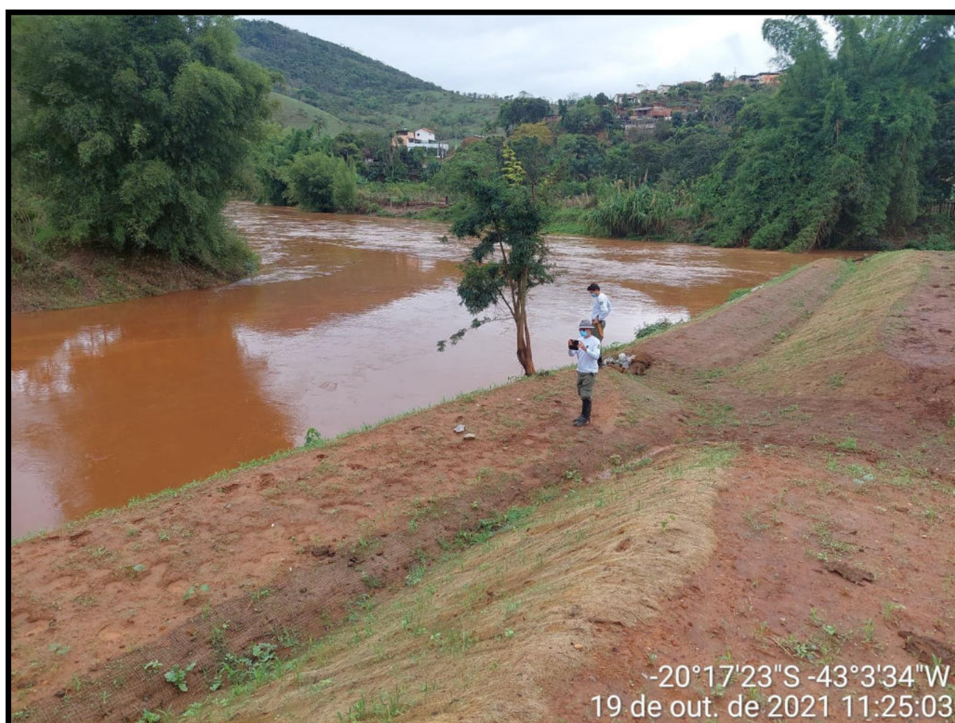
Figura 28: Obras de engenharia (conformação da margem e controle de erosão) e de bioengenharia (biomantas) implantadas recentemente na área.
