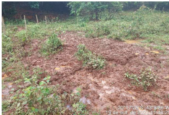
02. Trechos da área vistoriada, com vestígios da presença de gado.
