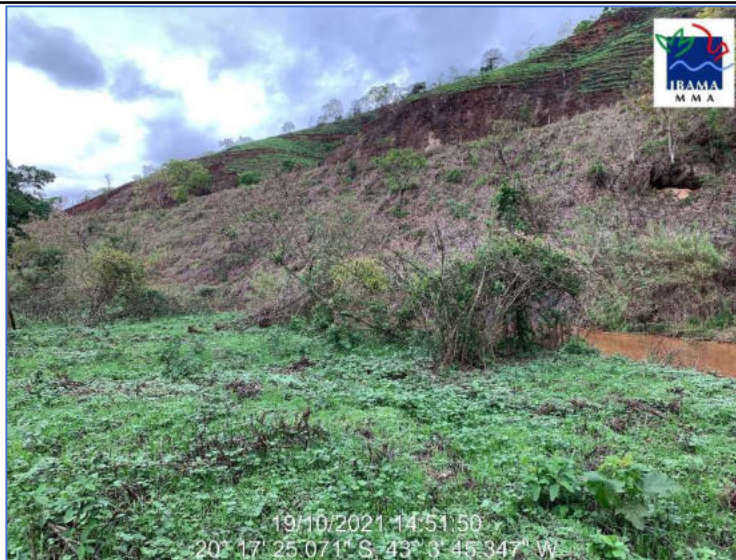
04. Trecho da área vistoriada.
