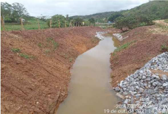
01. Trechos da área vistoriada.
