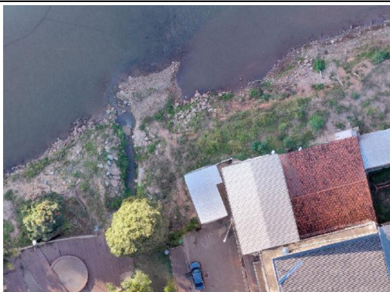
04. Imagem da área vitoriada. Necessidade de reparação da orla.
