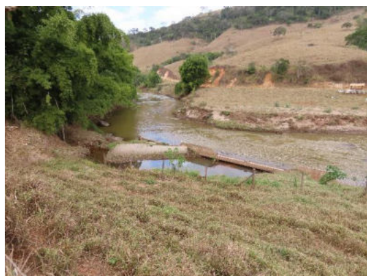
02. Trechos da área vistoriada.
