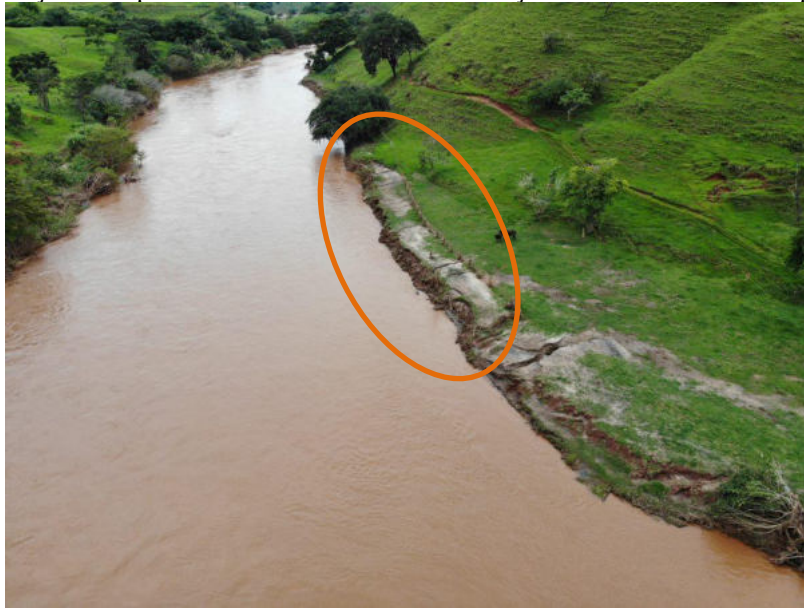
Figura 10 Indicação do depósito de sedimentos na UT e remoção de toda a cerca de adequação.
