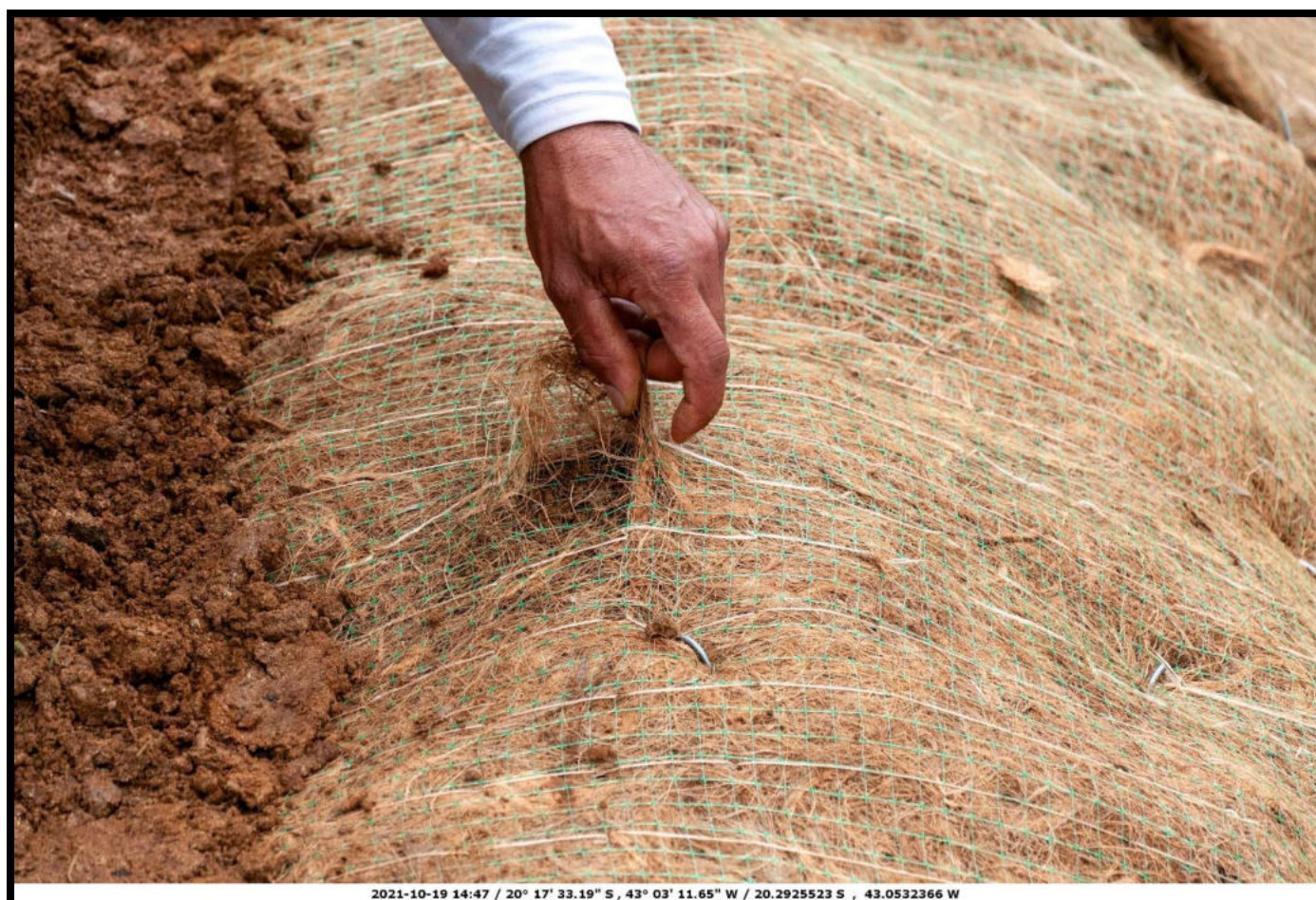
Figura 05: Biomanta sendo implantada no momento da vistoria. O mix de sementes fica preso sob a biomanta.
