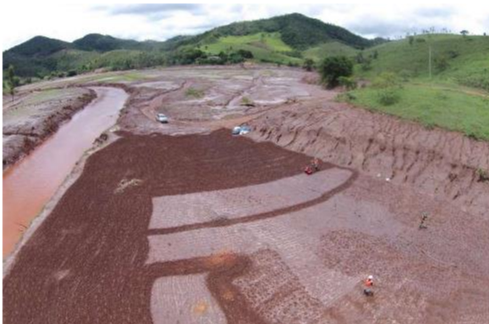
Figura 8: Exemplo 3 - Preparo do solo utilizando métodos manuais e semi-mecanizados de escarificação do substrato, semeadura e fertilização.
