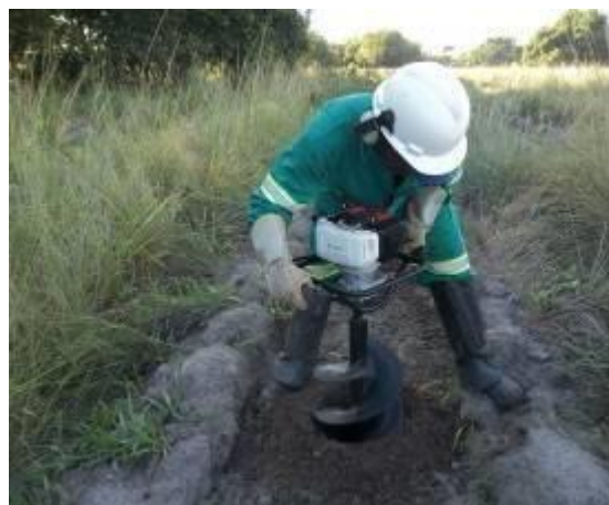
Figura 56: Abertura de cova semi- mecanizada
