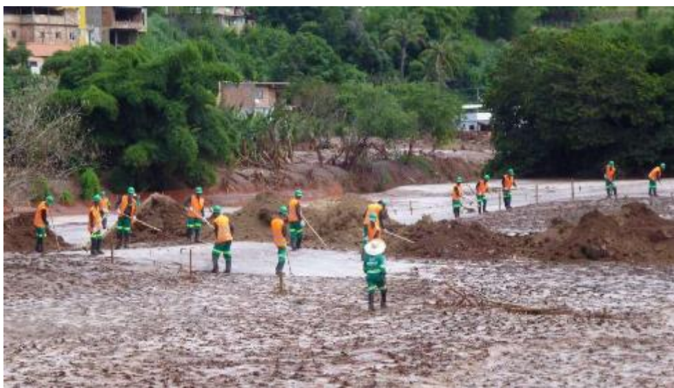
Figura 6: Exemplo1 - Microcoveamento manual do solo com uso de enxadinhas.
