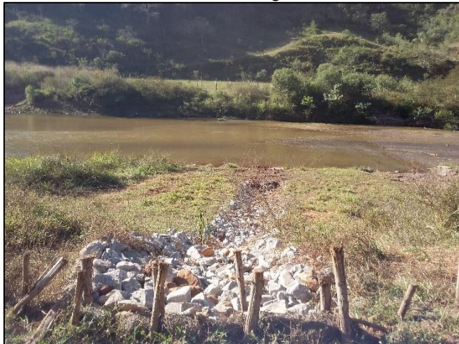
Foto 213: Canaleta de Drenagem
