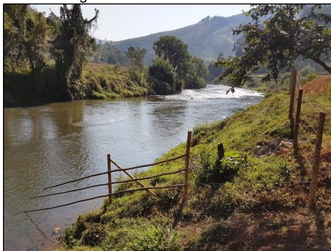
Foto 144: Reconformação e recuperação dos taludes marginais
