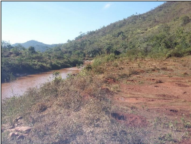
Foto 183: Área com problemas de drenagem
