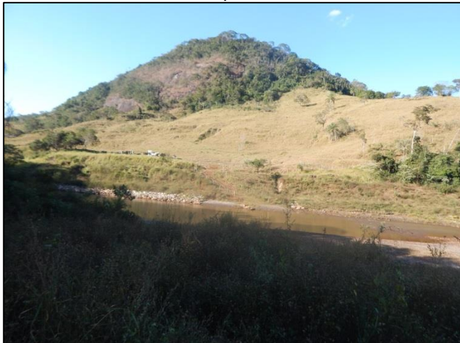
Foto 92: Sedimentos depositados em seu leito
