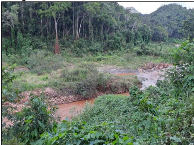
Foto 191: Ilha de rejeito, com ações de bioengenharia
