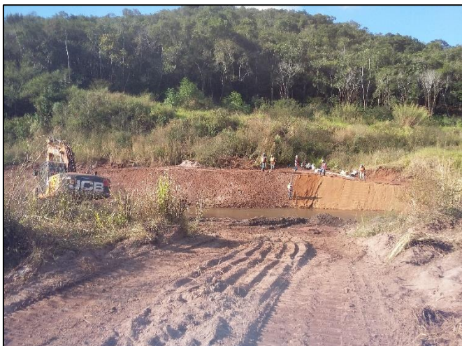
Foto 19: Trabalhos de bioengenharia na margem direita
