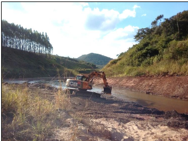
Foto 17: Máquina trabalhando na reconformação do talude
