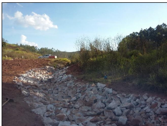
Foto 20: Canaleta de drenagem/tributário no ponto
