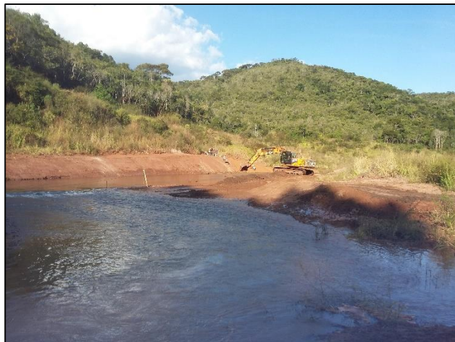
Foto 18: Máquina trabalhando na reconformação do talude
