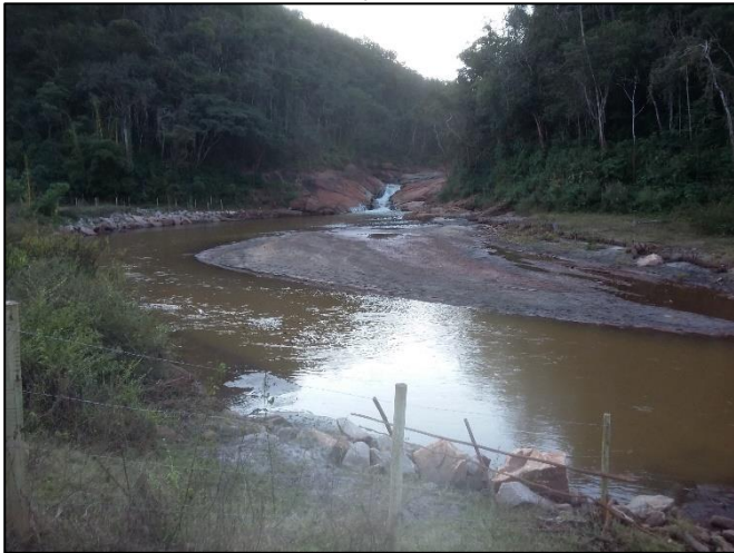
Foto 204: Queda d'água no início do trecho, evidenciando a ilha de rejeito
