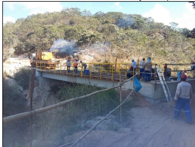
Foto 16: Trabalhos de reconstrução da ponte
