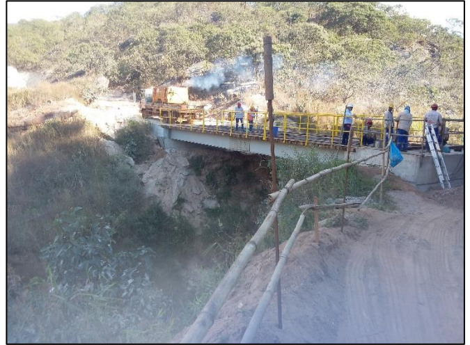
Foto 15: Trabalhos de reconstrução da ponte
