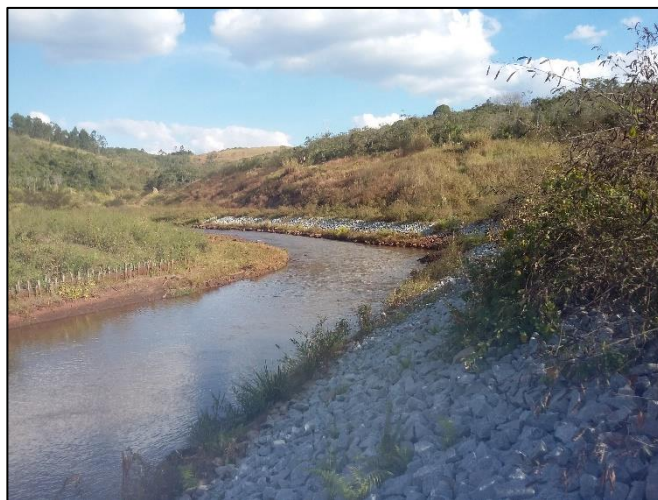
Foto 2: Enrocamento nas margens
