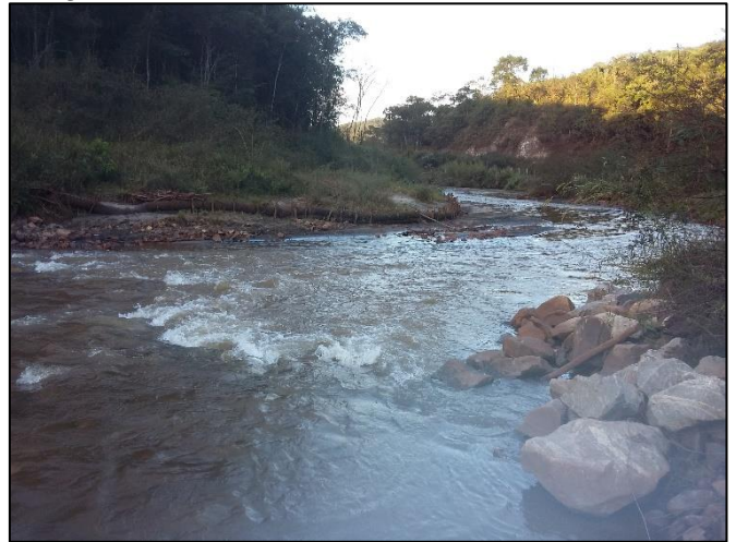
Foto 205: Bermalongas e enrocamento das margens
