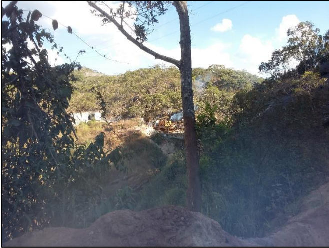
Foto 14: Trabalhos de reconstrução da ponte
