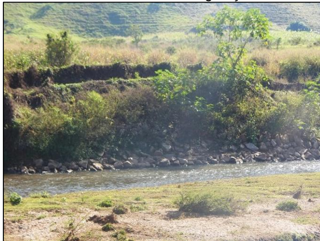
Foto 142: Enrocamento com vegetação
