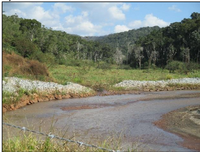
Foto 135: Detalhe do enroncamento e banco de rejeito
