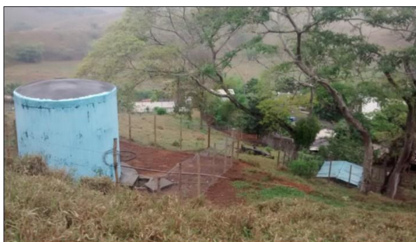
Foto 16: Vista parcial da localidade de Gesteira e do reservatório de água para distribuição, em novembro de 2017.
