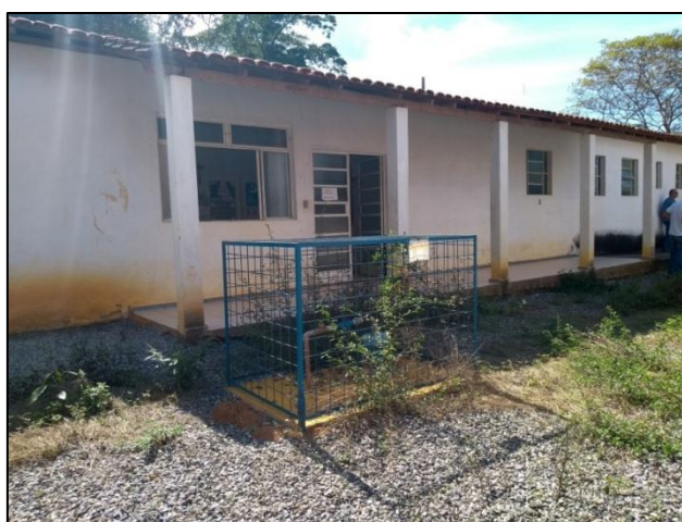
Foto 18: Vista para o poço perfurado pela Fundação Renova na área da Unidade Primária de Saúde.
