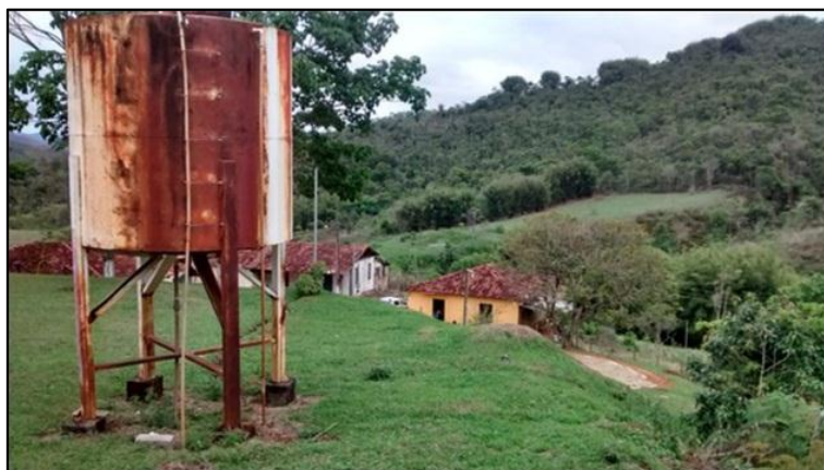
Foto 9: Reservatório elevado de água, situado próximo à igreja.
