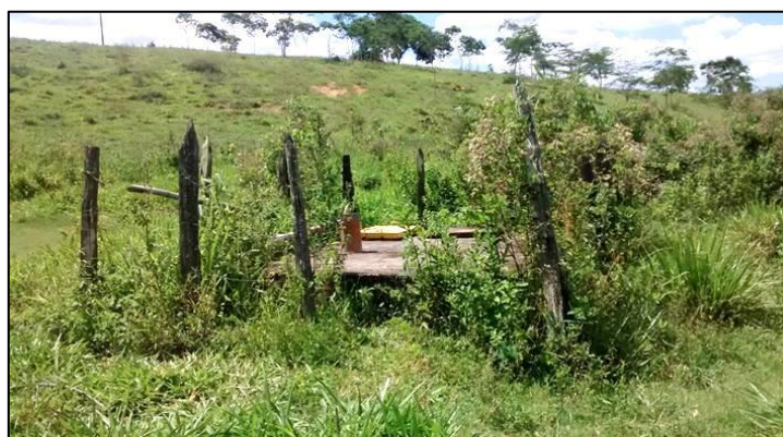
Foto 97: Poço raso, atualmente desativado.
