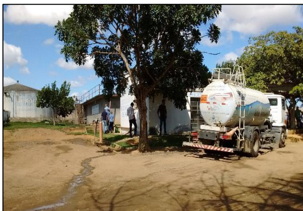
Foto 72: ETA de Santo Antônio do rio Doce sendo abastecida com água tratada por meio de caminhão-pipa a partir da ETA de Aimorés.
