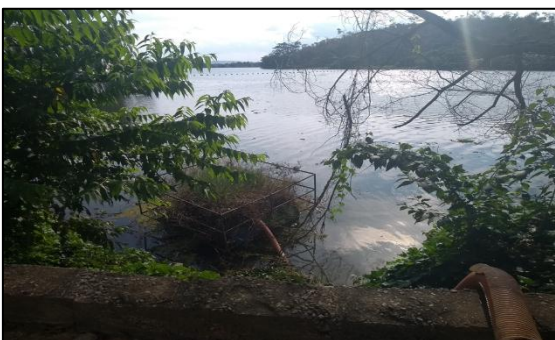
Foto 82: Local de captação no rio Doce (área de remanso da UHE Mascarenhas).
