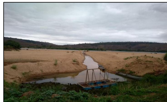
Foto 95: Desvio do fluxo de água para o ponto da captação no rio Doce, no bairro Columbia.
