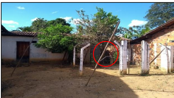
Foto 29: Vista do poço tubular, destaque em vermelho, que atualmente abastece a localidade.
