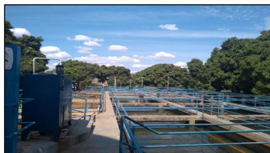
Foto 77: Vista parcial da Estação de Tratamento de Água da Sede.
