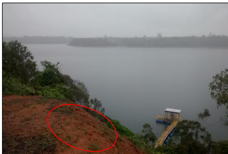
Foto 100: Local da instalação da subestação, às margens da lagoa Nova. Em destaque, locais que há necessidade de estabilização de taludes (Novembro de 2017).
