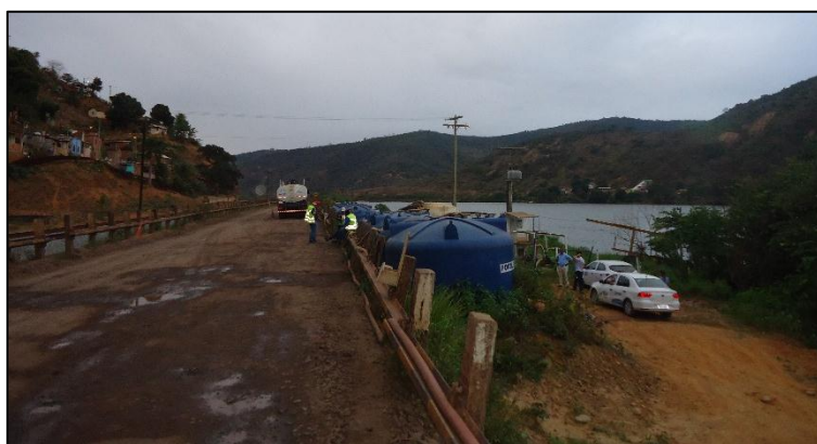
Foto 65: Vista da área da antiga captação no rio Doce onde encontram-se os reservatórios de água bruta abastecidos por caminhão-pipa.
