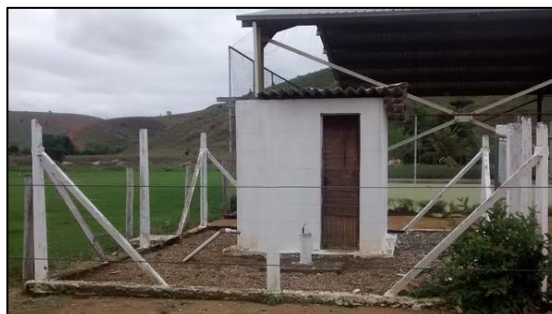
Foto 30: Poço desativado, perfurado com recurso da FUNASA, próximo ao ginásio.
