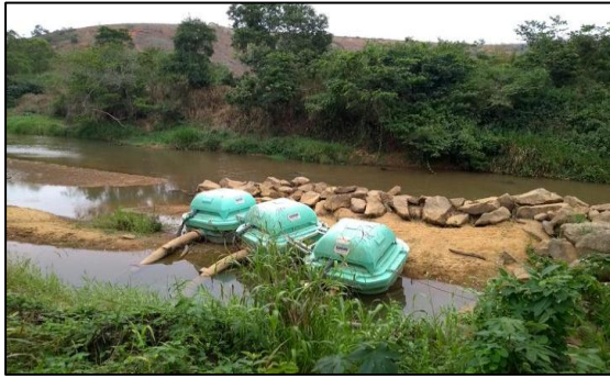
Foto 92: Deposição de sedimentos no local da captação alternativa no rio Pancas, em agosto de 2018.
