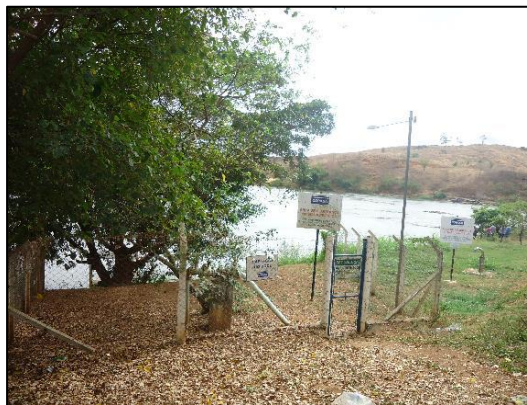
Foto 52: Poço Tubular, Captação Alternativa, fora de operação, adjacente à captação do Rio Doce.
