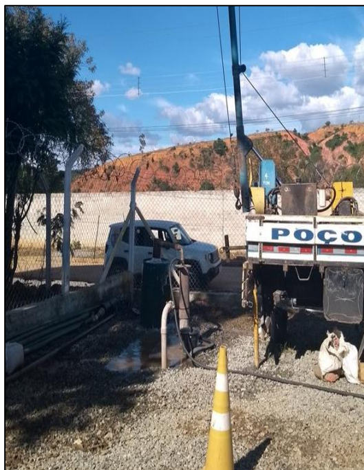
Foto 24: Poço profundo perfurado na área da ETA e sua revitalização e teste de vazão, em agosto de 2018.
