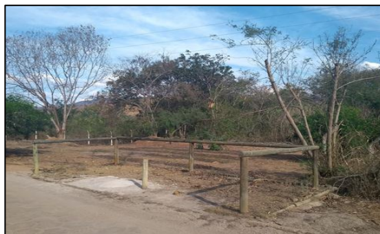
Foto 81: Construção do poço profundo perfurado pela SAMARCO em 2015.
