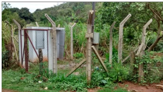
Foto 1: Local onde ocorria a captação de água, em poço subterrâneo (atualmente desativado).
