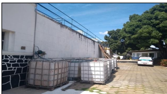
Foto 76: Armazenamento do coagulante Tanfloc SG.
