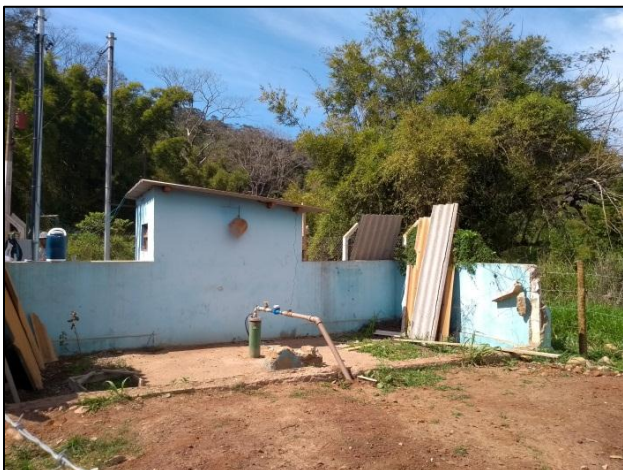
Foto 14: Intervenções na área do poço tubular.
