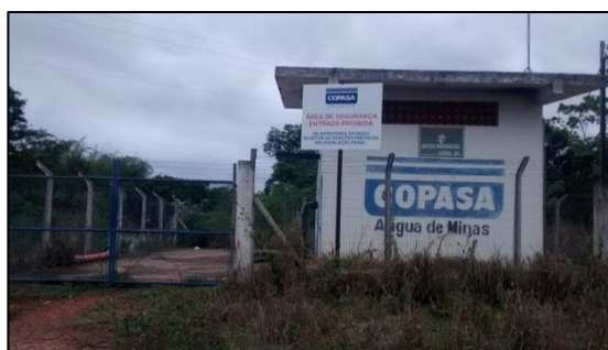
Foto 38: Elevatória de água bruta.
