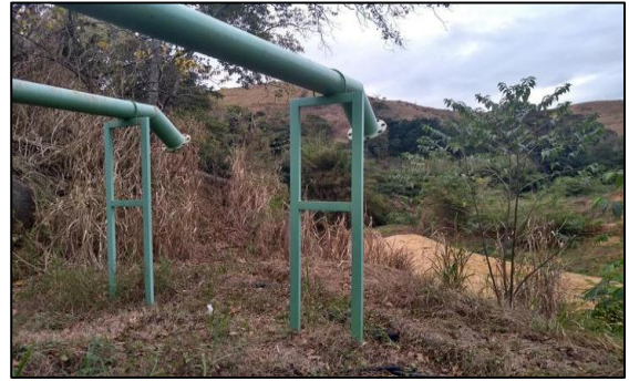
Foto 87: Desmobilização do sistema de captação alternativa no rio Santa Maria do Doce.
