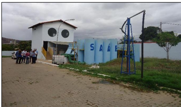
Foto 41: Vista da ETA Santa Rita em Governador Valadares.
