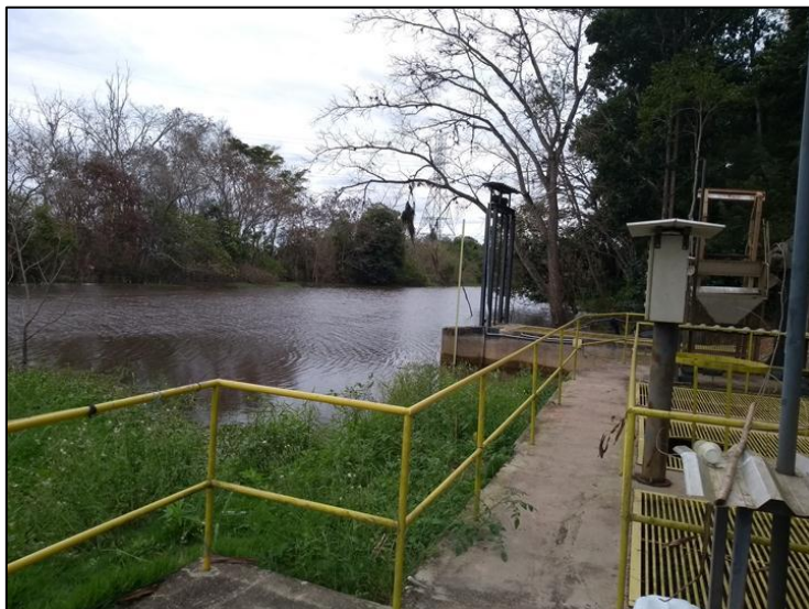
Foto 99: Aumento da lâmina d'água do rio Pequeno no local de captação de água (agosto de 2018).
