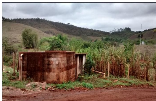
Foto 11: Sistema de reservação de água de Paracatu de Baixo.
