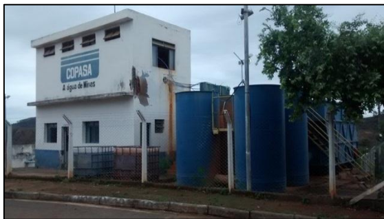
Foto 35: Vista parcial da Estação de Tratamento da Sede de Alpercata.
