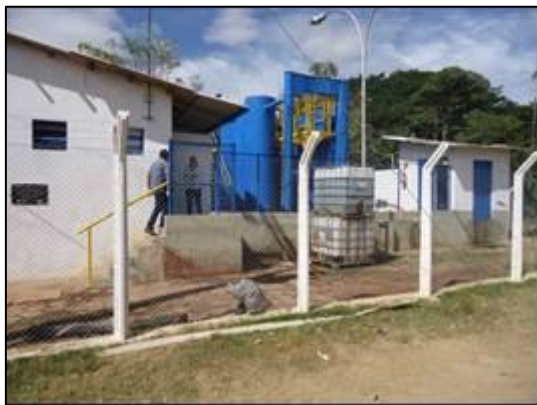
Foto 43: Vista da Estação de Tratamento de Água de São Vitor.
