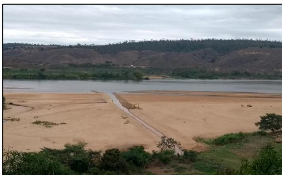
Foto 94: Desvio do fluxo de água para o ponto da captação no rio Doce, no bairro Columbia.
