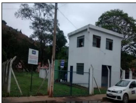
Foto 27: Vista externa da Estação de Tratamento de Água.
