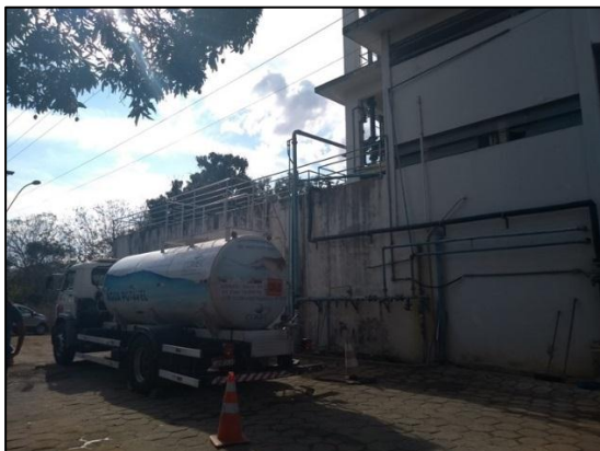
Foto 78: Abastecimento de água tratada na ETA Mascarenhas por meio de caminhão-pipa (a água é tratada na ETA Sede de Baixo Guandu).
