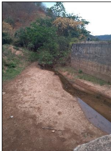
Foto 64: Vista do Córrego Santaninha
