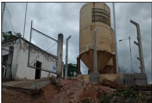
Foto 70: Vista para o reservatório de água tratada localizado em Quatituba.
