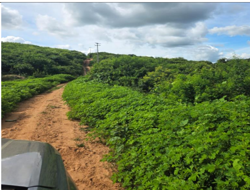
Foto 36: Visada de Estrada Vicinal de Conexão Entre Santa Quitéria e Monsenhor Tabosa – Altura de Serrote Branco.
