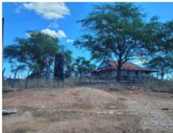
Figura 8.3-233 - Edificação de alvenaria (AMPLO, 2023)
