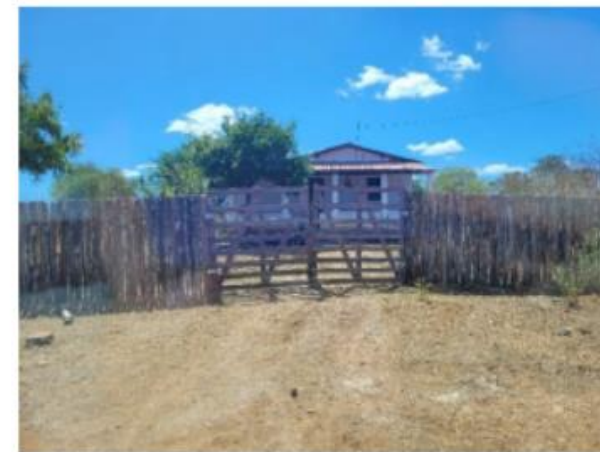
Figura 8.3-234 - Edificação de Alvenaria (AMPLO, 2023)
