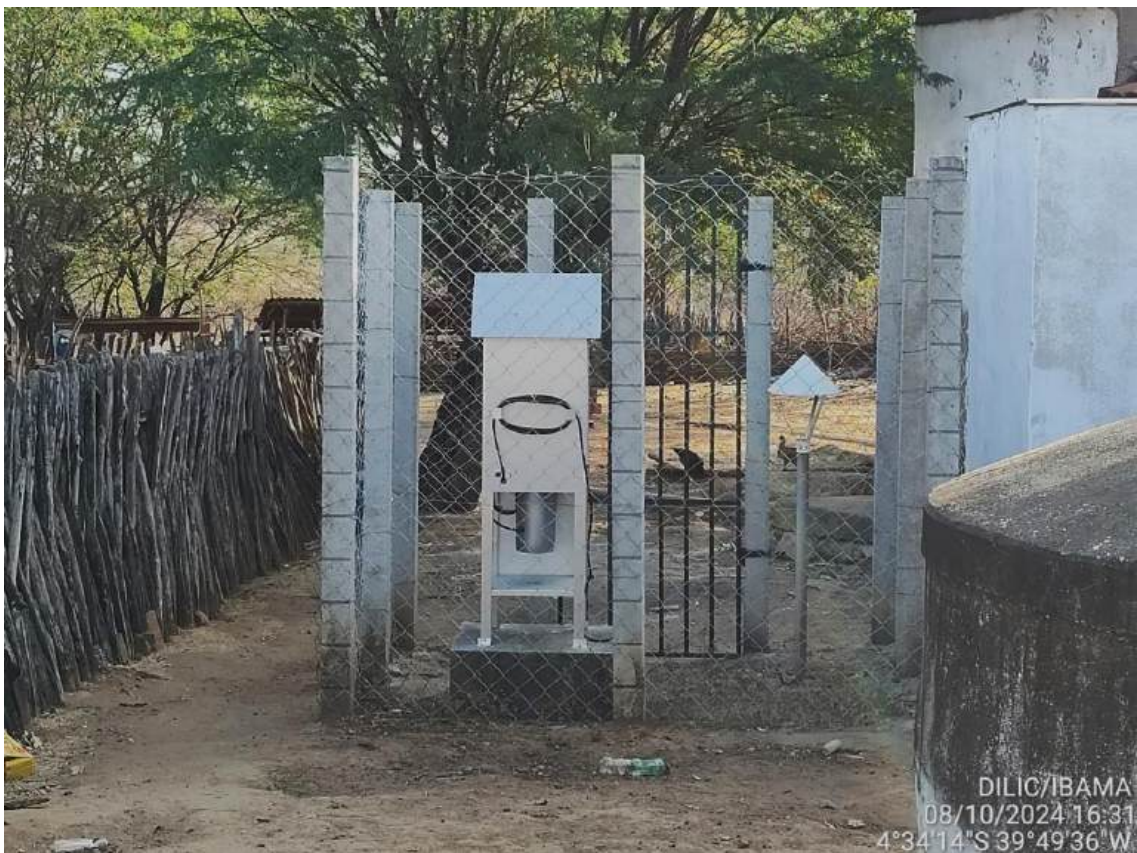
PMS 02-4 – Equipamento de monitoramento da qualidade do ar instalado no Assentamento Morrinhos.
