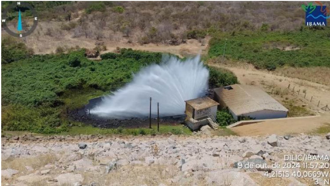
PMB 5-5 – Vertedouro do açude Edson de Queiroz.
