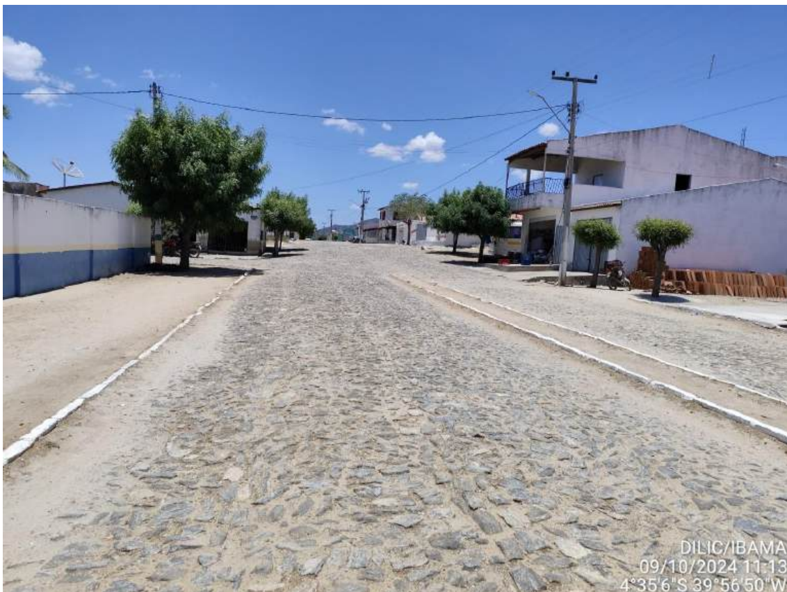
PMS 05-1 – Sede do distrito Riacho das Pedras (Santa Quitéria/CE).
