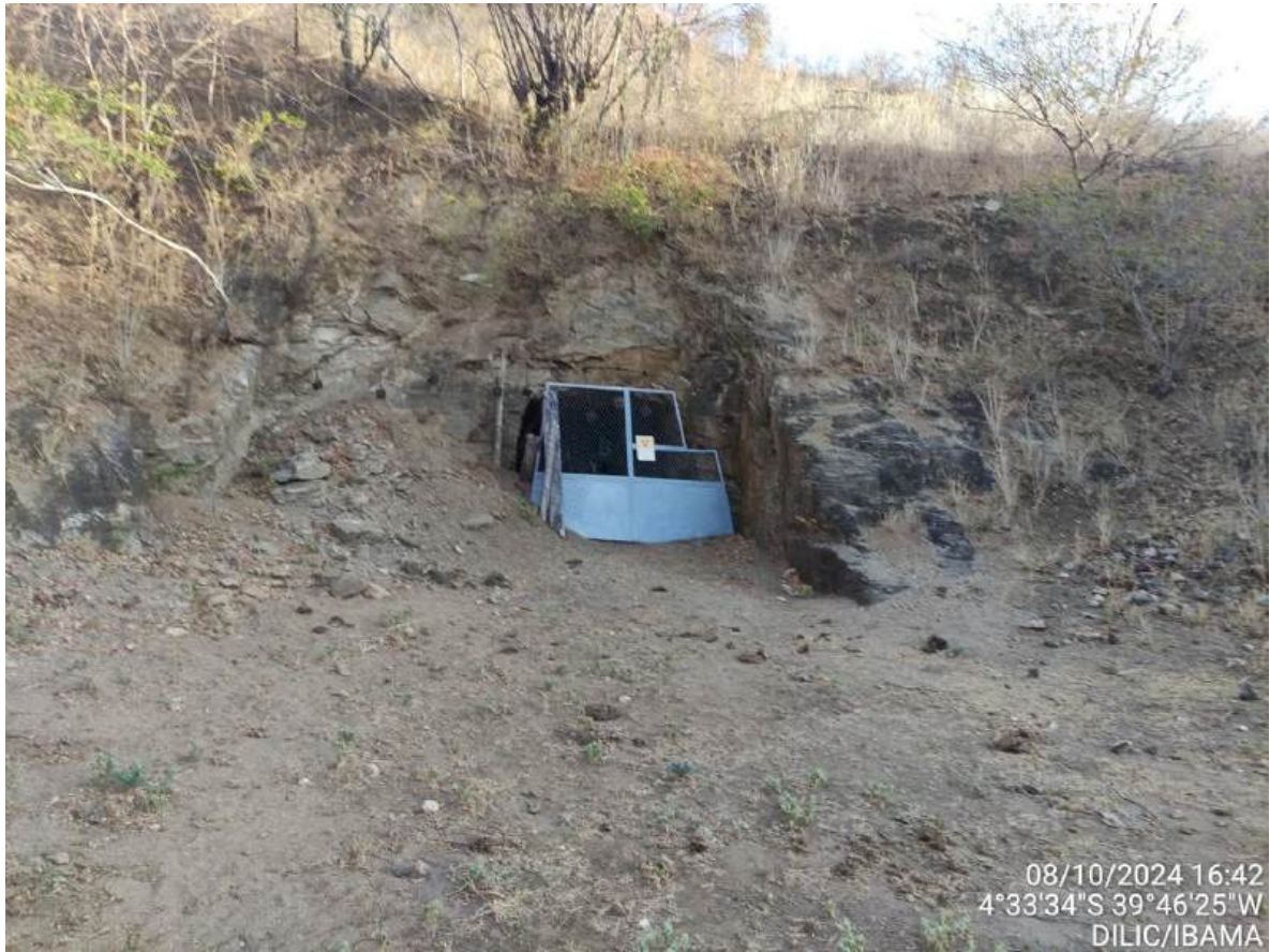
PMF 11 – Entrada da Galeria 01.
