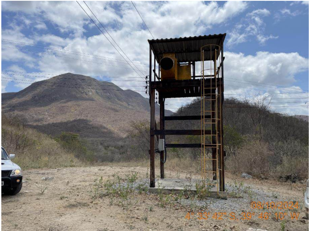
PMF01-3 – Entrada da Galeria 3.
