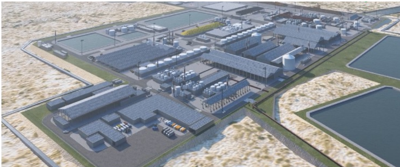
Área industrial, com destaque em primeiro plano, no quadrante inferior, da Instalação Nuclear
