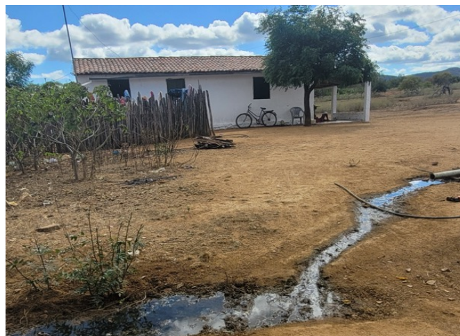
Esgoto a Céu Aberto na Comunidade Embrapa (PA Saco do Belém)
