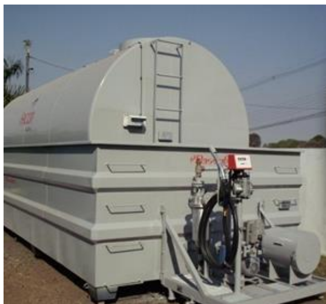
Figura 9.8-2: Tanque aéreo de combustível (Fonte: LOVATEL, 2014).
