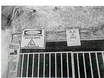
Fotografia 24: Entrada da Galeria 3.
