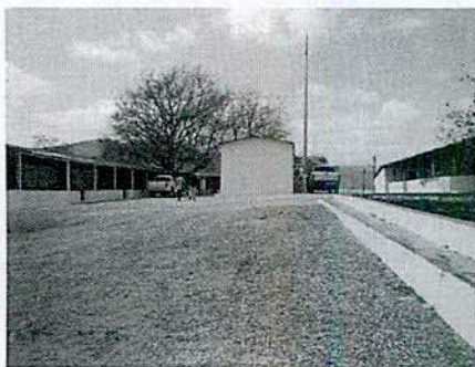
Fotografia 3: Sede da INB na Fazenda Itataia.
