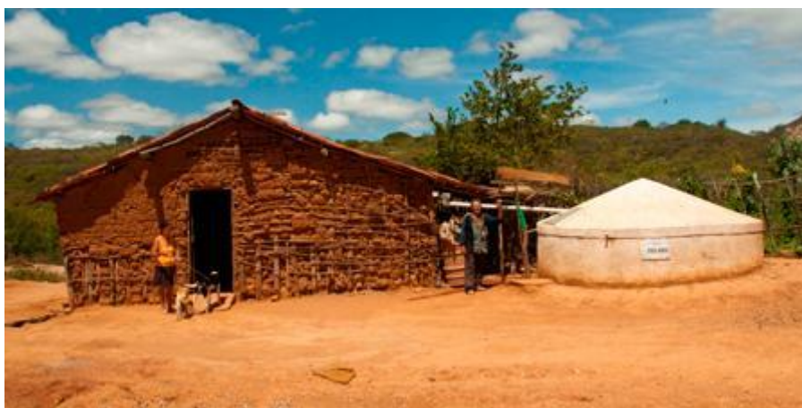
Figura 2 - Cisterna de placa.
