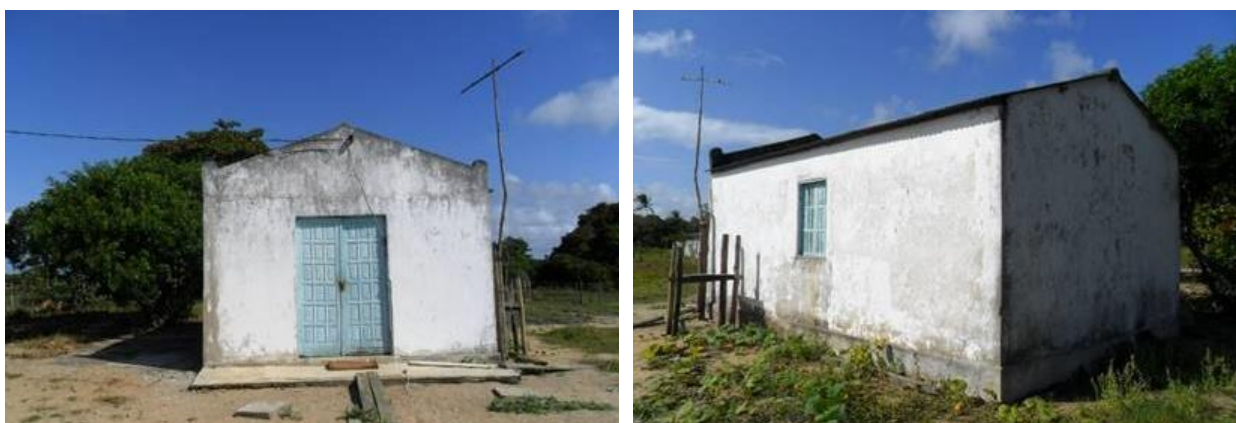
FOTO 65. Igreja de Nossa Senhora Aparecida.
