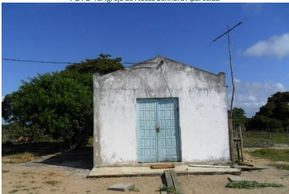
FOTO 46. Igreja de Nossa Senhora Aparecida
