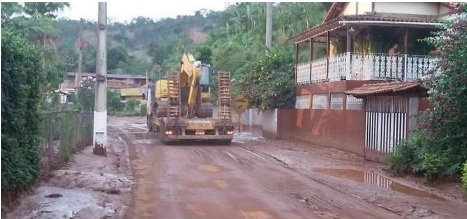
Foto 33 - Maquinário pesado na via pública de Barra Longa/MG
