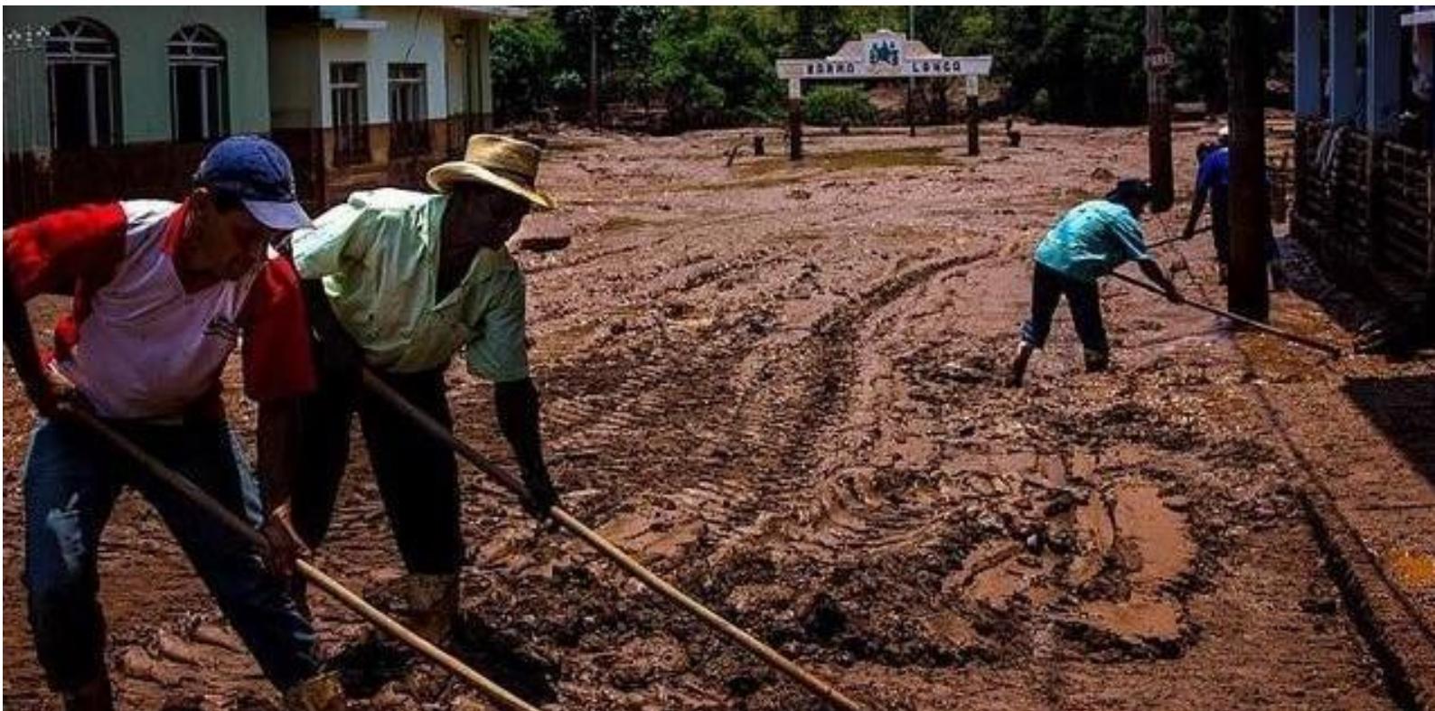
Foto 21 - Limpeza da Lama de Rejeito realizada por moradores na via pública em Barra Longa/MG Fonte: http://engeas.com.br
