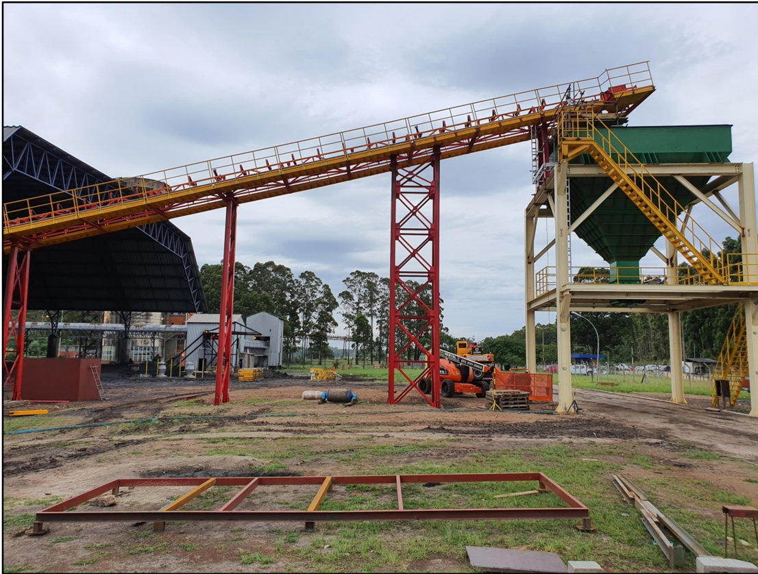
Silo de rejeito:
