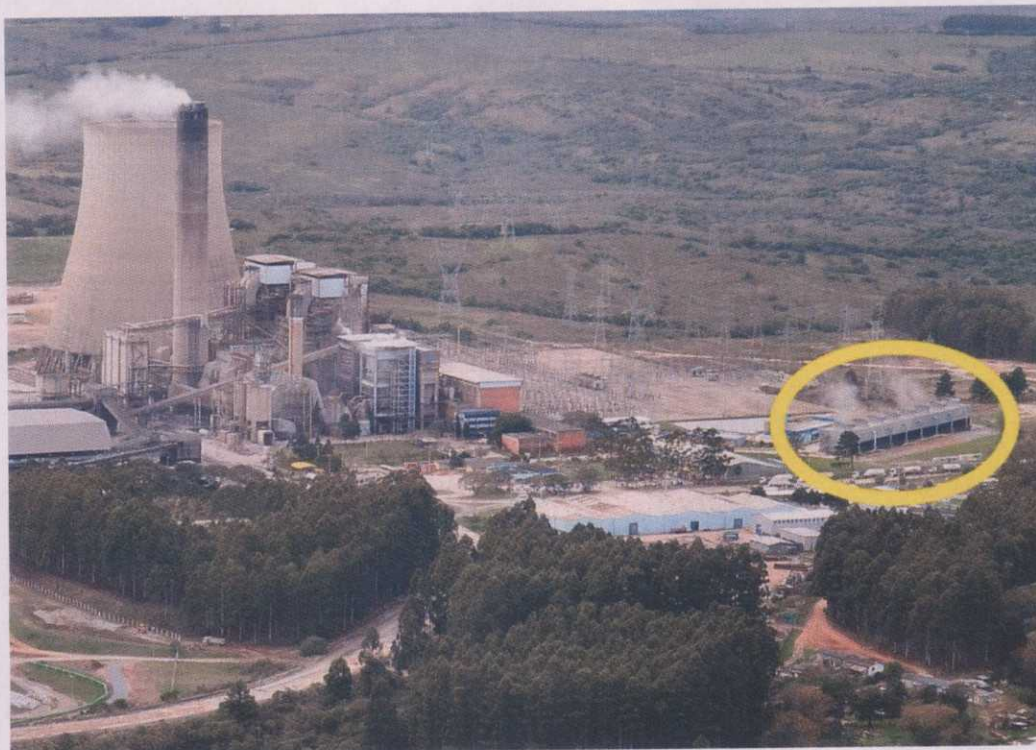
Figura 1. Vista aérea da UPME, em destaque a torre de resfriamento após a recapitação.
