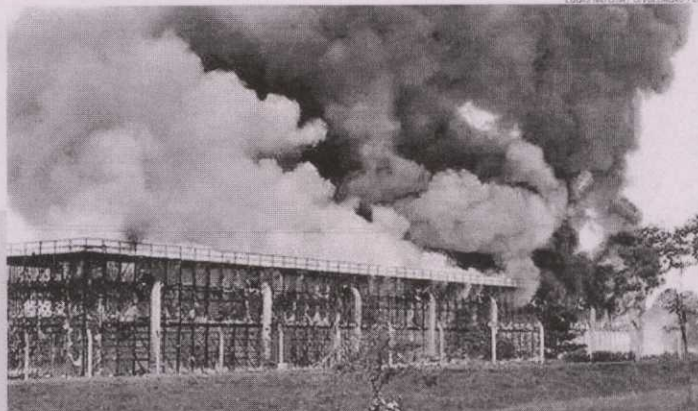
CGTEE, do sistema Eletrobras, informa que a torre de resfriamento evaporativo da Fase A da usina foi danificada
