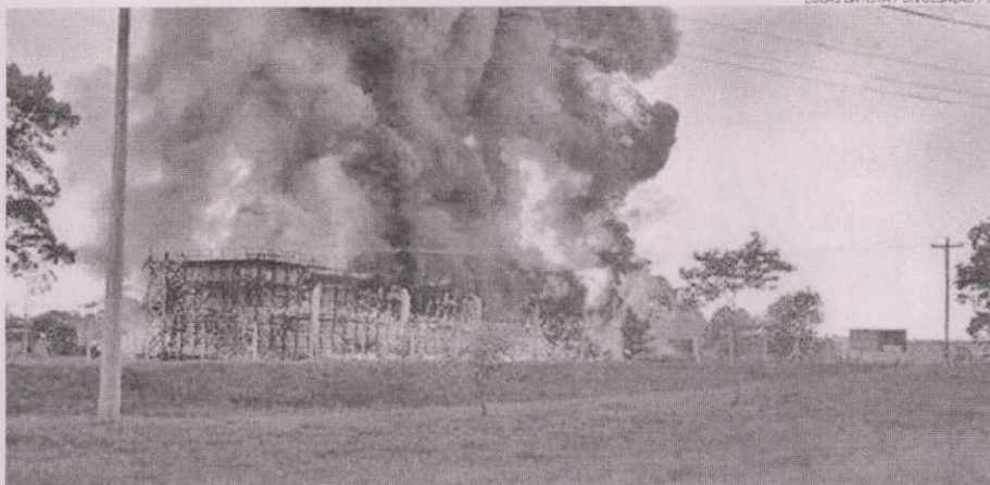
Fogo, controlado pelos bombeiros, causou danos na estrutura da Usina Presidente Médici, da Eletrobras CGTEE
