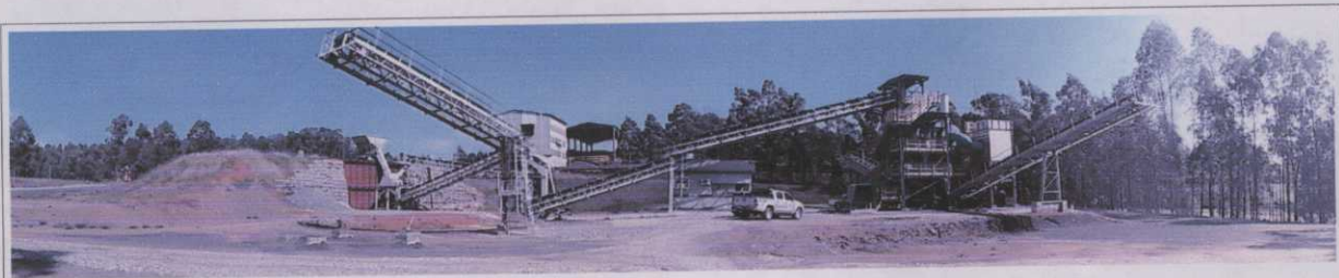
Figura 1A – Planta de beneficiamento de carvão mineral por Jigagem a Ar
