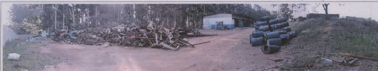
Figura 12B – Armazenamento inadequado de resíduos sólidos em área externa à Central.
