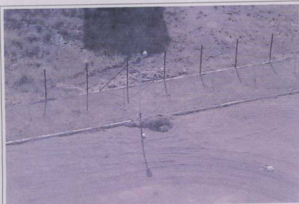
Figura 3A – Presença de poço de monitoramento no pátio do estacionamento. Solicita que seja tamponado e abandonado, já que não há garantia de sua integridade física e representatividade dos dados.
