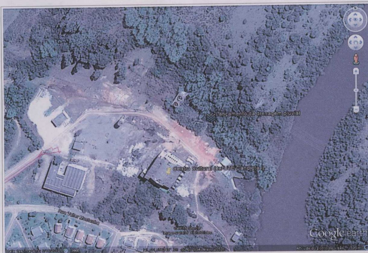
Figura 4D - Vista de cima do lançamento da drenagem pluvial com o Arroio Candiota, a jusante da barragem.
