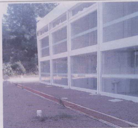
Figura 3B – Poço de monitoramento, na lateral do Centro Cultural Candiota I.
