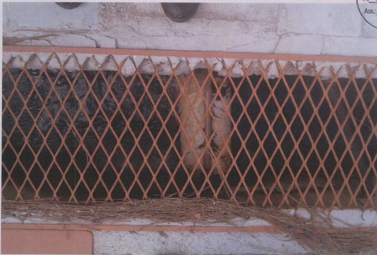
Canal de drenagem do pátio do Centro Cultural, recebendo contribuições de provável lançamento de efluentes domésticos da Vila Residencial.
