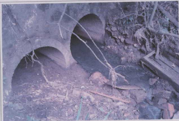
Figura 4B – Ponto de lançamento da drenagem pluvial do Pátio do Centro Cultural Candiota I e local de lançamento do efluente doméstico da Vila Residencial.
