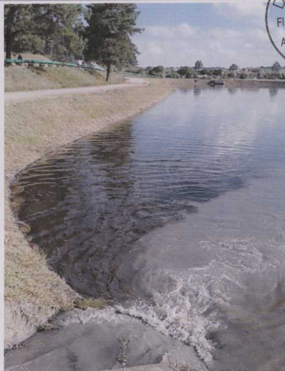
Figura 15B - Bacia de Sedimentação – Presença de pluma de óleo sobrenadante
