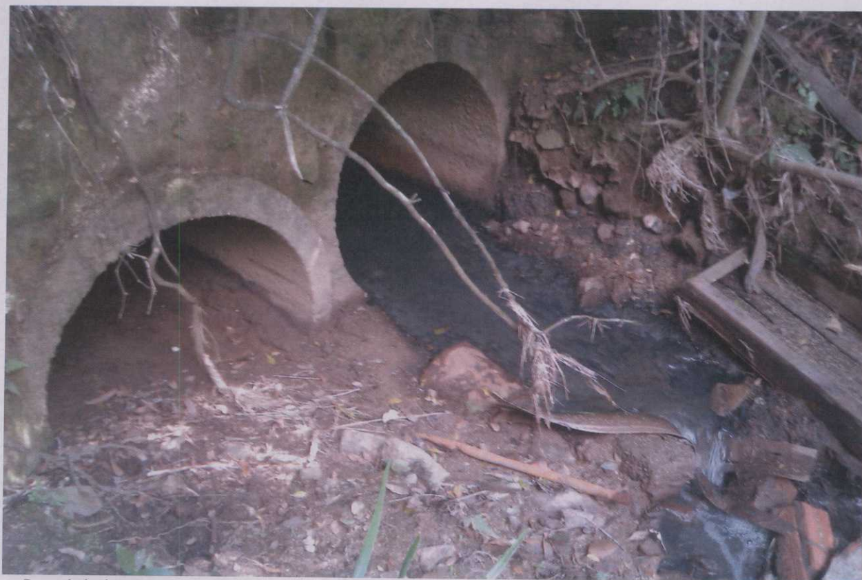
Local de lançamento da drenagem pluvial do Pátio do Centro Cultural e local de lançamento do efluente doméstico da Vila Residencial.
