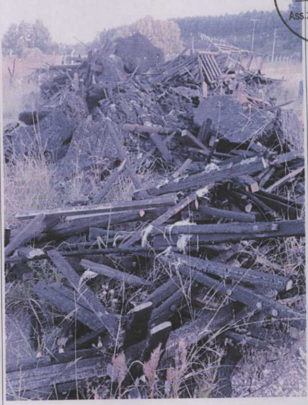
Figura 6B - Resíduo de madeira (não classificada) gerado no acidente com a Torre de Refrigeração
