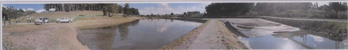
Figura 15A – Sistema de Tratamento de Efluentes Líquidos - Bacias de Sedimentação
