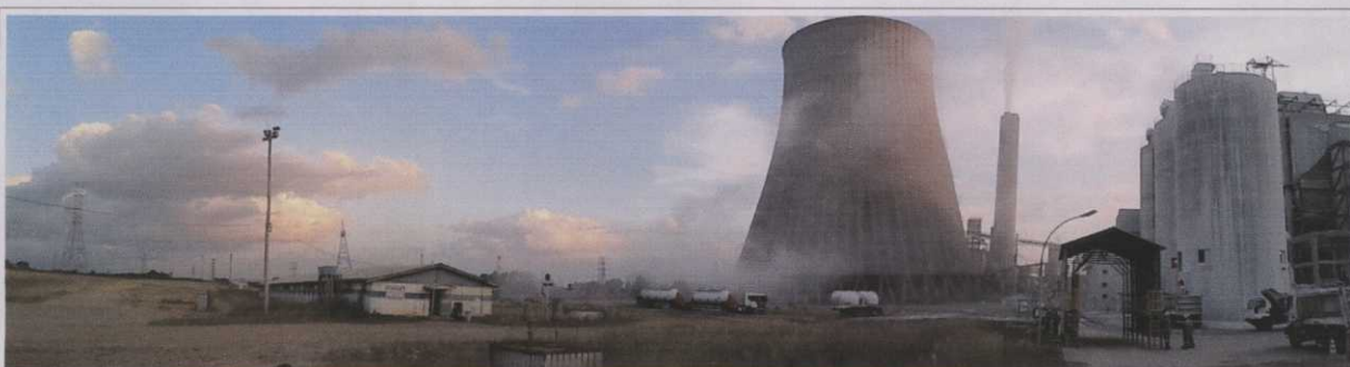
Figura 20A – Emissões Fugitivas – Silos de Estocagem Temporária de Subproduto do FGD
