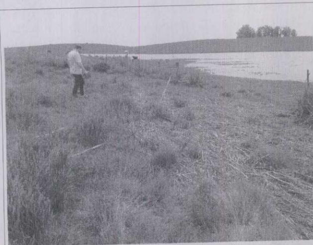
Evidência de ausência de manutenção
