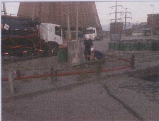
Figura 03. Limpeza permanente de caixas separadoras água/óleo.
