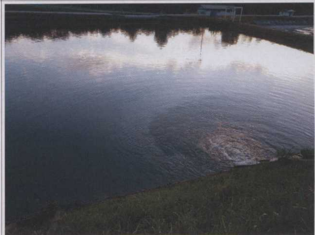
Figura 2 – Pluma de Óleo em efluente líquido da Lagoa de Sedimentação da UTPM
