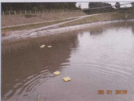
Figura 08. Travesseiros absorventes instalados na Bacia N° 4 como indicador de presença de óleo.
