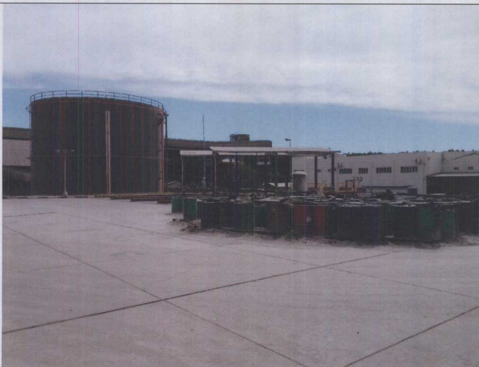
A.10. Armazenamento inadequado de óleo combustível em toneis desprovidos de tamponamento em arruamento interno. Contaminação de pavimento e dispositivo de coleta de drenagem superficial.
