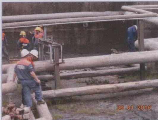
Figura 04. Manutenção e limpeza da válvula e trocador de calor junto ao tanque de óleo combustível.
