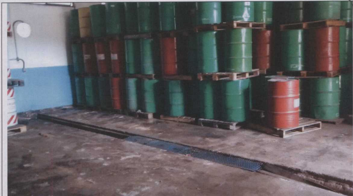
C.2. Seção interna de armazenamento de resíduos Classe I – Perigosos – Compostos Orgânicos; Empilhamento indevido em suporte de madeira em péssimo estado de conservação, sem caixa/bacia coletora. Canaleta de drenagens desprovida de gradeamento com indícios de contaminação. Galpão desprovido de exaustor.
