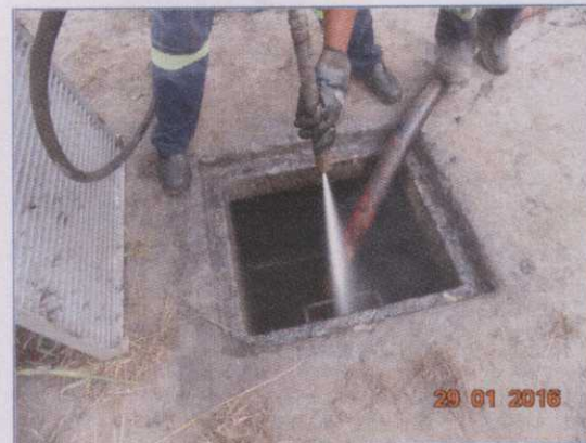
Figura 03. Limpeza permanente de caixas separadoras água/óleo.
