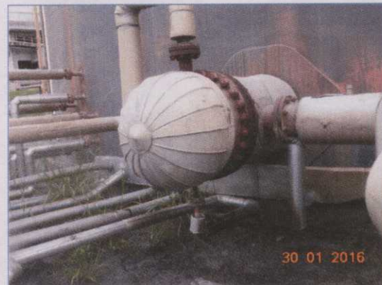
Figura 04. Manutenção e limpeza da válvula e trocador de calor junto ao tanque de óleo combustível.
