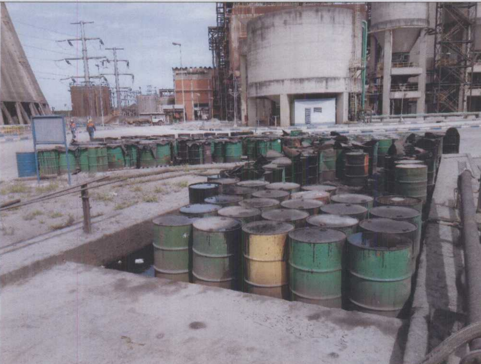
A.8. Armazenamento inadequado de óleo combustível em toneis desprovidos de tamponamento. Contaminação de pavimento e dispositivo de coleta de drenagem superficial.
