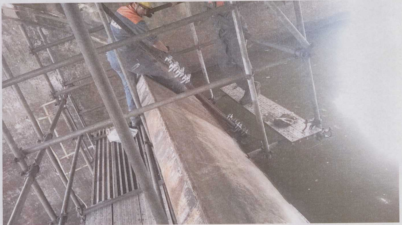
Figura 4: serviços realizados na Comporta 1
