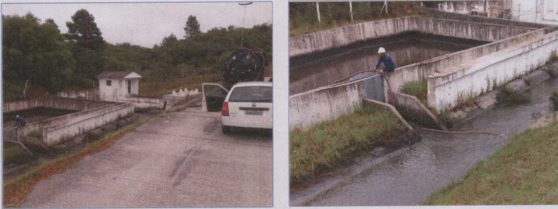
Figura 05. Limpeza das Bacias de Sedimentação.
