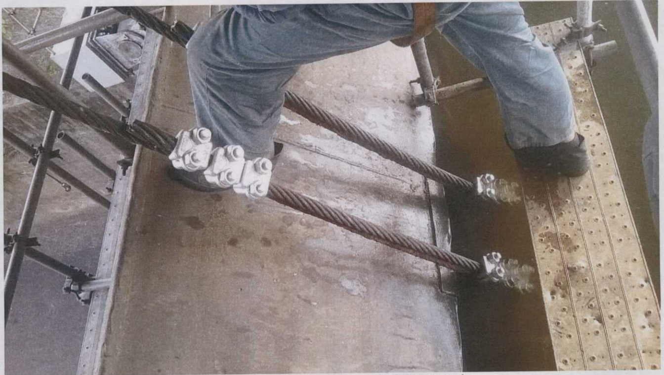
Figura 3: recuperação dos cabos da Comporta 1
