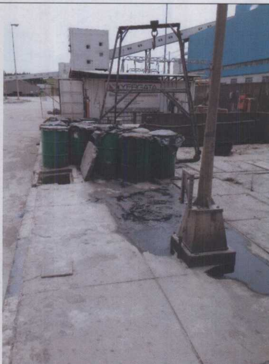
A.3. Armazenamento inadequado de óleo combustível em toneis desprovidos de tamponamento. Contaminação de pavimento dispositivo de coleta de drenagem superficial..
