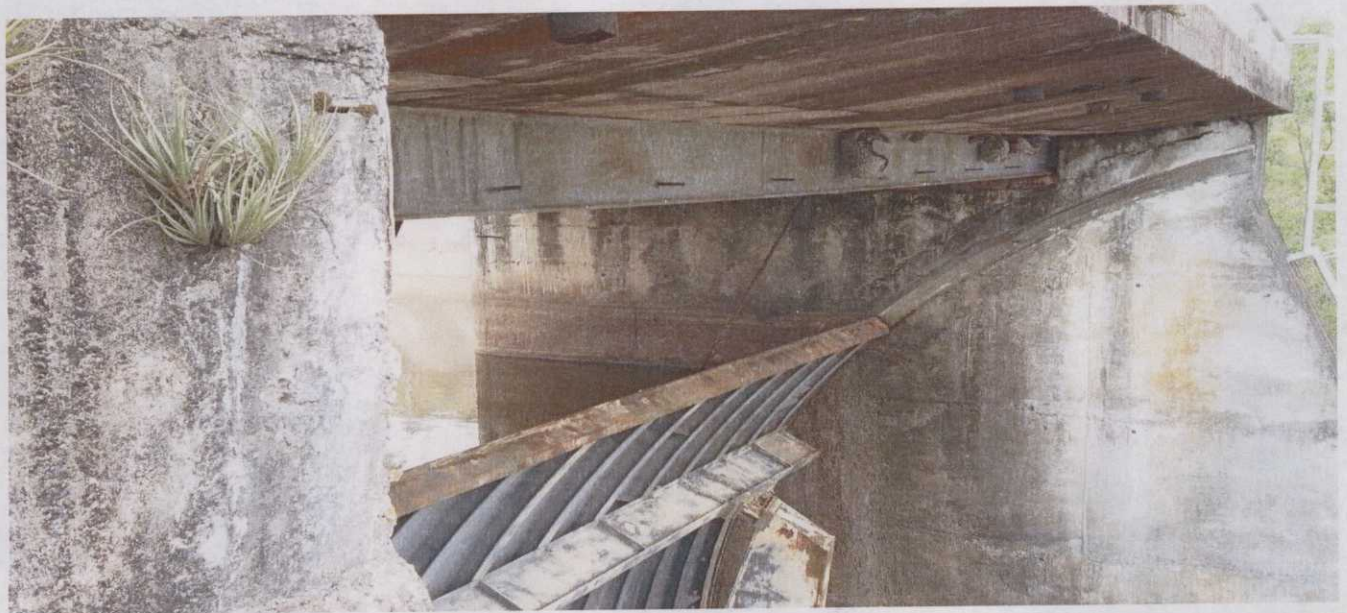
Figura 1: Comporta 1 antes da recuperação parcial dos cabos
