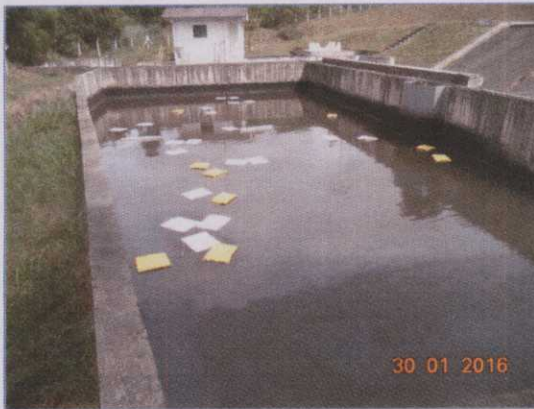
Figura 07. Cordões, travesseiros e mantas absorventes instalados na Saída do STE.
