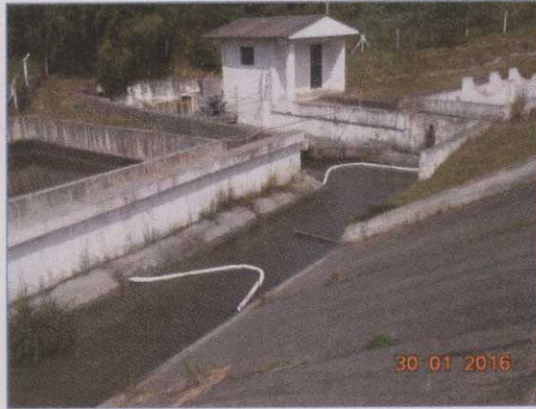
Figura 07. Cordões, travesseiros e mantas absorventes instalados na Saída do STE.
