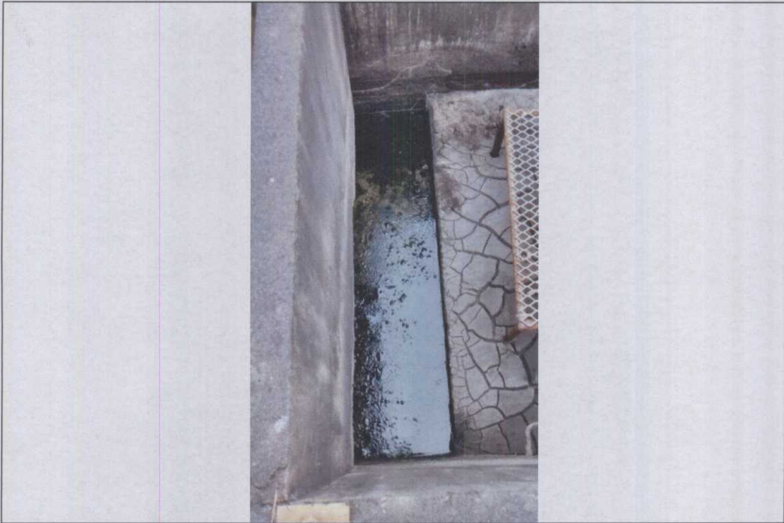
B.3. Coletor de fração oleosa em Bacia de Sedimentação
