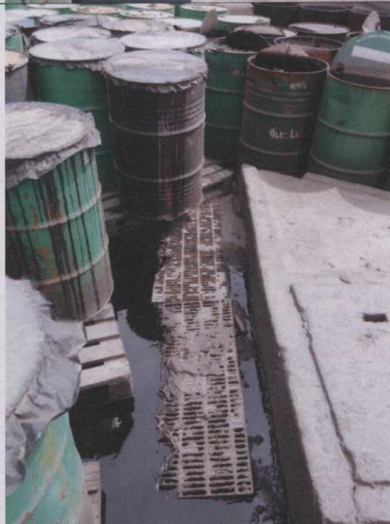
A.9. Vazamento de Óleo Combustível. Contaminação de pavimento e dispositivo de coleta de drenagem superficial de arruamento interno.
