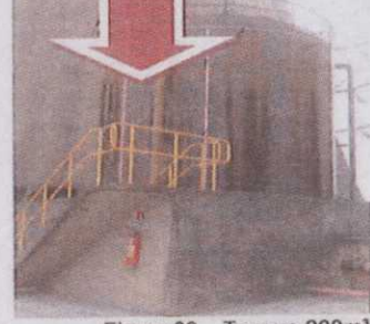
Figura 08 – Tanque 200m³ Fase B
