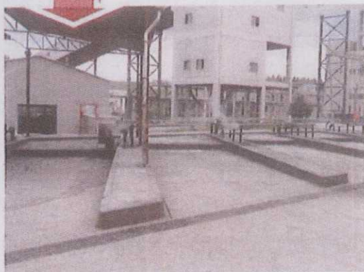
Figura 03 – Baías de recebimento de F.O. dos caminhões
