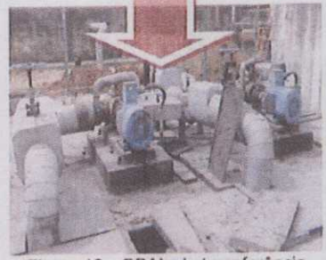
Figura 12 – BBA's de transferência
