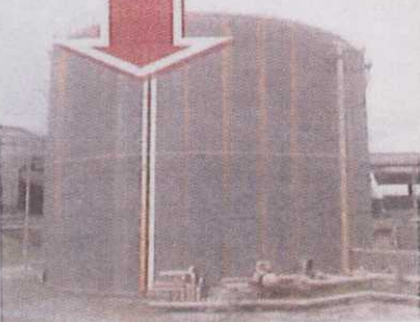
Figura 06 – Tanque de 5000m³
