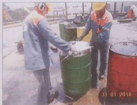
Figura 14. Fechamento dos tambores contendo resíduos oleosos com o uso de cintas metálicas.
