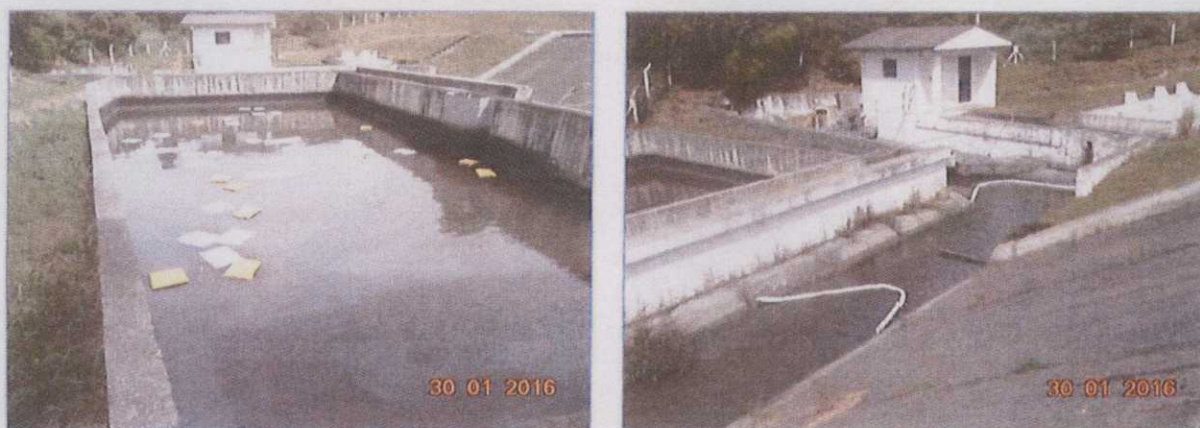
Figura 13. Cordões, travesseiros e mantas absorventes instalados na Saída do STE.
