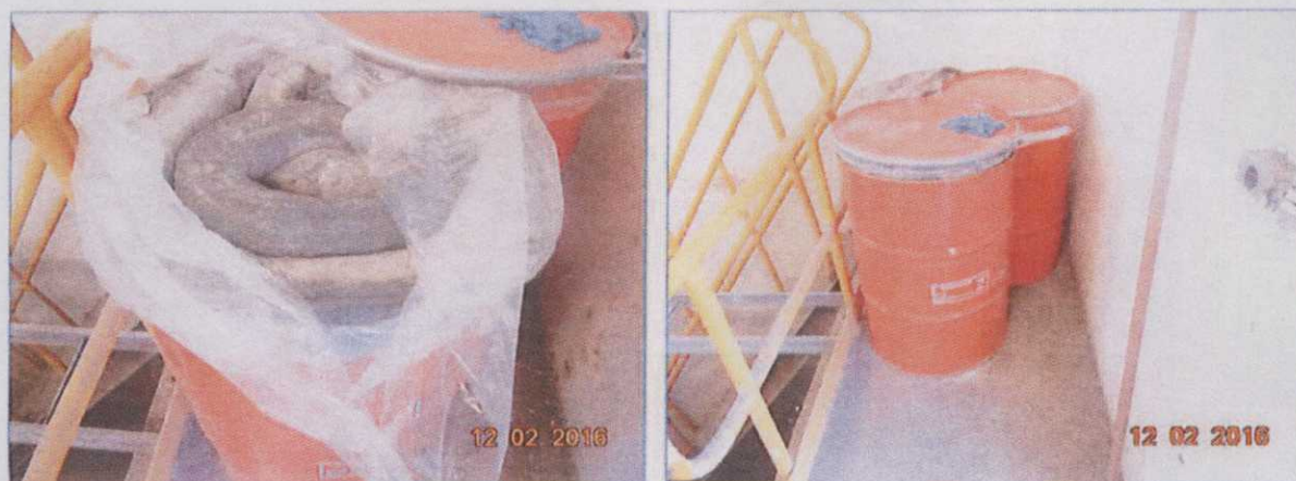
Figura 21. Recolhimento e acondicionamento de material absorvente saturado.
