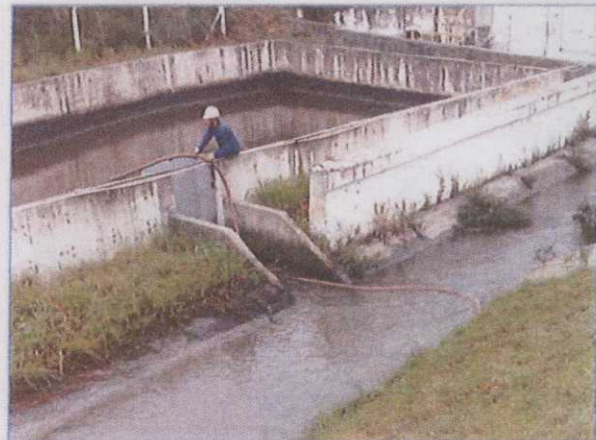
Figura 11. Limpeza das Bacias de Sedimentação.
