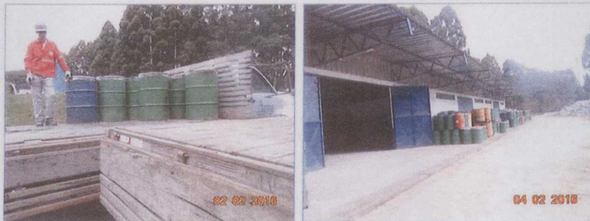
Figura 17. Descarga dos tambores contendo resíduos oleosos na Central de Resíduos.
