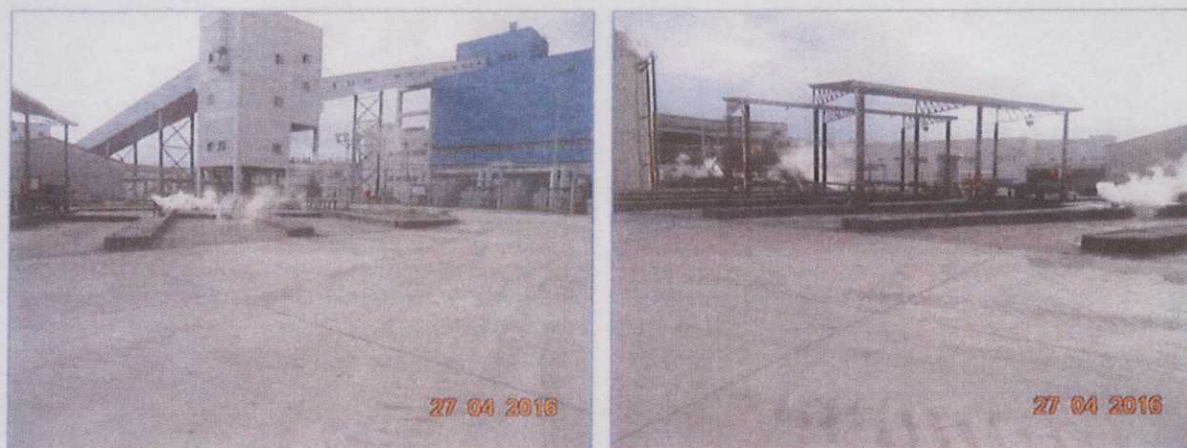
Figura 29. Manutenção da área limpa sem a presença de tambores e resíduos oleosos.
