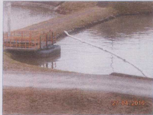
Figura 27. Utilização de barreira absorvente na Bacia de Sedimentação N° 3.
