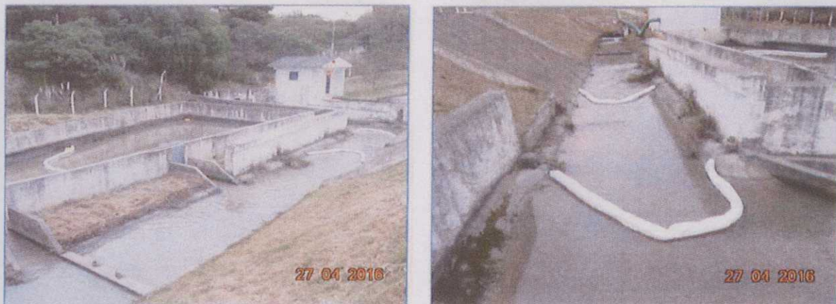
Figura 26. Utilização permanente de barreira absorvente junto as Bacias de Sedimentação.
