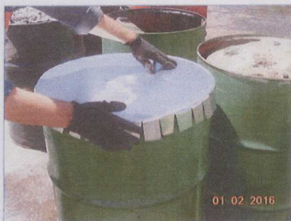
Figura 15. Fechamento dos tambores contendo resíduos oleosos com o uso de cintas metálicas.
