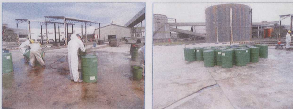
Figura 08. Limpeza dos tambores com resíduo oleoso.
