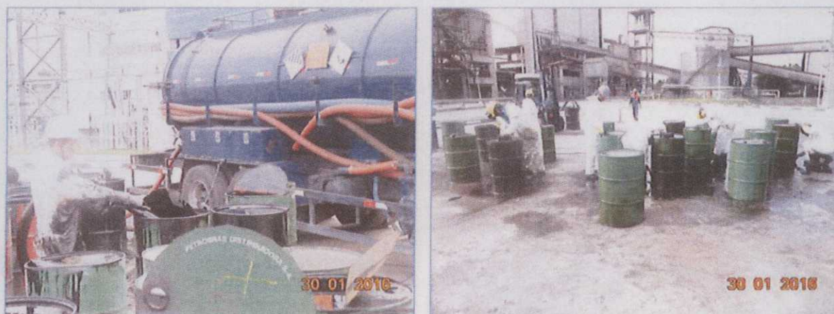
Figura 07. Esvaziamento e limpeza dos tambores contendo resíduos oleosos.
