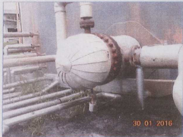
Figura 10. Manutenção e limpeza da válvula e trocador de calor junto ao tanque de óleo combustível.
