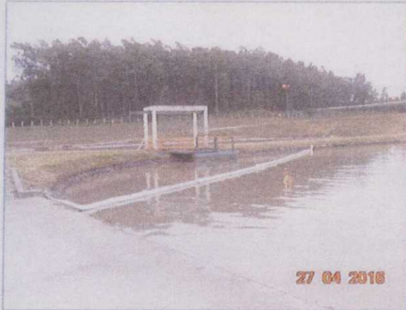
Figura 27. Utilização de barreira absorvente na Bacia de Sedimentação N° 3.
