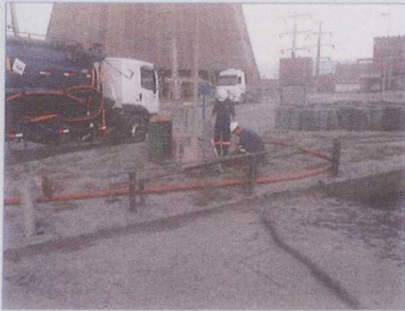
Figura 09. Limpeza permanente de caixas separadoras água/óleo.
