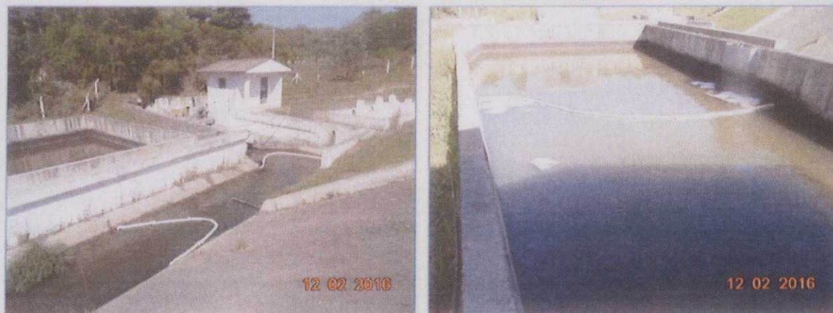
Figura 19. Manutenção da instalação de material absorvente junto as Bacias de Sedimentação.
