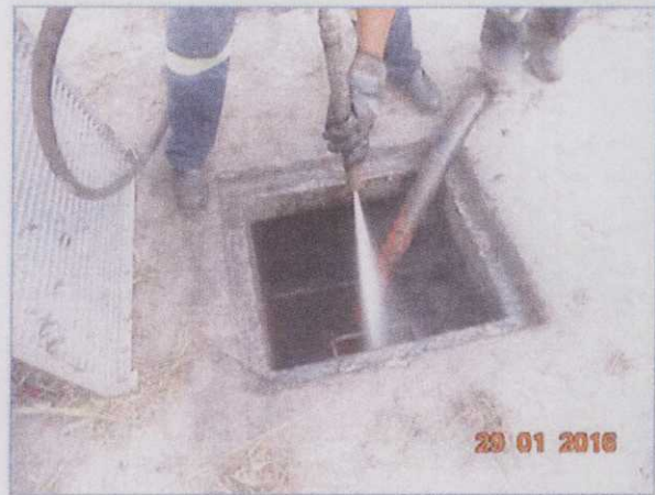
Figura 09. Limpeza permanente de caixas separadoras água/óleo.
