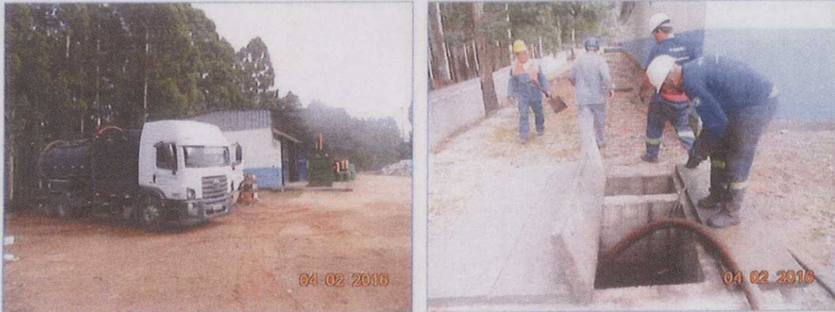
Figura 22. Limpeza da caixa separadora água/óleo na Central de Resíduos.
