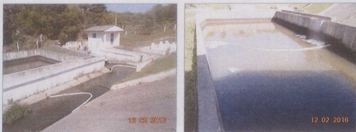
Figura 20. Manutenção da instalação de material absorvente junto as Bacias de Sedimentação.
