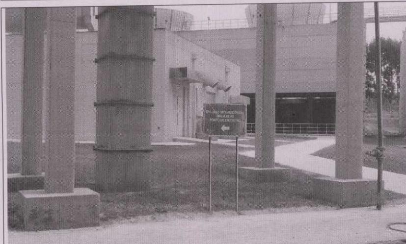
Foto 12: sinalização de indicação que leva ao encontro do ponto nº 06, próximo ao prédio de comando principal – Fase C.
