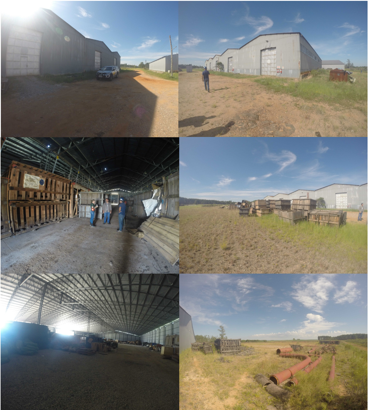
Figura 3. Registros efetuados no área denominada “Candiotão”, onde o Ibama identificou o acondicionamento indevido de resíduos classe I em vistorias anteriores. Evidencia-se que não foi encontrado novas ocorrências. Registra-se o armazenamento temporário de caixas de madeira usadas para acondicionamento de resíduos, que segundo informações fornecidas pelos funcionários, aguardavam manutenção para sua reutilização na planta industrial.
