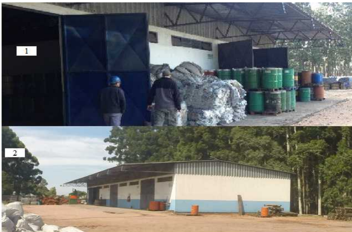
Figura 2. Área de armazenamento temporário de resíduos. Foto 1 de set/16 e foto 2 de jan/17. Constata-se organização e destinação de tambores com resíduos classe I que encontravam-se dispostos fora da área apropriada. Identificação de 5 tambores fora da área adequada.
