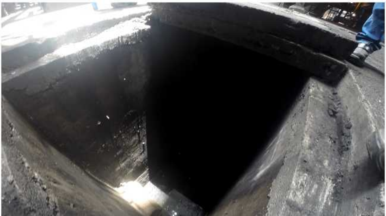
Figura 7. Caixa separadora de Água e Óleo N° 08 que na vistoria anterior estava entupida de cinzas de forma que não permitia a identificação das divisórias que promovem a separação da água e óleo. Construção e manutenção adequada.
