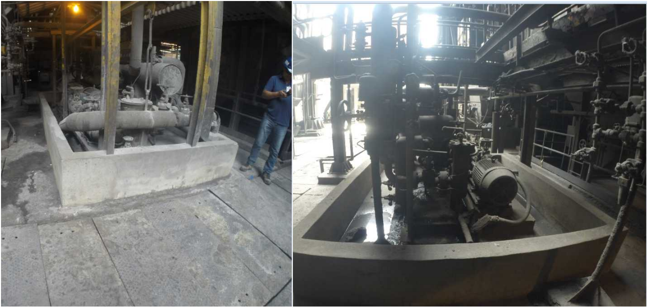
Figura 6. Construção bacias de contenção em instalações de uso e armazenamento de óleo nas áreas de operação das fases A e B.
