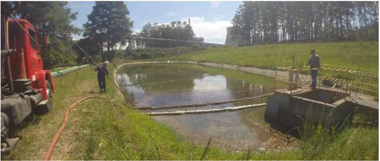
Figura 11. Registro de efluentes contaminados com óleo na bacia de emergência de sedimentação. Registro da atividade de sucção deste material para posterior tratamento.
