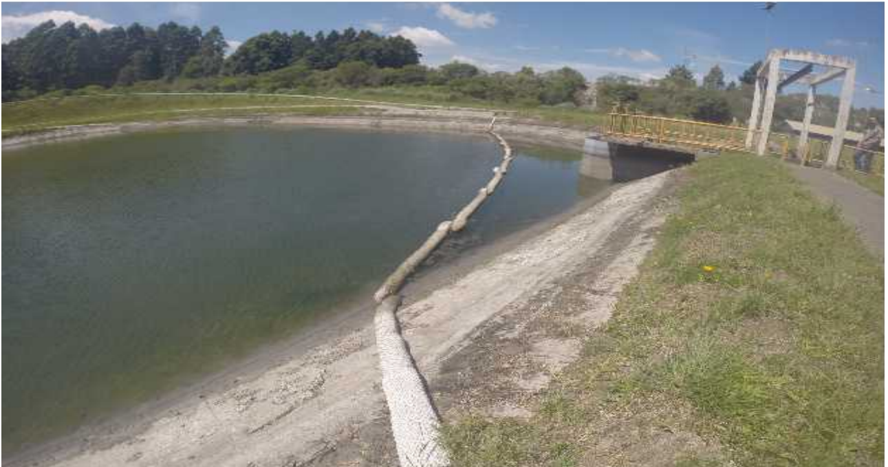
Figura 12. Registro de mantas absorventes instaladas nos pontos de saída das bacias de sedimentação.
