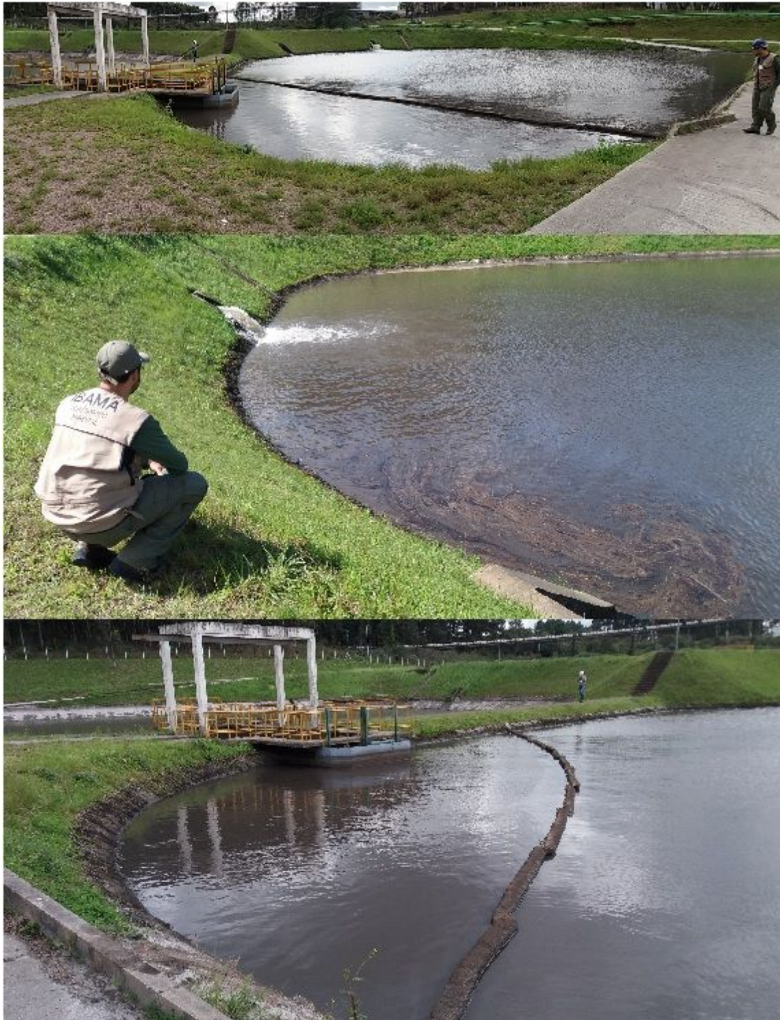
Figura 7. Ponto 2 da figura 1 - Bacias de sedimentação nº 3: Aporte de efluente contaminado com óleo proveniente da bacia nº 1 e barreira absorvente de óleo visualmente saturada
