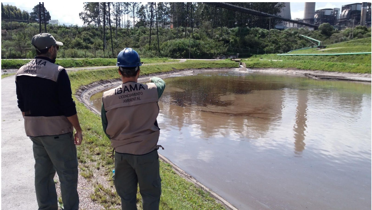
Figura 5. Ponto 2 da figura F1 - Bacia de sedimentação nº 1: Presença de pluma de óleo sobrenadante
