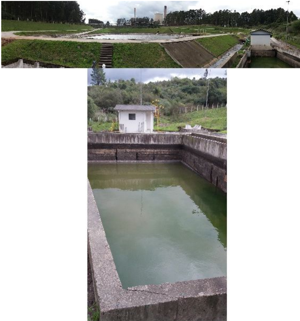
Figura 9. Ponto 4 da figura 1 – Bacia de sedimentação nº 4 e Reservatório de captação do sistema de recirculação de efluentes líquidos (também à direita na foto superior).
