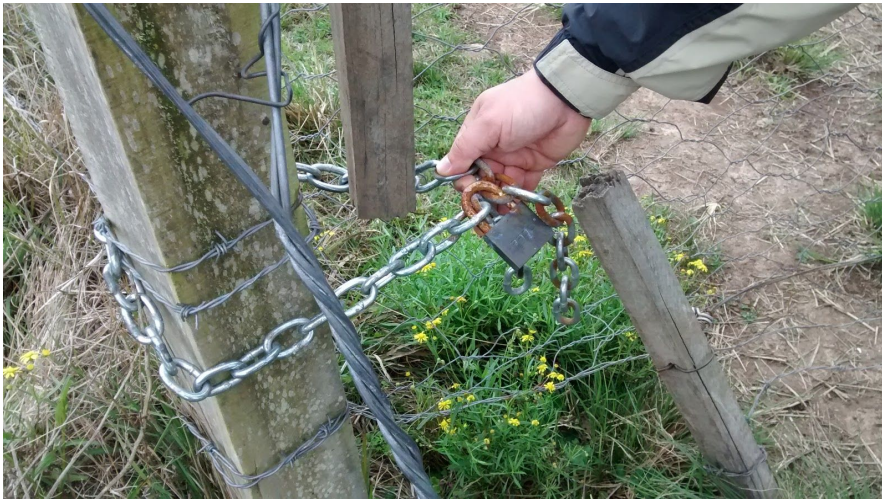
Figura 42. Cerca de divisão das propriedades danificada.
