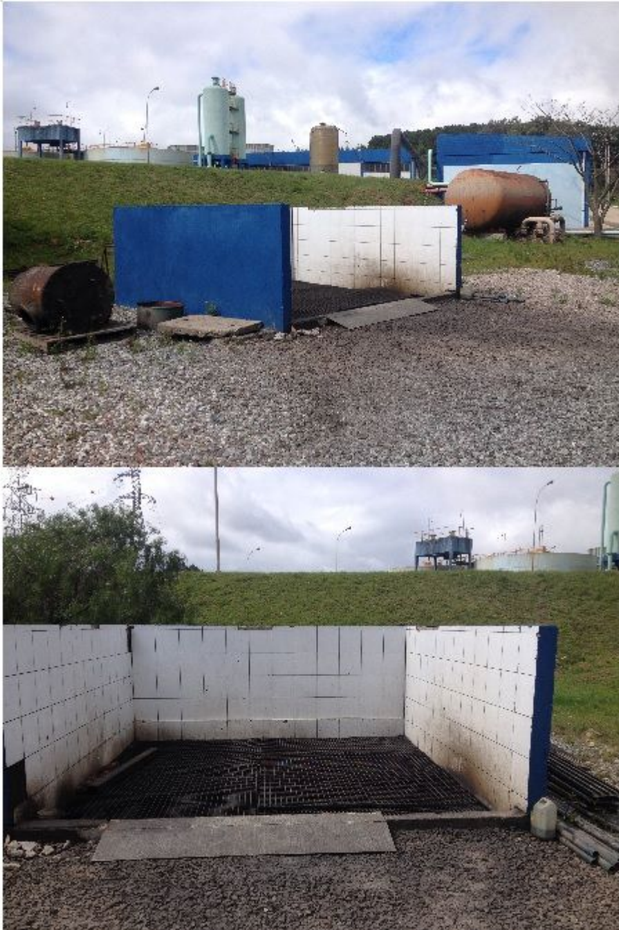
Figura 57: Ponto 1 da figura 56 – Bacia de lavagem de equipamentos
