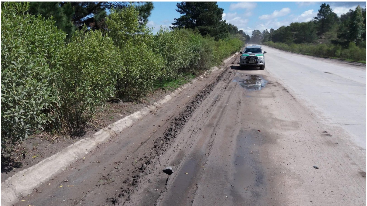
Figura 14 - Registro de sedimentos na estrada de acesso à Companhia Riograndense de Mineração em ponto cuja drenagem é descartada no corpo hídrico receptor dos efluentes da usina
