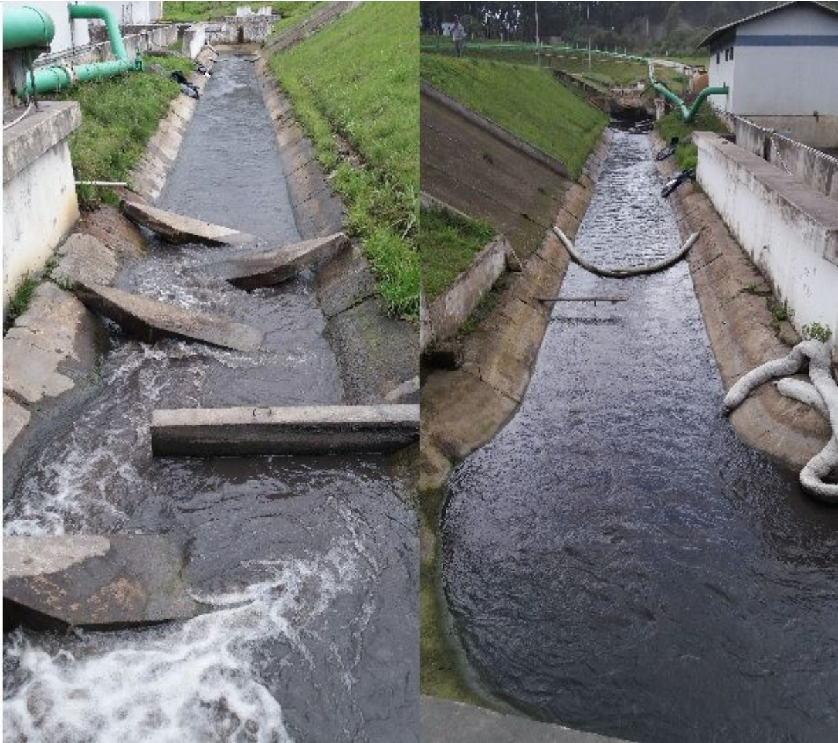
Figura 8. Ponto 3 da figura 1 – Canal de descarte dos efluentes líquidos: Presença de barreiras absorventes de óleo
