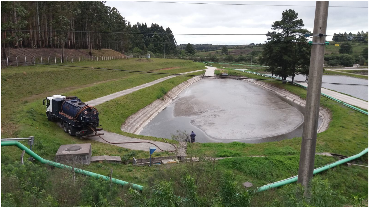
Figura 11. Ponto 1 da figura 1 – Recolhimento de efluentes contaminados com óleo na bacia de emergência por caminhão de sucção na manhã seguinte das constatações registradas anteriormente.
