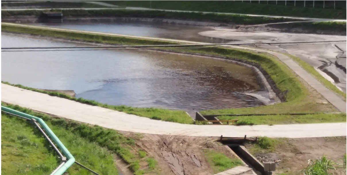
Figura 4. Ponto 2 da figura 1 - Bacias de sedimentação: Presença de pluma de óleo na bacia nº 1 à esquerda e material sólido sedimentado aguardando recolhimento na bacia nº 2 à direita.
