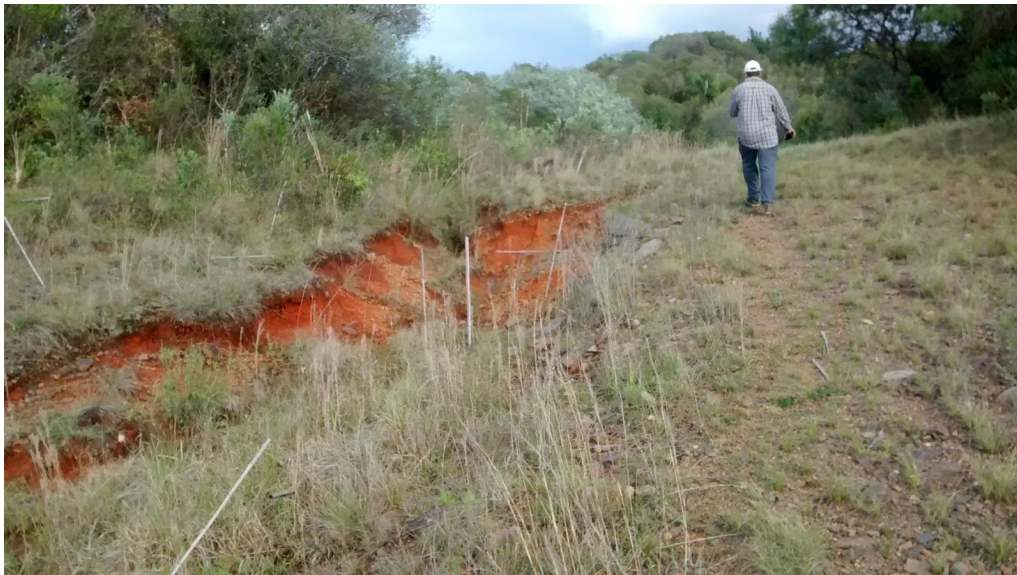
Figura 28. Área 11- Erosão do talude
