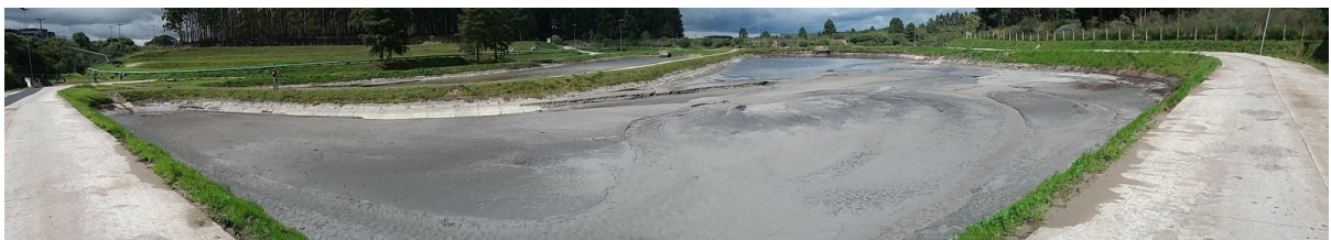
Figura 5. Ponto 2 da figura F1 - Bacia de sedimentação nº 1: Presença de pluma de óleo sobrenadante
