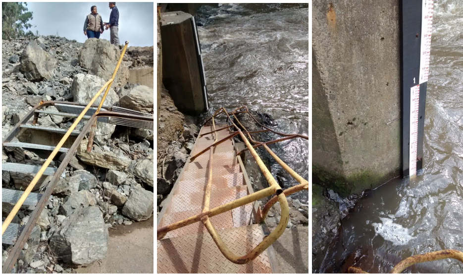
Figura 77. Escada de acesso ao Ponto Amostral 4 - PM4
