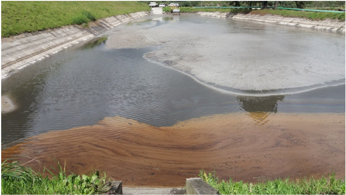
Figura 2. Ponto 1 da figura 1 - Bacia de emergência: Presença de efluentes contaminados com óleo e material sólido sedimentado
