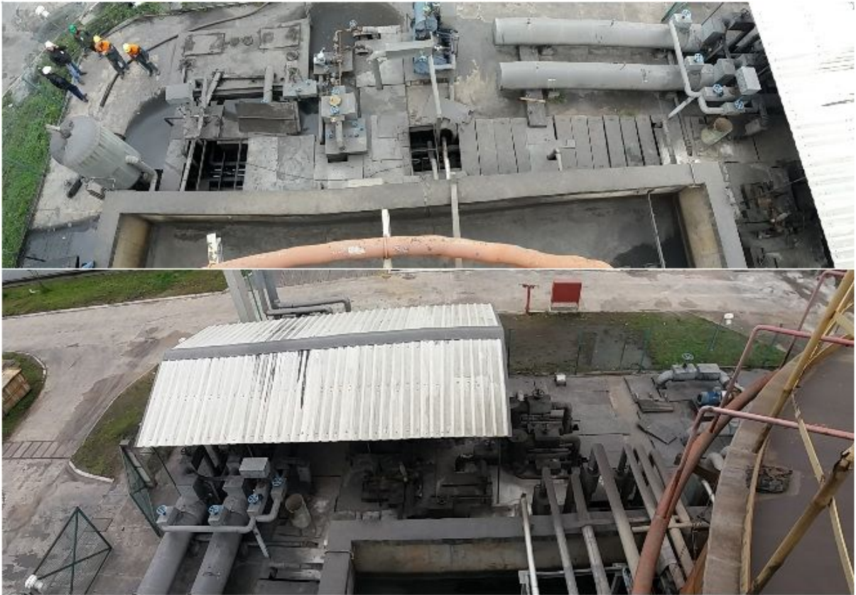
Figura 71: Ponto 4 da figura 56 - Sistema de armazenamento e bombeamento de óleo da fase C (vista de cima)
