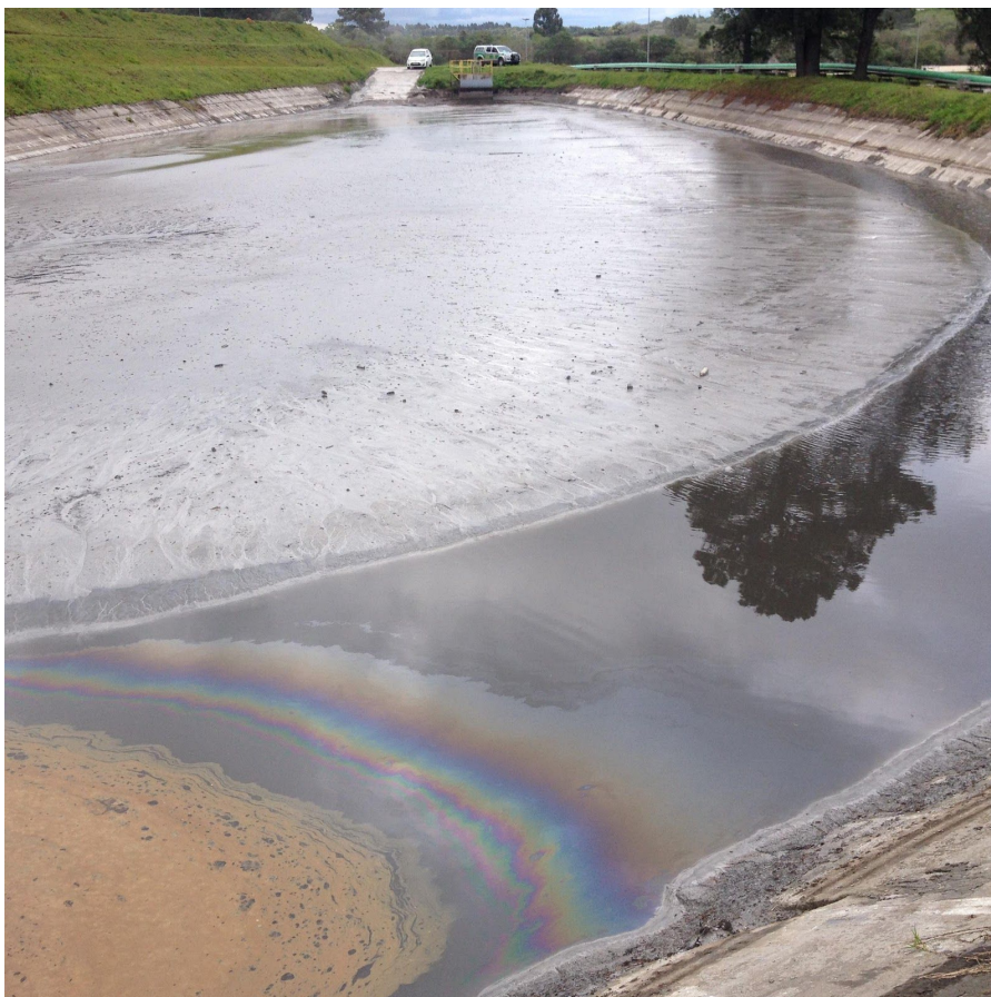
Figura 3. Ponto 1 da figura 1 - Bacia de emergência: Presença de efluentes contaminados com óleo e material sólido sedimentado
