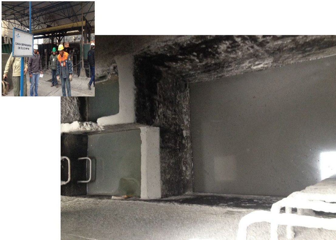
Figura 64: Ponto 2 da figura 56 - Registro de caixa SAO nº 3 sem indícios de óleo (referente ao sistema de bombeamento de óleo da fase B)
