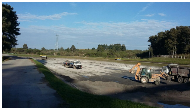
Foto 19. Remoção dos sedimentos na BD 01.
