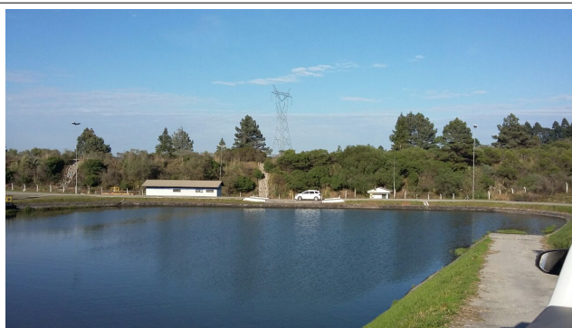
Foto 21. Bacia de decantação 04 sem manchas de óleo.
