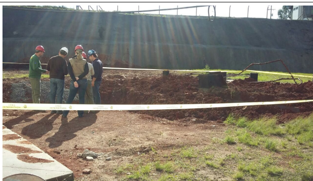
Foto 18. Local das fundações da ETE cloacal da fase C.
