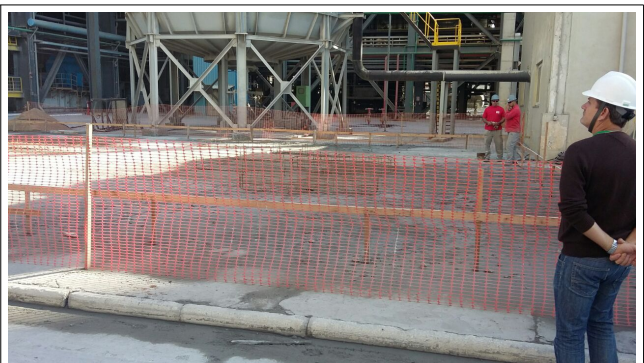
Foto 24. Fundações das caldeiras auxiliares.
