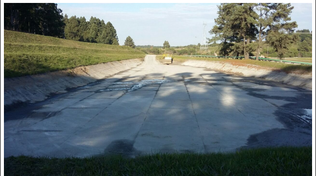
Foto 20. Bacia de decantação 05 limpa.
