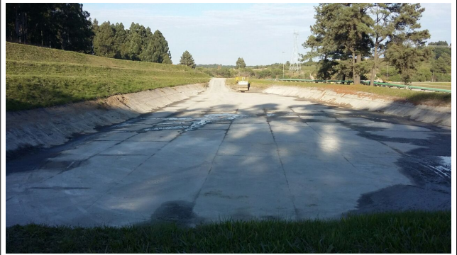
Foto 20. Bacia de decantação 05 limpa.
