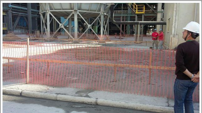
Foto 24. Fundações das caldeiras auxiliares.
