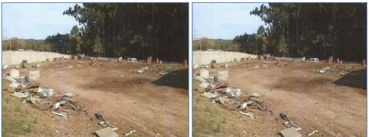
Figura 9. Remoção de Sucata Metálica da Área Externa a Central de Armazenamento Temporário.
