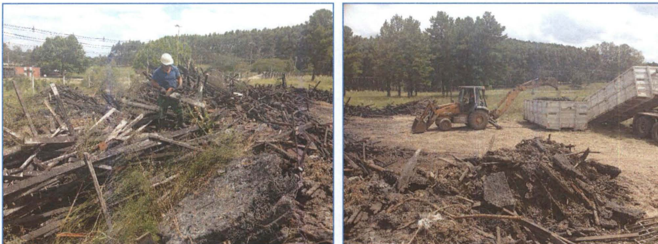
Figura 16. Preparo e Carregamento de Resíduos de Madeira do Sinistro na Torre de Refrigeração da Fase A.
