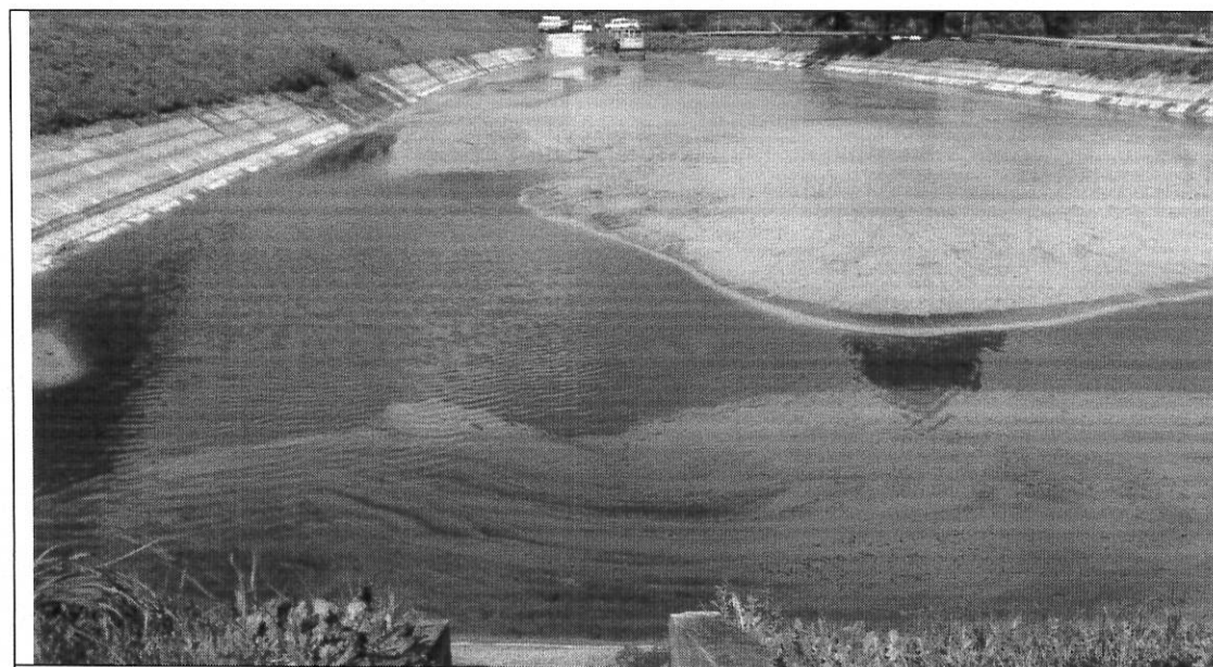
A12. Bacia 5 de Emergência da Fase C. Efluentes contaminados com Óleo, estocados aguardando recolhimento.
