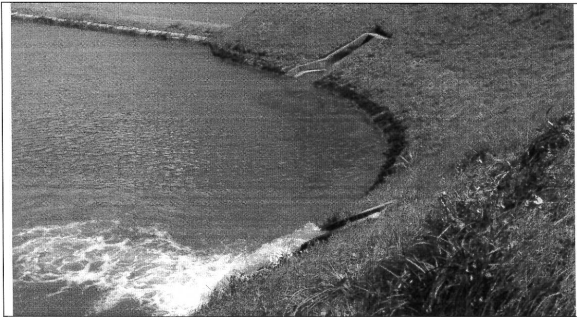
A6. Bacia 3 de Decantação de Cinzas. Recebimento de efluentes líquidos contaminados com Óleo.
