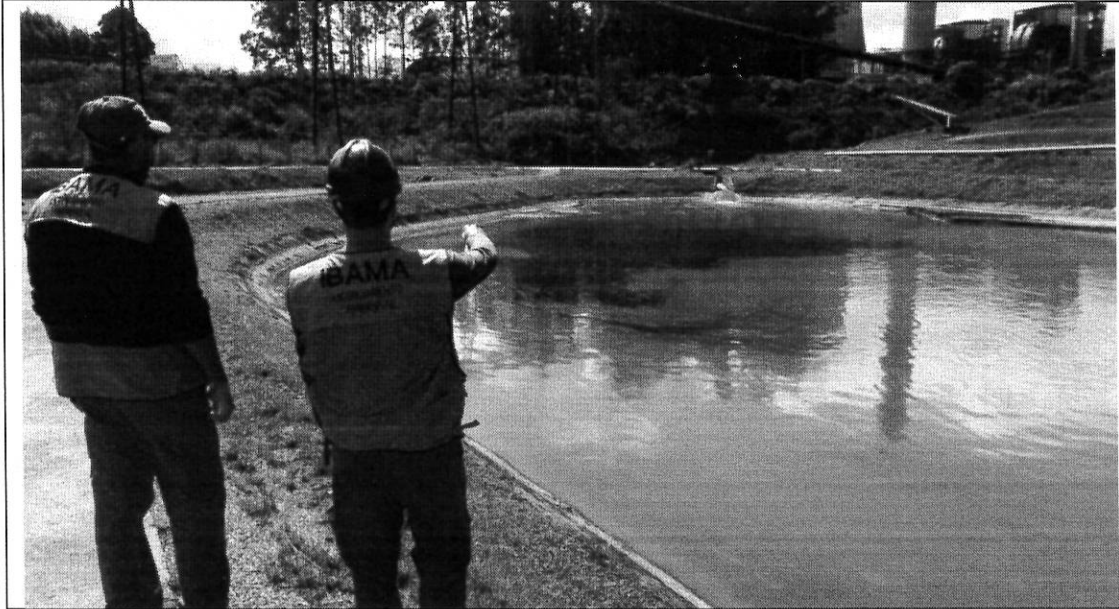
A1. Bacia 1 de Decantação de Cinzas. Recebimento de efluentes líquidos contaminados com Óleo, em vazão instantânea de 515,8 m 3 /h
