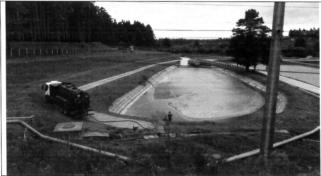
A13. Recolhimento de efluentes contaminados com Óleo na Bacia 5. Ação de Contingência.
