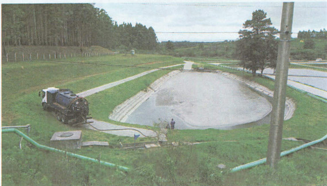
Figura 11. Ponto 1 da figura 1 – Recolhimento de efluentes contaminados com óleo na bacia de emergência por caminhão de sucção na manhã seguinte das constatações registradas anteriormente.
