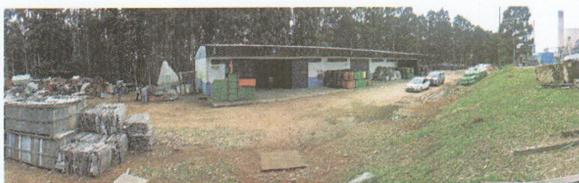
Figura 44 - Vista Geral da Central de armazenamento temporário de resíduos
