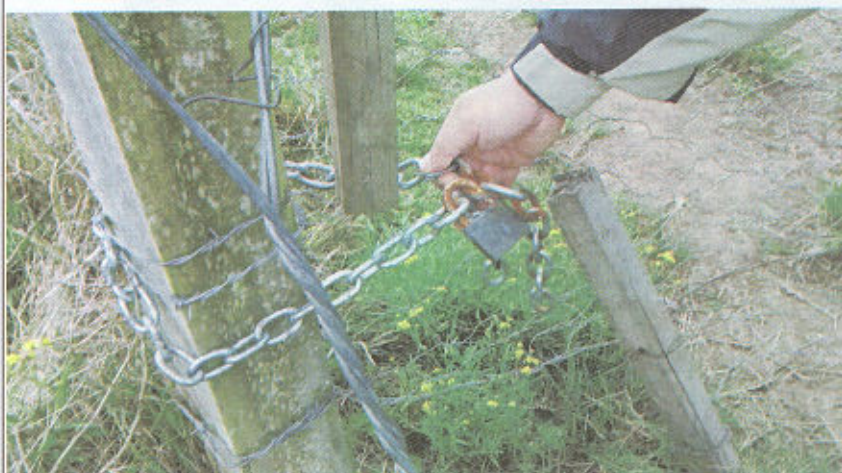
Figura 42. Cerca de divisão das propriedades danificada.
