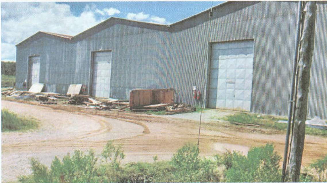
Figura 16 – Vista de externa dos galpões
