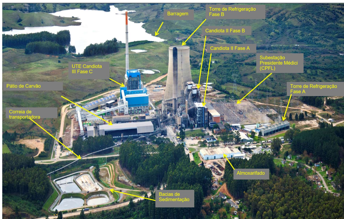
Figura 4. Instalações do Complexo Termoelétrico de Candiota.
