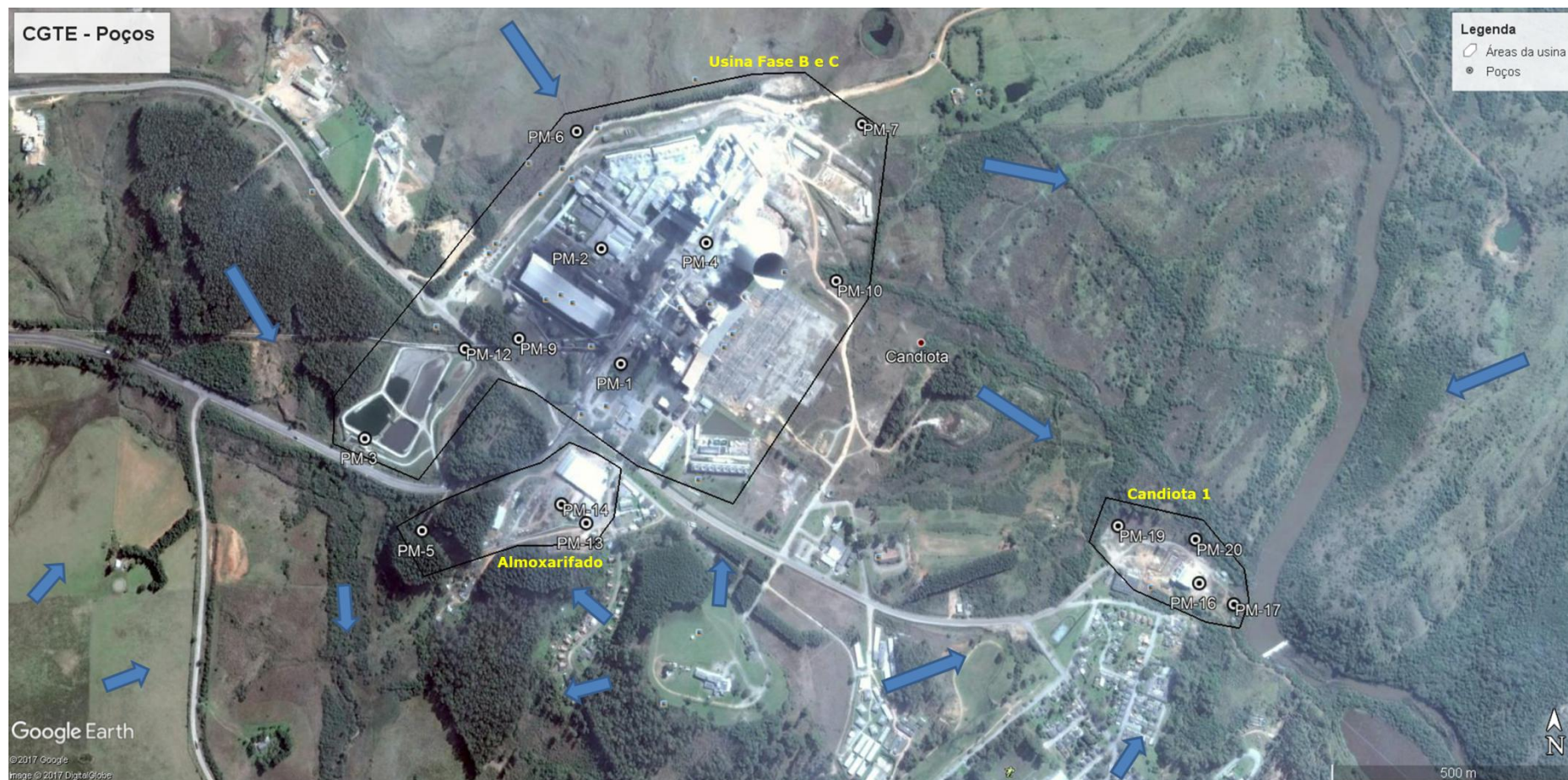
Figura 4.2.1 - Mapa apresentando a localização das áreas monitoradas e dos poços de coleta de água subterrânea na Usina Termelétrica Presidente Médici. As setas azuis representam as diferenças altimétricas relativas e possíveis percursos das águas meteóricas e subterrâneas.
