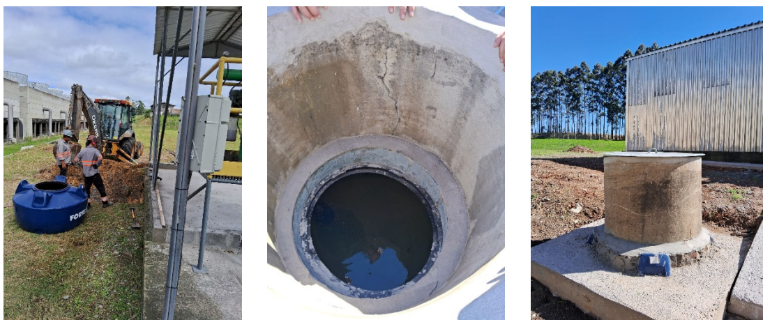
Figura 8: Instalação do tanque para tratamento dos resíduos de microalgas gerados durante a manipulação.
