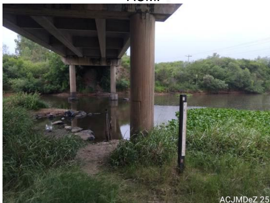
Figura 3 - Caracterização ambiental do ponto 02 – ACM.
