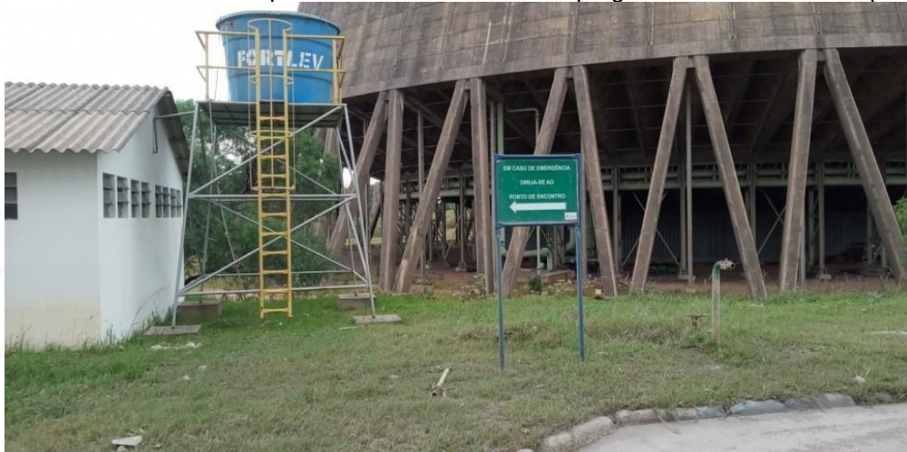
Figura 25 - Placa orientativa para direcionamento dos empregados da caldeira até o ponto 4.
