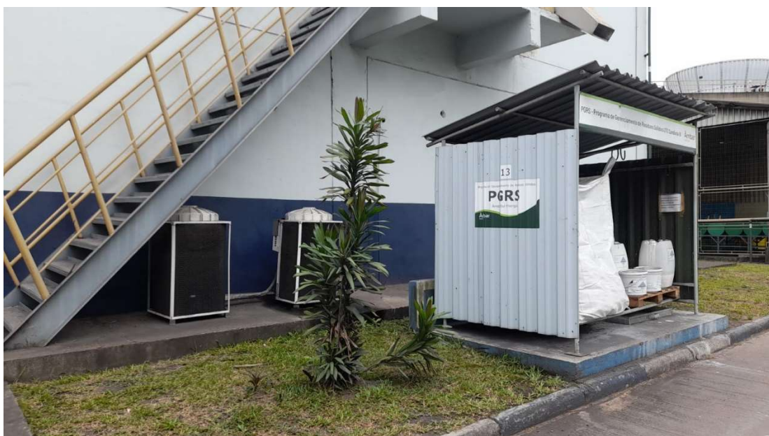
Figura 7. Coletores de Resíduos na Área de Uso de Produtos Químicos.
