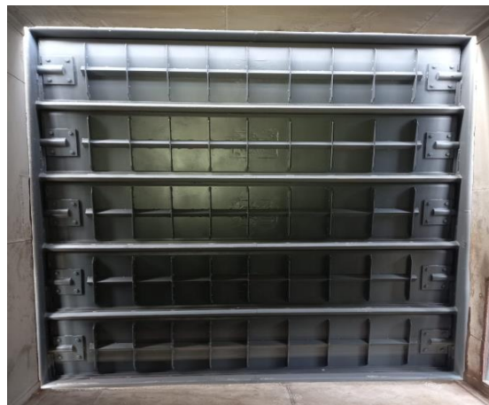
Figura 14- instalação de novo damper de gás limpo.
