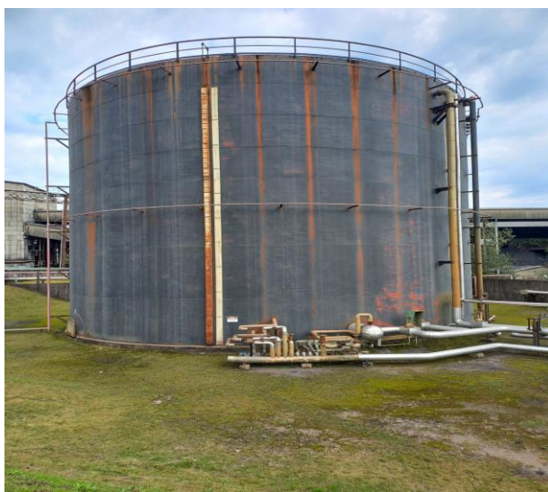
Figura 39 – Reforma dos tanques de óleo combustível
