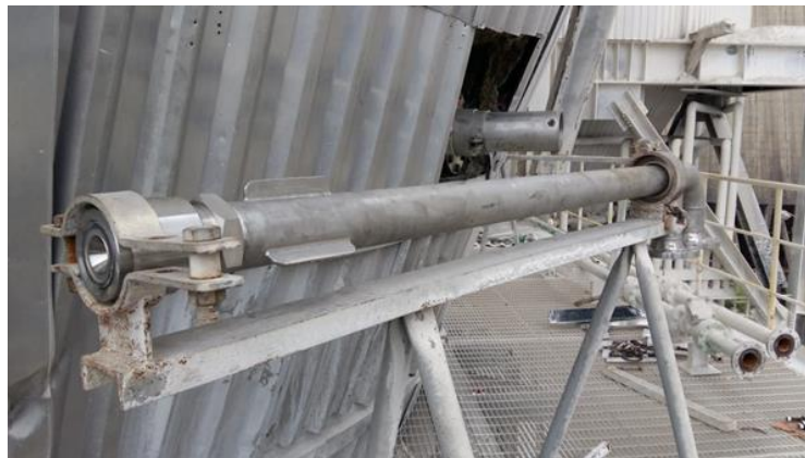
Figura 11- troca das lanças de injeção de água no dessulfurizador.
