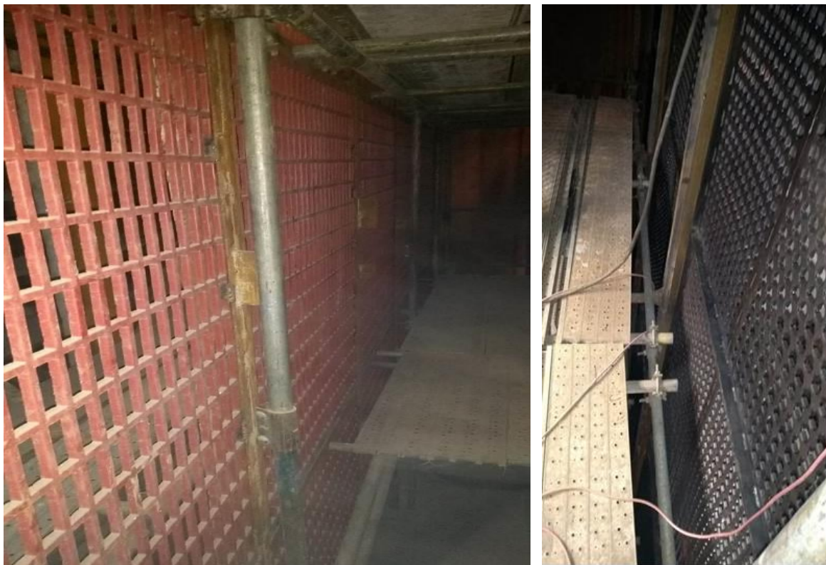
Figura 5- instalação de placas distribuidoras com maior eficiência.
