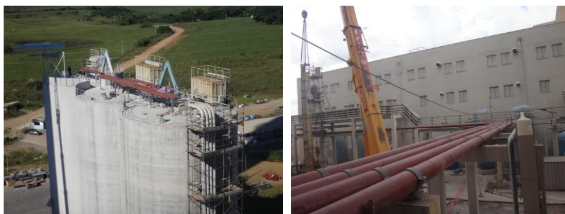
Figura 25- instalação das tubulações revestidas para transporte pneumático de cinza.
