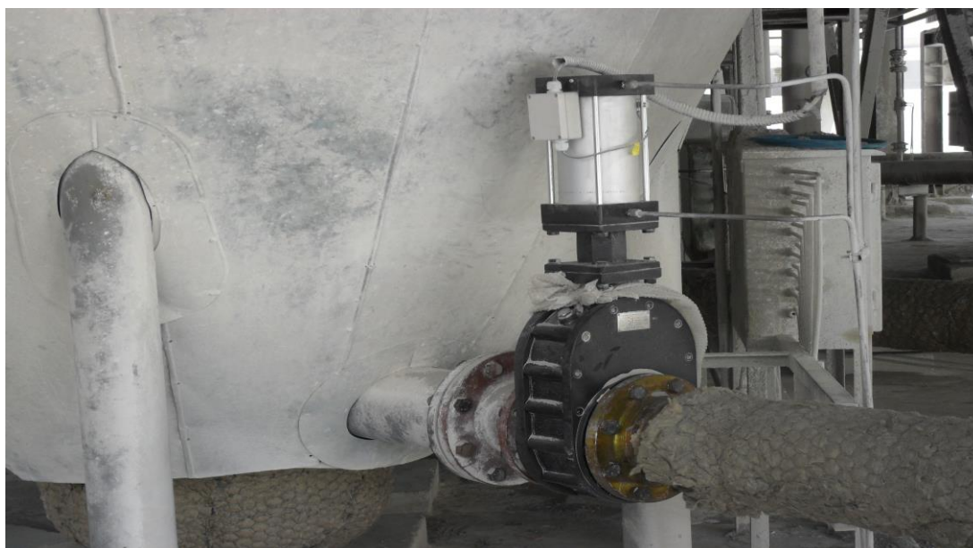
Figura 22- troca de válvulas dos propulsores.
