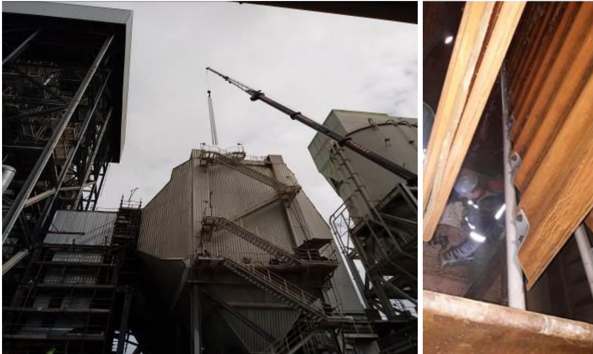
Figura 4- troca de placas de coleta nos precipitadores.
