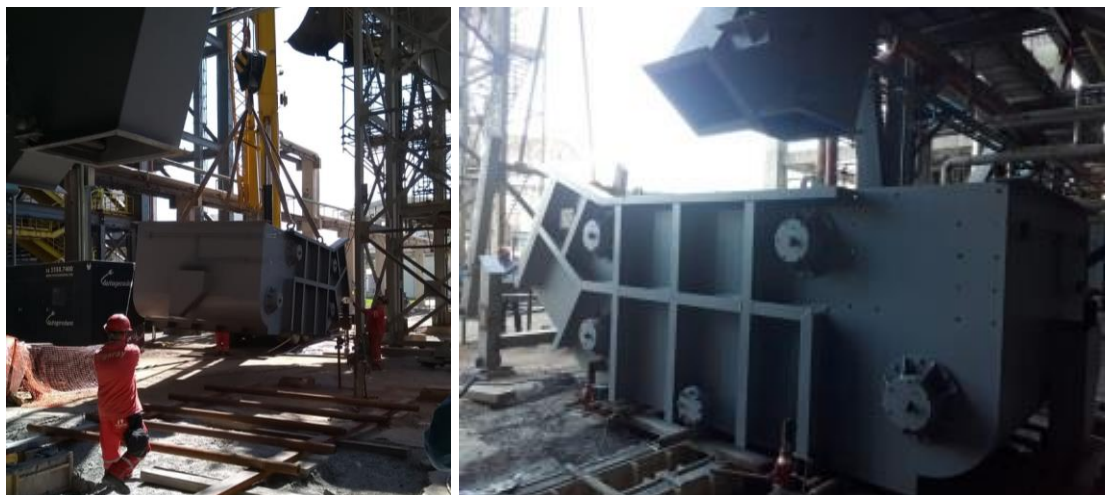
Figura 27- Montagem do novo transportador.
