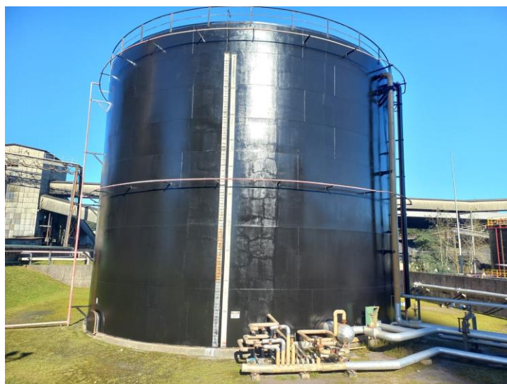
Figura 40 – Reforma dos tanques de óleo combustível.
