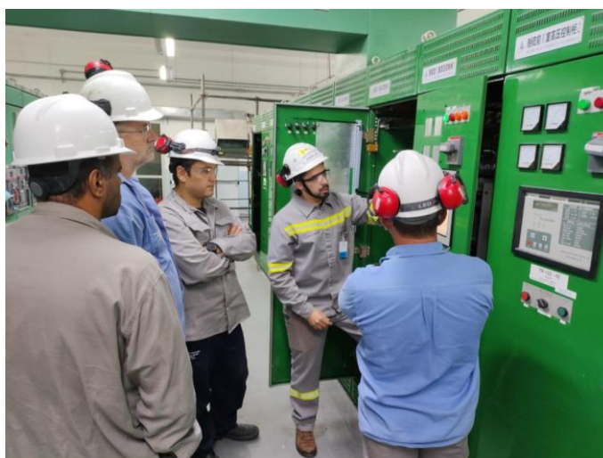
Figura 8 – instalação e comissionamento dos controladores de tensão
