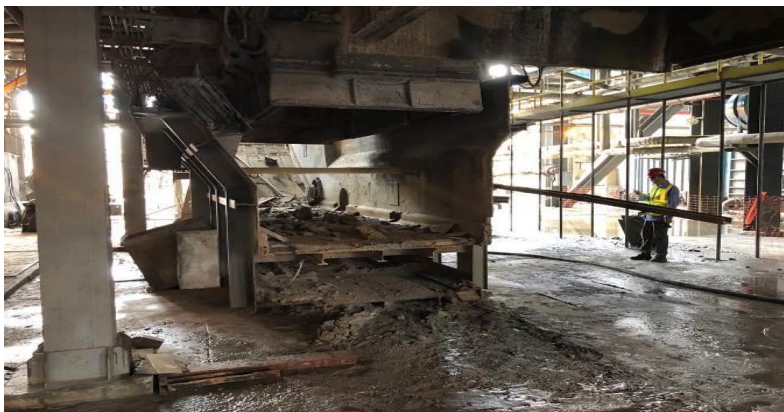
Figura 26- Desmontagem do transportador original.
