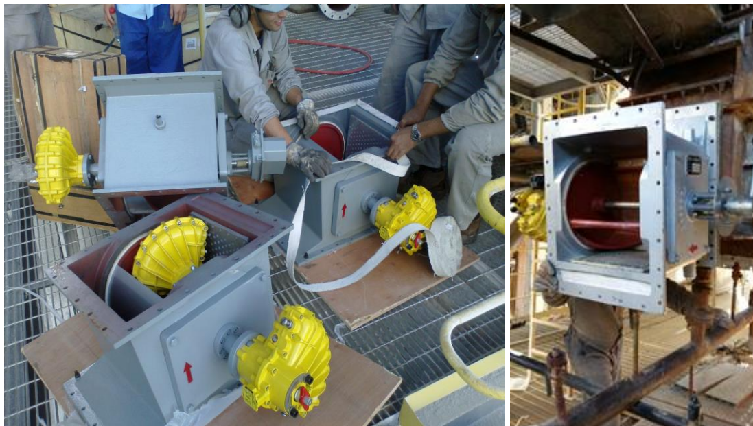
Figura 23- troca de válvulas de controle de fluxo dos propulsores.
