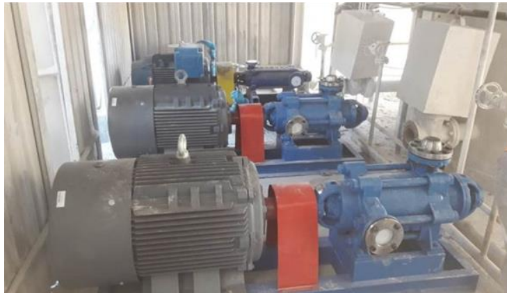
Figura 10- troca das bombas de injeção de água no dessulfurizador.
