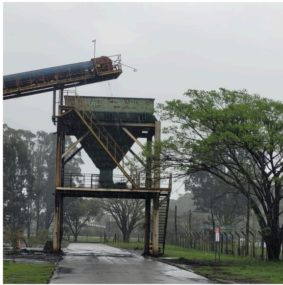
Foto 05: Silo de subproduto da jigagem (cinza leve)
