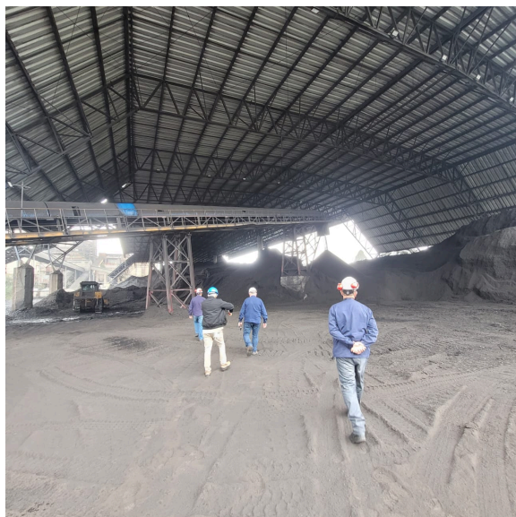
Foto 03: Pátio de Estocagem de Carvão.
