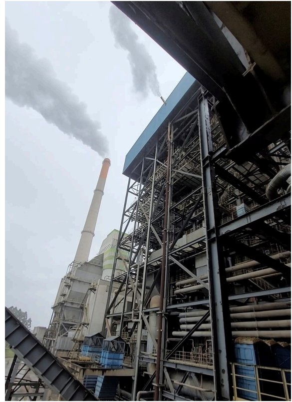
Foto 10: Chaminé e Válvula de alívio.
