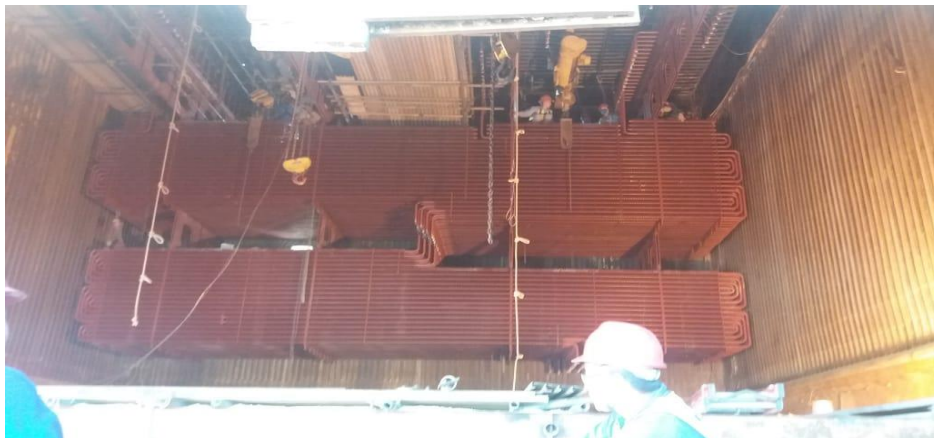
Figura 29 - Troca do economizador da caldeira da UTE Candiota III.
