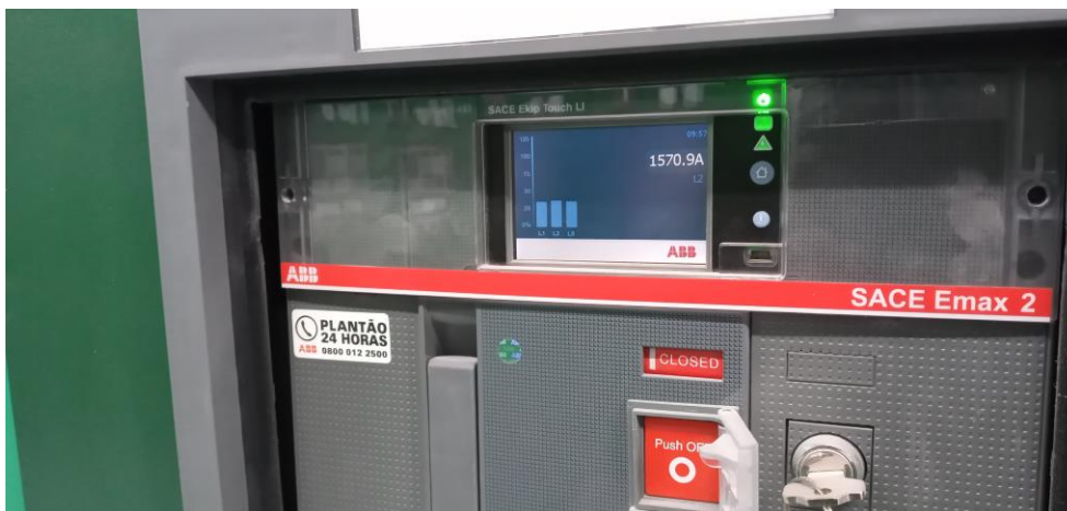
Figura 9 – Disjuntor Emax 2.
