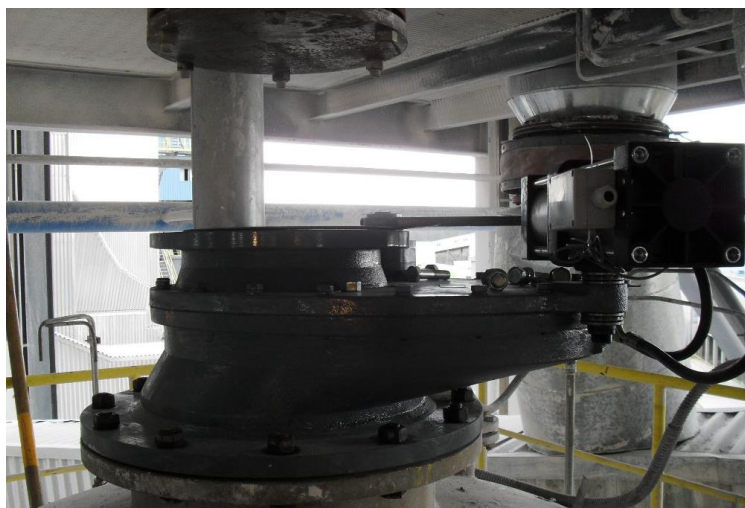
Figura 23- troca de válvulas de controle de fluxo dos propulsores.
