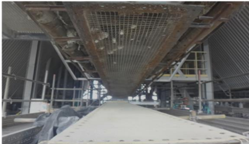
Figura 6- substituição das lonas do sistema de transporte de cinzas.
