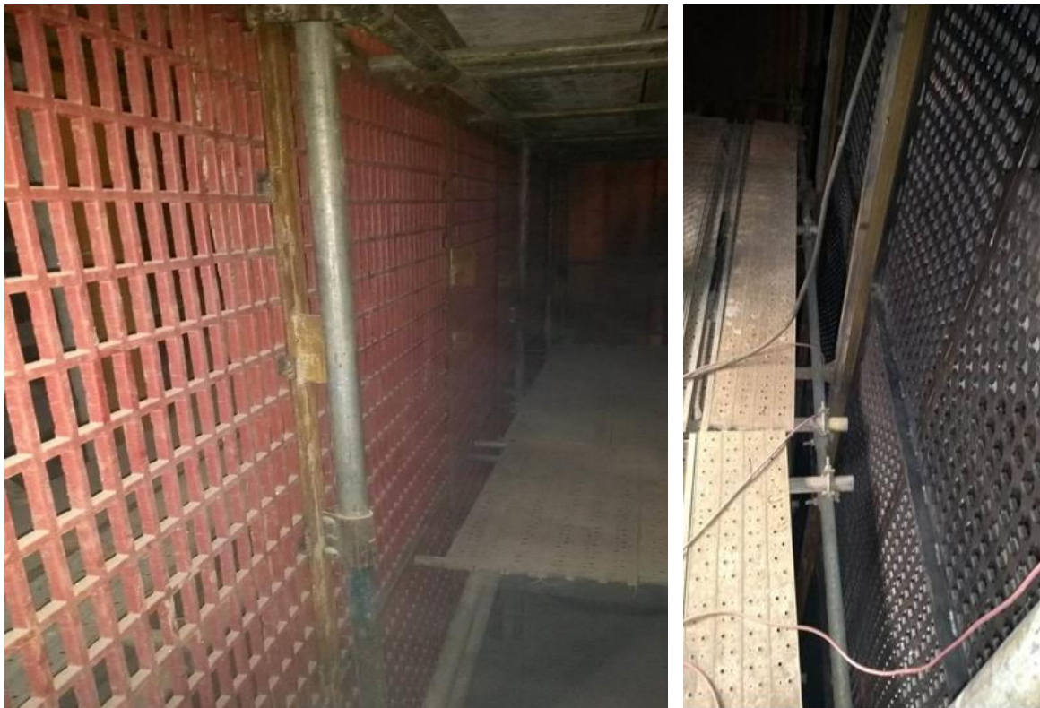
Figura 5- instalação de placas distribuidoras com maior eficiência.
