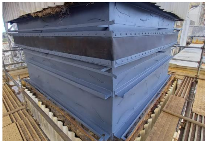
Figura 15- recuperação de dutos e troca de juntas de dilatação.
