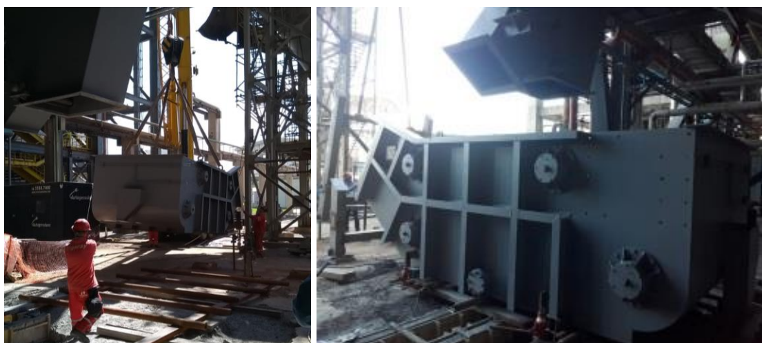
Figura 27- Montagem do novo transportador.
