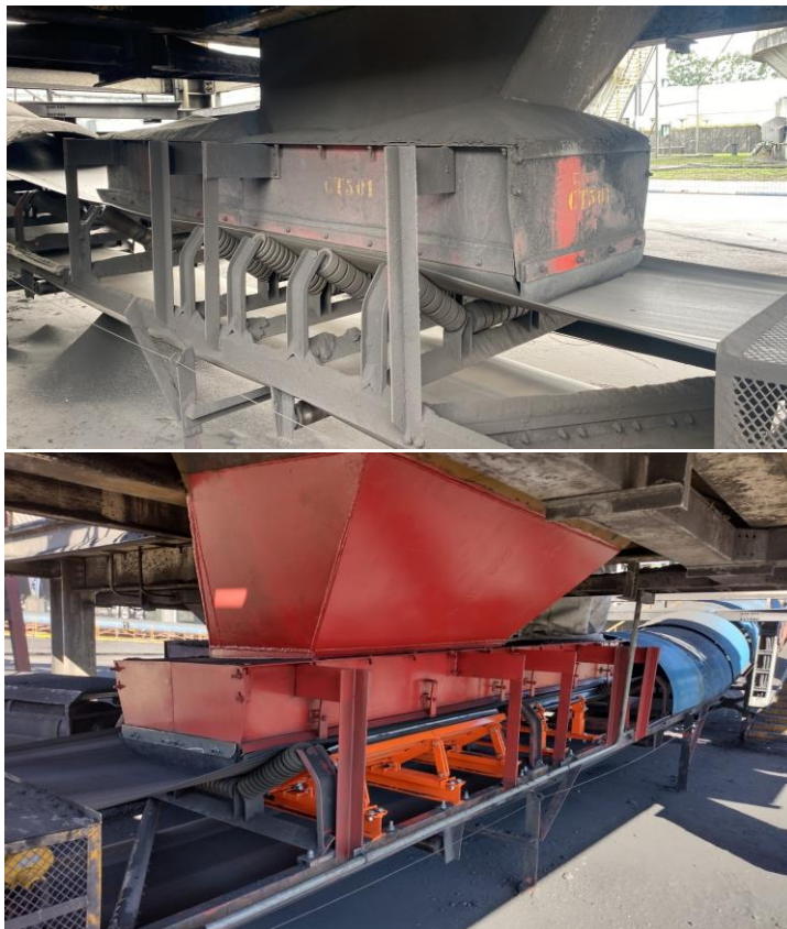
Figura 32 – Reformas das transferências dos britadores para as correias (Antes e depois).
