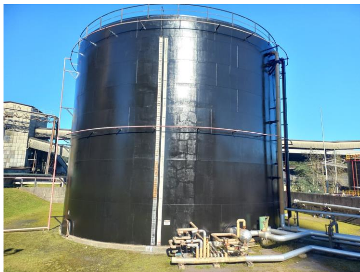
Figura 40 – Reforma dos tanques de óleo combustível.
