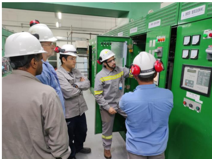
Figura 8 – instalação e comissionamento dos controladores de tensão
