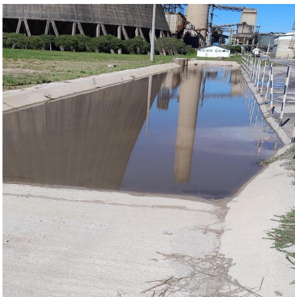
Figura 44 – Bacias de drenagem e contenção da usina.
