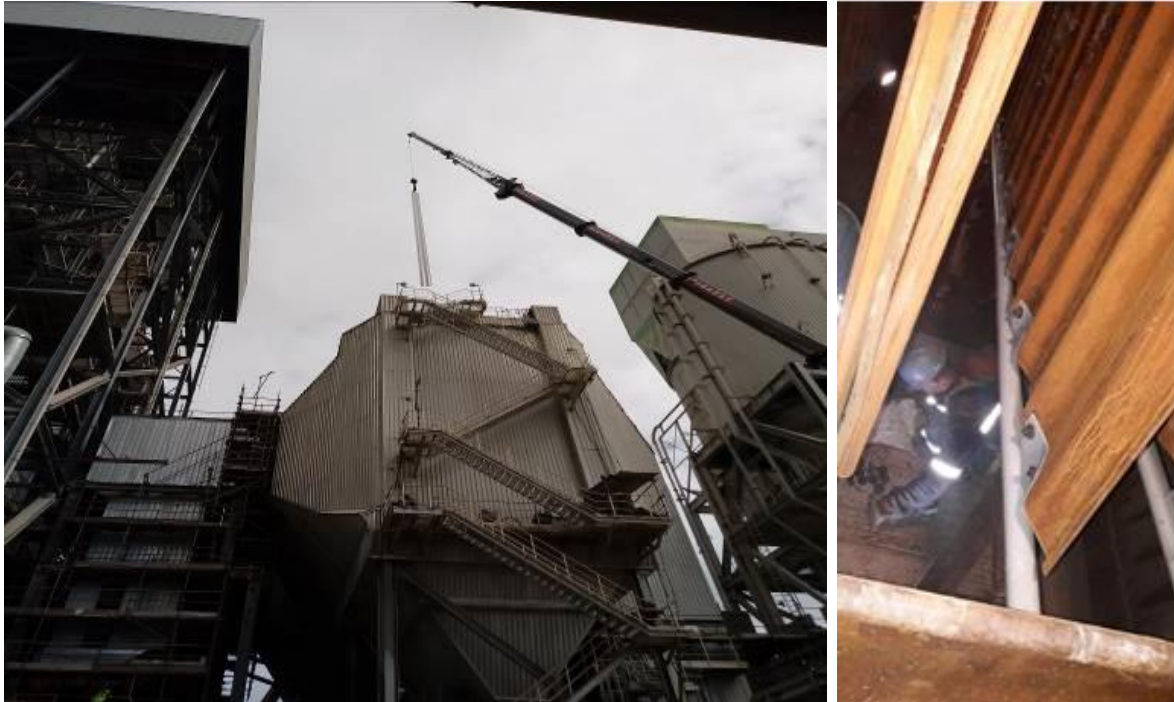
Figura 4- troca de placas de coleta nos precipitadores.
