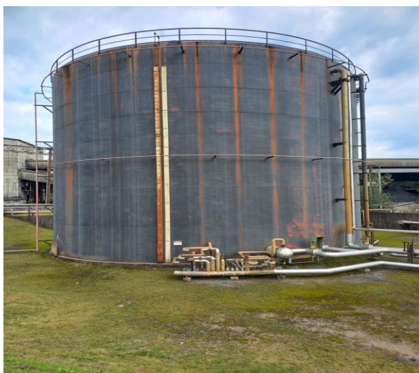
Figura 39 – Reforma dos tanques de óleo combustível
