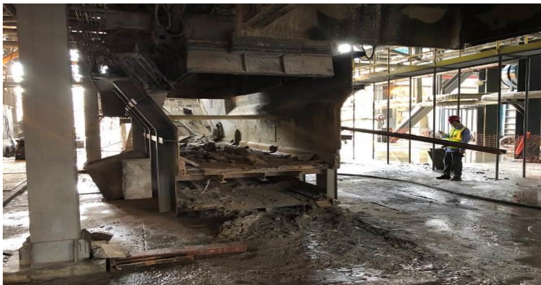
Figura 26- Desmontagem do transportador original.
