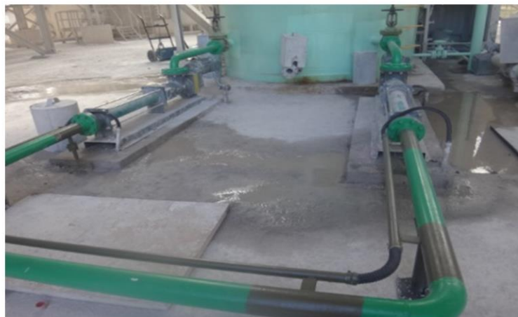
Figura 12- troca das bombas de água de hidratação de cal.
