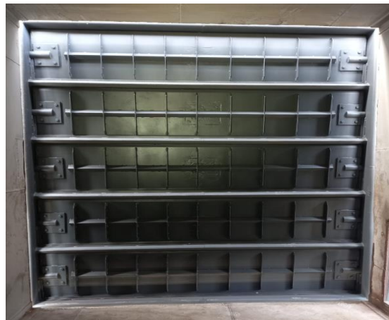
Figura 14- instalação de novo damper de gás limpo.
