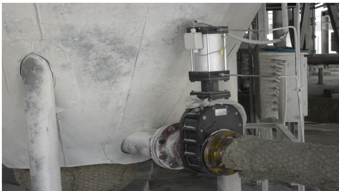
Figura 22- troca de válvulas dos propulsores.
