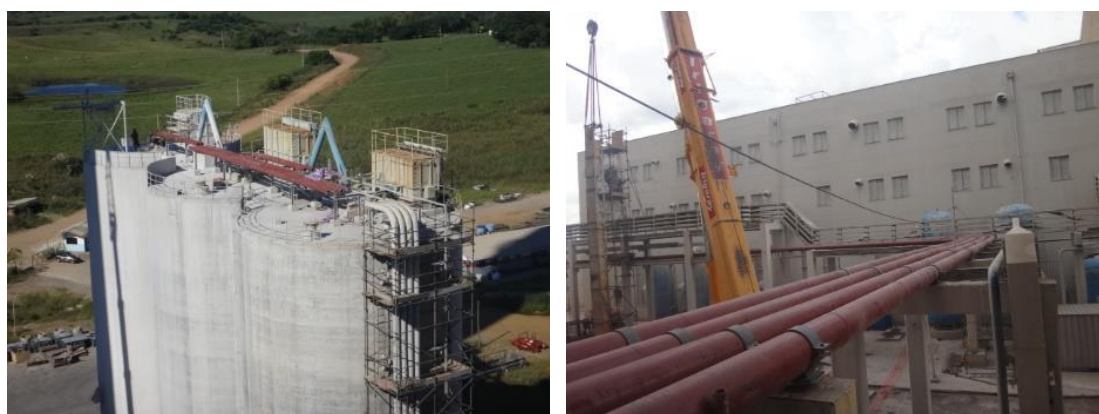
Figura 25- instalação das tubulações revestidas para transporte pneumático de cinza.
