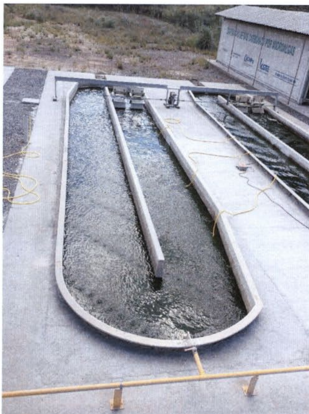
Figura 70: Vista aérea da Planta Piloto em operação
