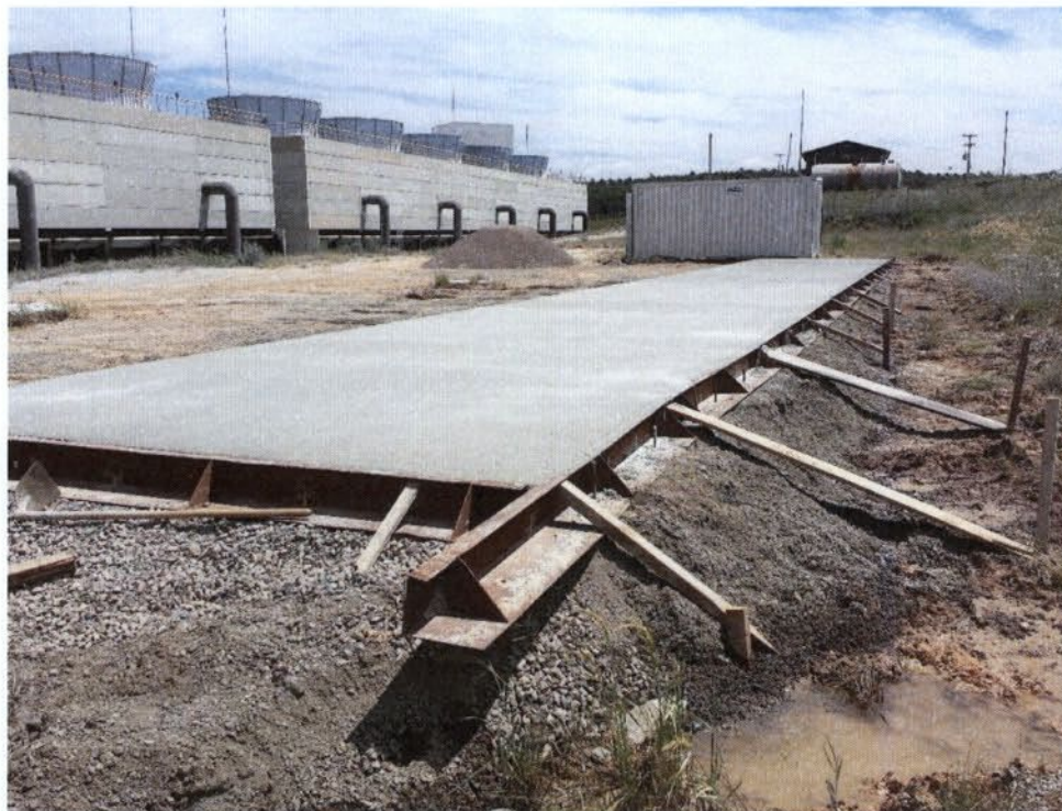
Figura 40: Base dos containers e início da construção das bases dos fotobiorreatores
