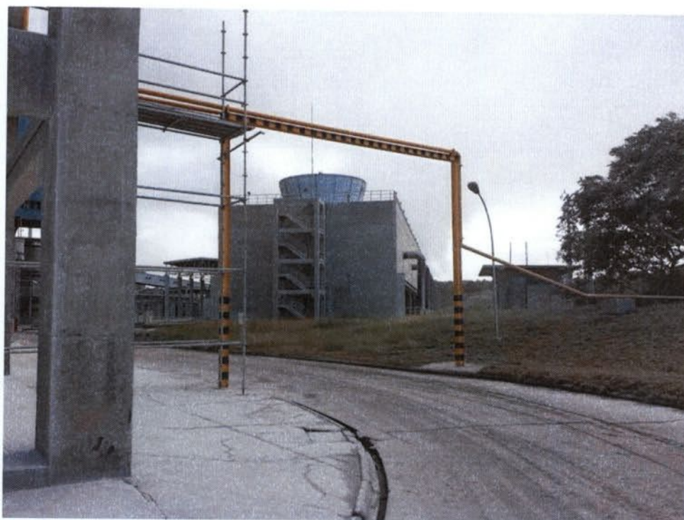
Figura 56: Assentamento tubulação da Chaminé da Fase C até Skid da Planta Piloto
