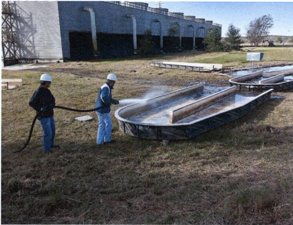
Figura 36: Limpeza dos biorreatores (02/07/2014)
