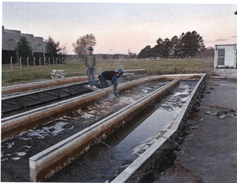
Figura 35: Remoção dos biorreatores (18/06/2014)
