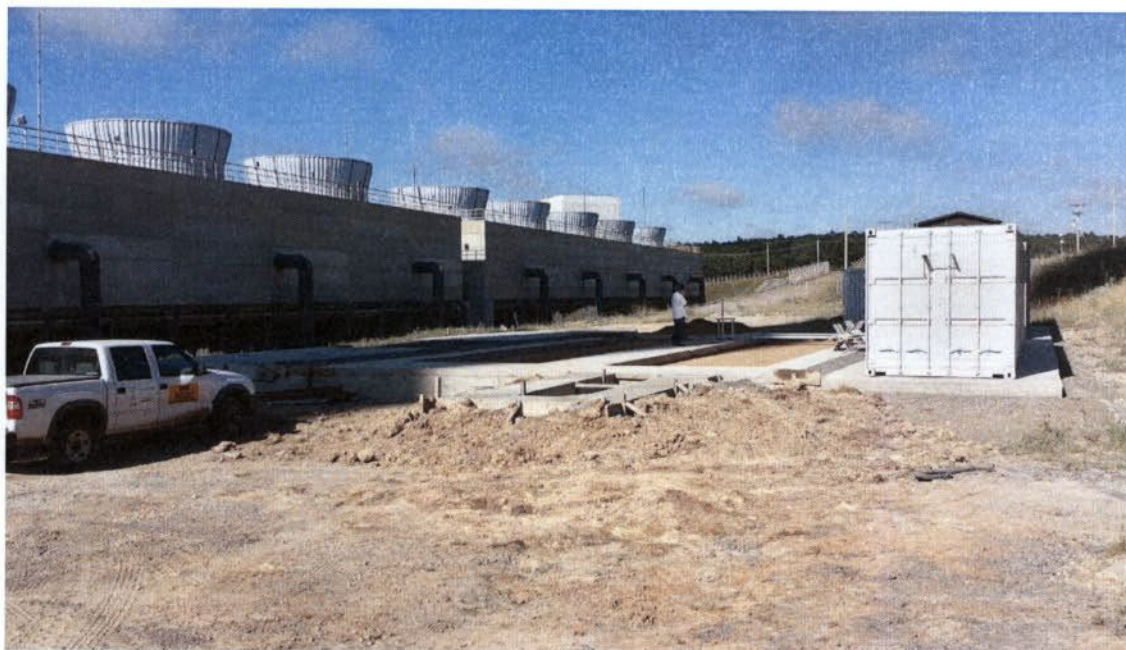
Figura 41: Bases dos fotobiorreatores e do Skid concluídas
