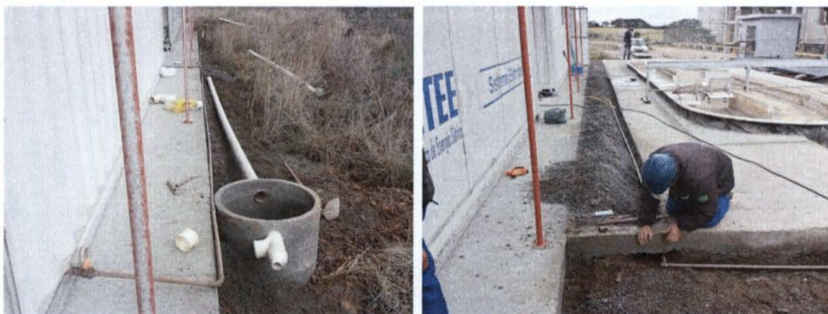
Figura 61: Instalação da Rede Hidráulica na Planta
