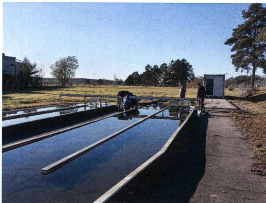
Figura 33: Remoção do sistema de agitação dos biorreatores (18/06/2014)
