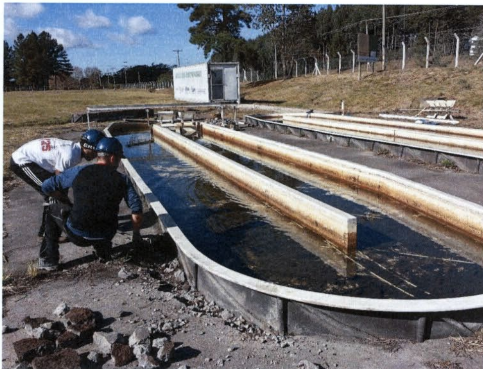
Figura 34: Remoção dos biorreatores (18/06/2014)
