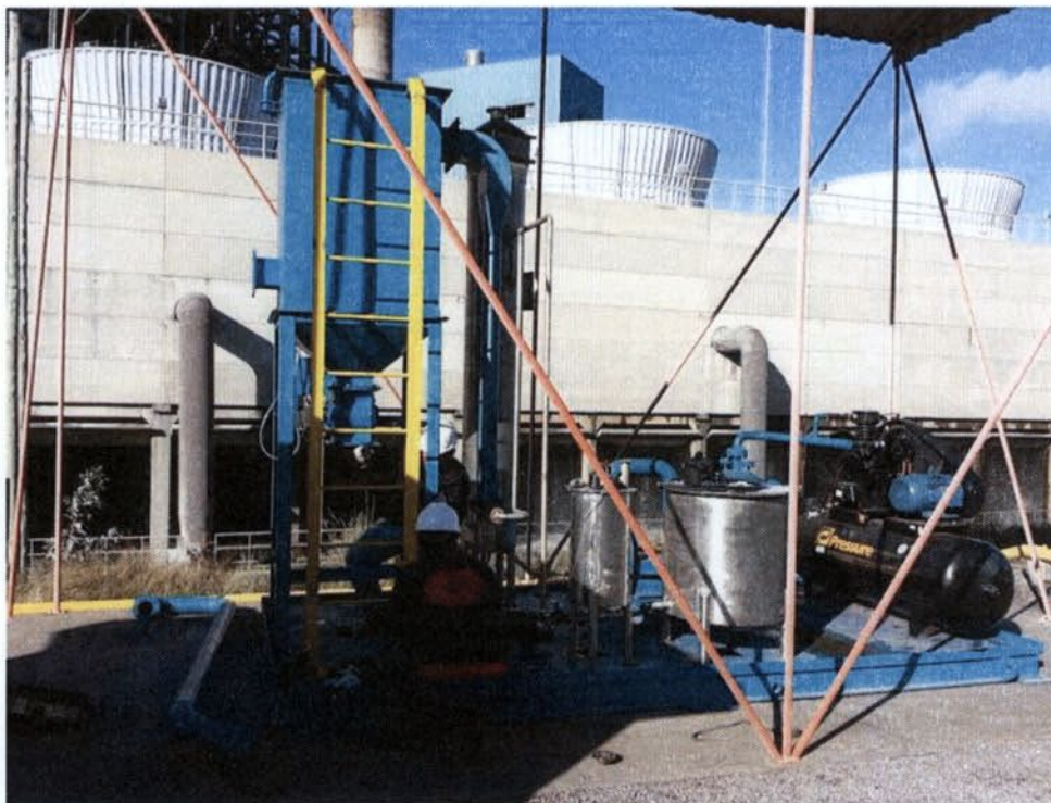
Figura 55: Montagem do Skid e Vaso de armazenagem de gás na Planta Piloto
