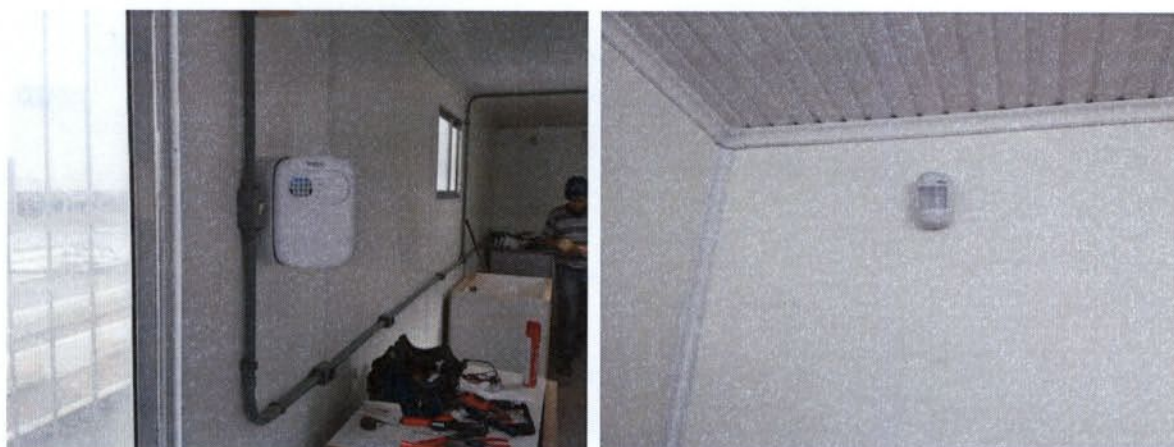
Figura 64: Instalação do sistema de segurança por alarme na Planta
