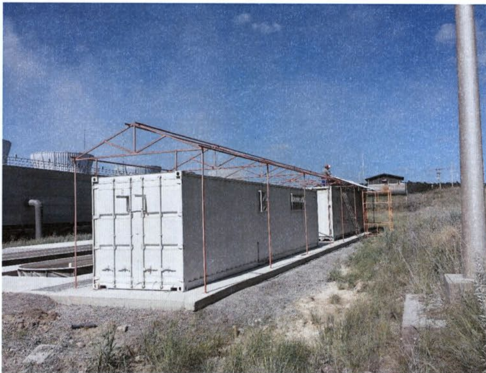
Figura 47: Instalação da cobertura dos containers
