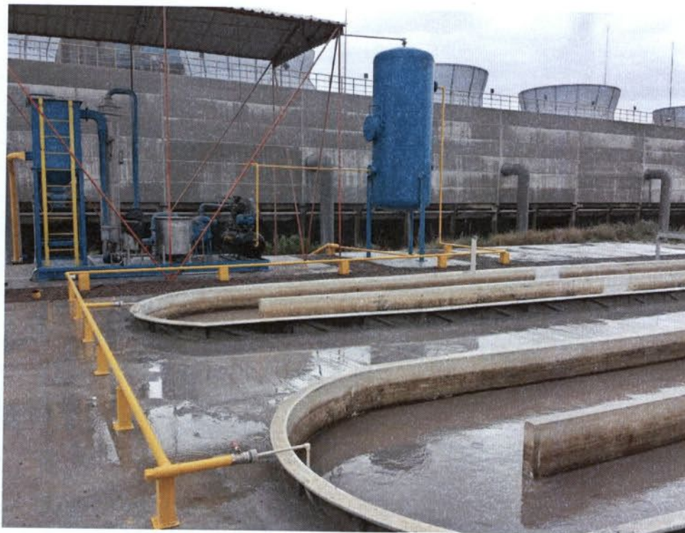
Figura 59: Tubulação de gás do Skid até fotobiorreatores (continuação)
