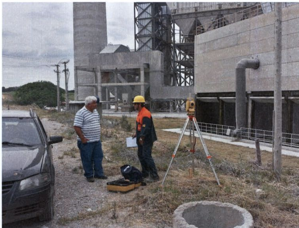
Figura 38: Marcação das coordenadas para início da construção das bases (29/10/2014)
