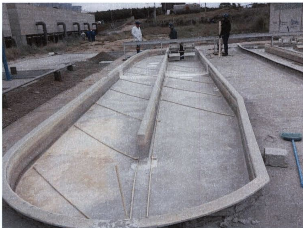
Figura 60: Montagem da tubulação de gás nos fotobiorreatores
