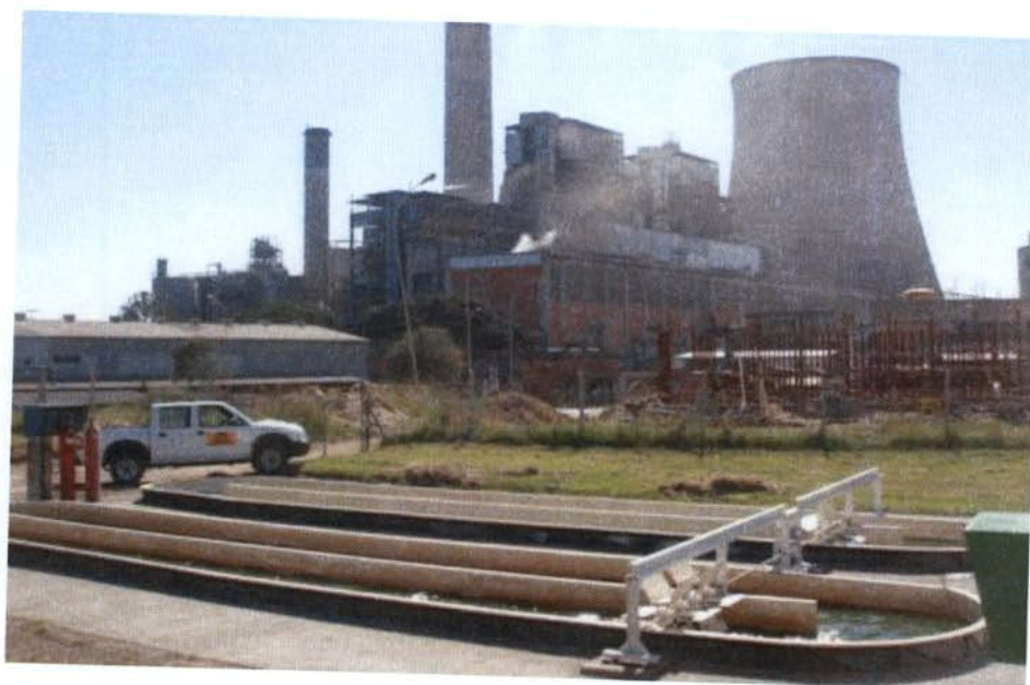
Figura 8: Fotobiorreatores do tipo Raceway – Antiga planta piloto de produção de biomassa microalgal localizada nas proximidades da torre de resfriamento das Fases A e B - Usina Termelétrica Presidente Médici, Candiota/RS.
