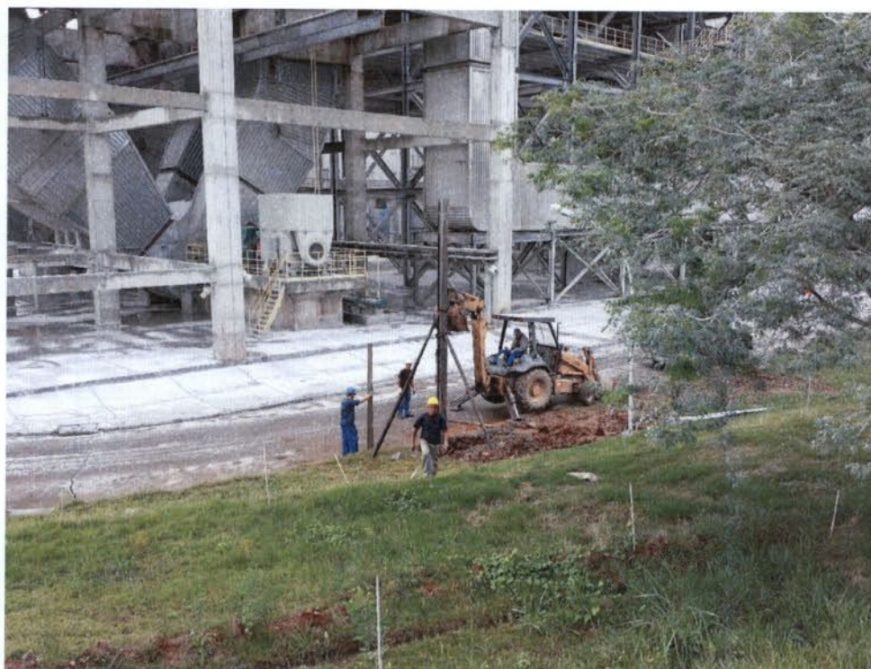
Figura 45: Construção do pipe-rack para passagem da tubulação de gás
