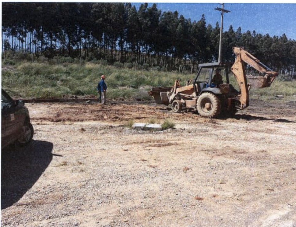
Figura 39: Início da construção das bases (04/11/2014)
