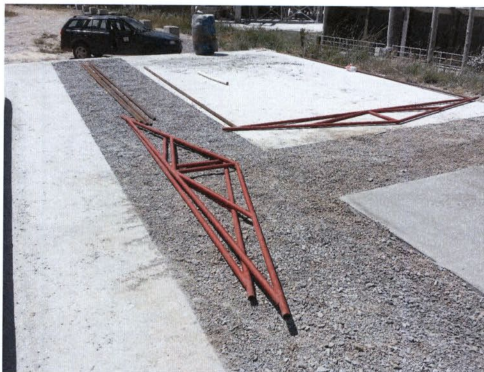
Figura 48: Instalação da cobertura do Skid
