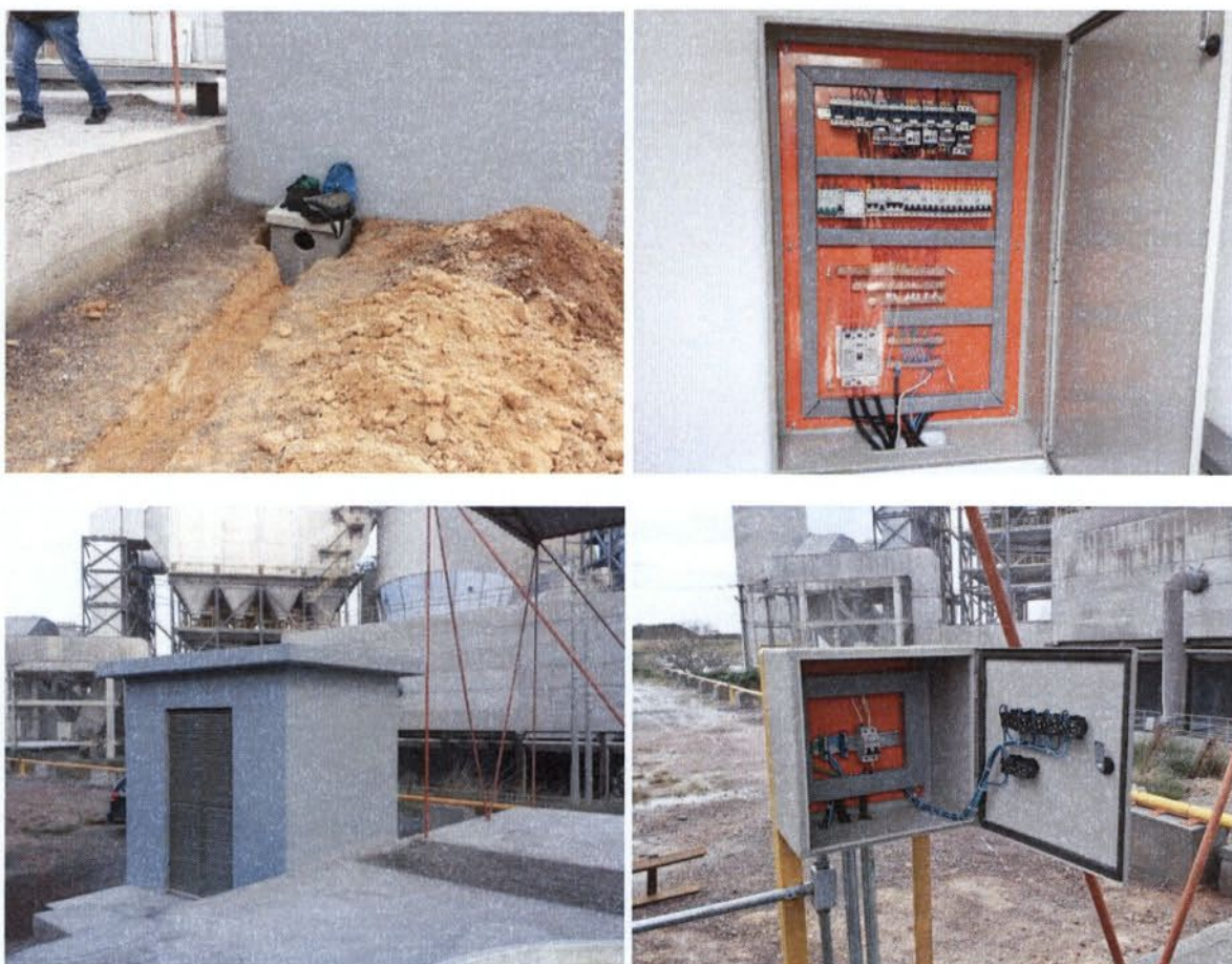
Figura 62: Instalação da Rede Elétrica na Planta
