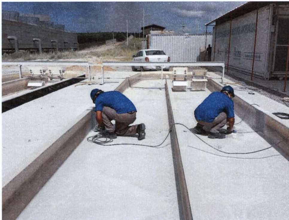
Figura 51: Reparo nos fotobiorreatores instalados na atual Planta Piloto
