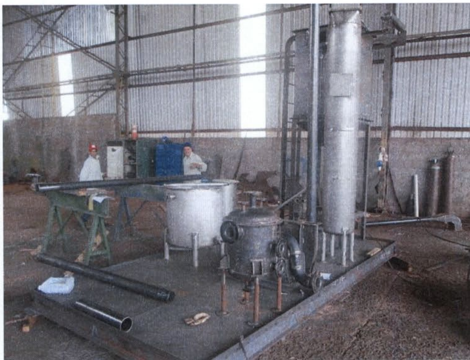
Figura 53: Montagem dos equipamentos que compõem o Skid
