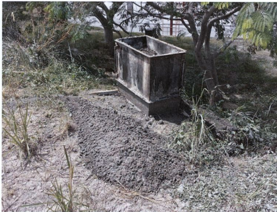
Figura 43: Construção dos dormentes para assentamento da tubulação de gás
