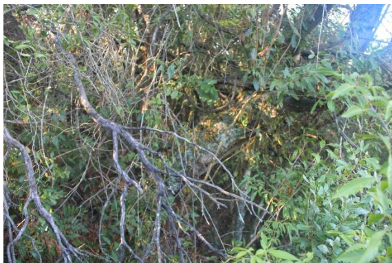
Figura 10. Aspecto da vegetação na ombreira esquerda do talude de jusante.
