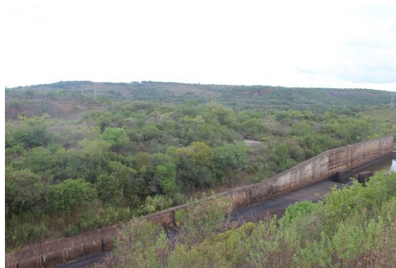
Figura 21. Área 04 junto aos muros laterais da margem esquerda do canal rápido.
