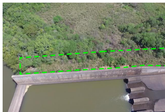
Figura 13. Área 03 delimitada pelo tracejado verde: do centro até a parte próxima a bacia dissipação
