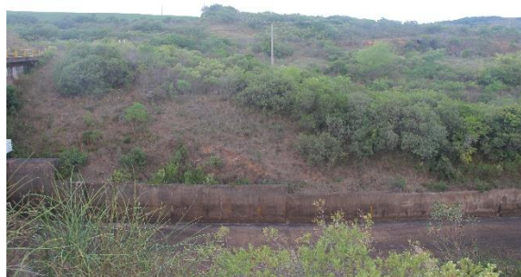
Figura 20. Cobertura vegetal da Área 04 na margem esquerda do canal rápido, próxima ao vertedouro.
