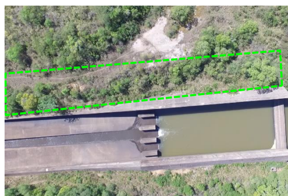
Figura 19. Área 04 na margem esquerda, delimitada pelo tracejado verde: do centro até a bacia de dissipação.
