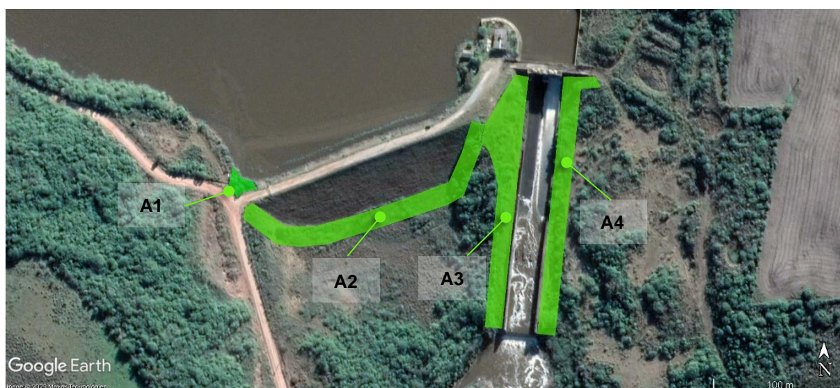
Figura 01. Área total a ser manejada delimitada pelos polígonos verdes: Área 01 = A1, Área 02 = A2, Área 03 = A3 e Área 04 = A4, nas margens da Barragem II, construída para servir à Central Termoelétrica Candiota III.
