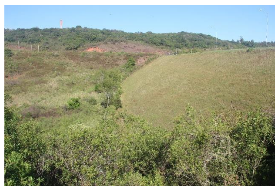
Figura 09. Vista do talude de jusante a partir da ombreira esquerda.
