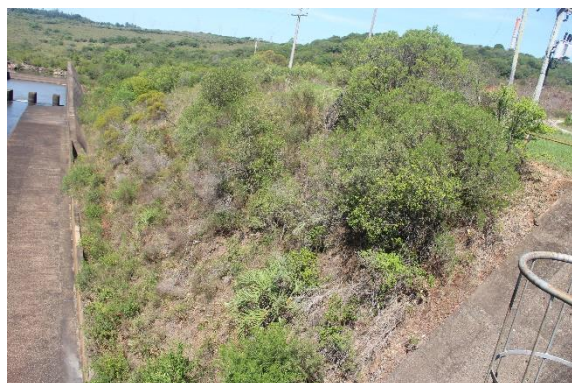
Figura 14. Talude à jusante do vertedouro, na margem direita do canal rápido. Nota-se poucas espécies arbustivas e arbóreas.
