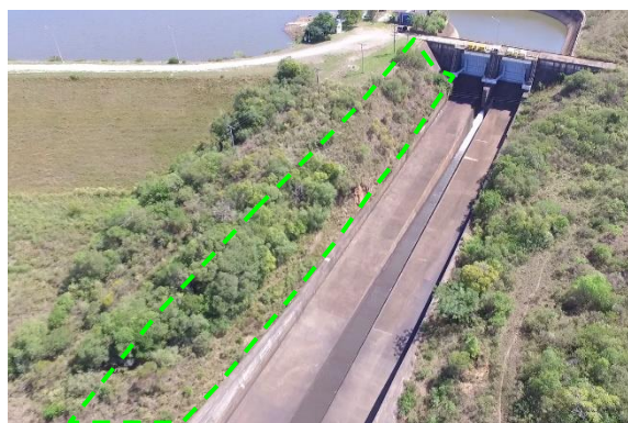
Figura 12. Área 03 na margem direita, delimitada pelo tracejado verde: da parte próxima do vertedouro até o centro.
