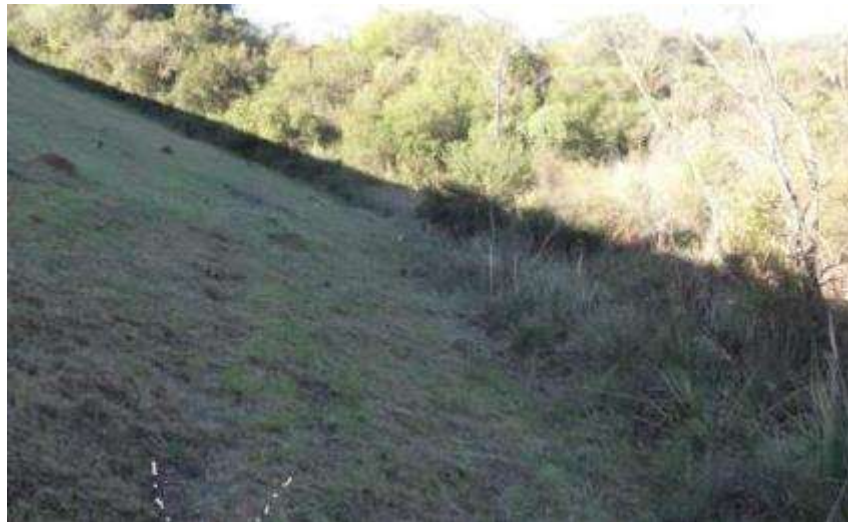
Figura1 Talude de jusante
