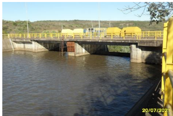
Foto 85: Região a montante da tomada d'água – Comporta com função de “stop-log”.
