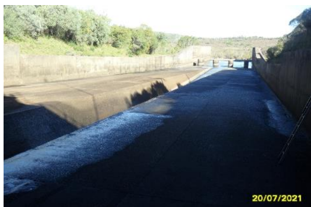
Foto 52: Canal rápido – Vista geral de montante para jusante.
