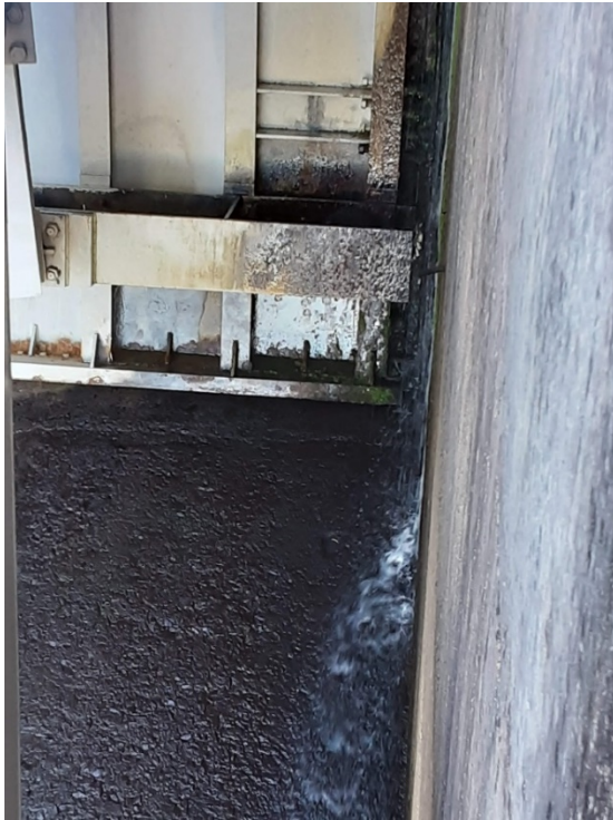
Figura 60. Anomalias nas comportas do vertedouro
