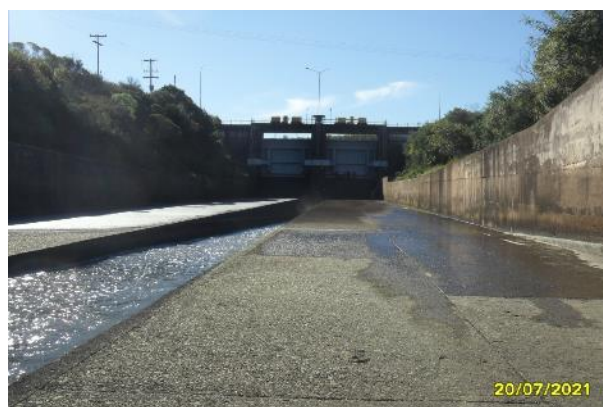
Foto 53: Canal rápido – Vista geral de jusante para montante.
