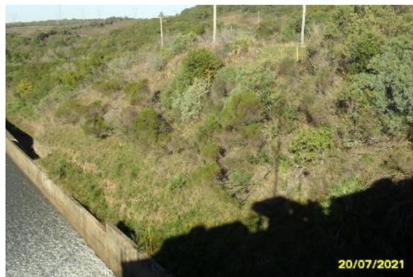
Foto 18: Talude de jusante – Vegetação na região próxima aos muros laterais, lado direito do canal rápido.
