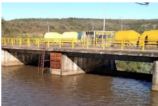
Foto 48: Bloco do vertedouro – Ponte sobre o vertedouro.
