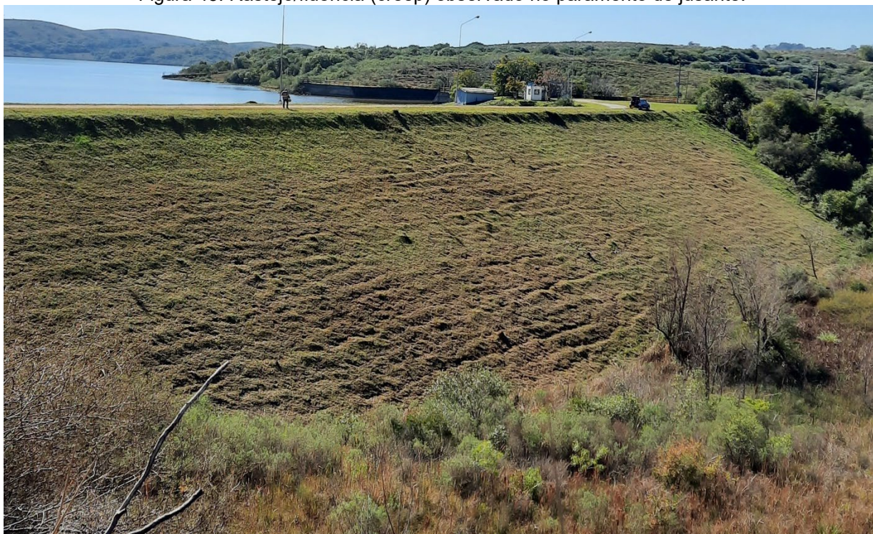
Figura 45. Rastejo/fluência ( creep ) observado no paramento de jusante.
