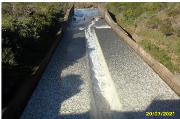
Foto 58: Canal rápido e bacia de dissipação – Vista a partir da ponte sobre o vertedouro.
