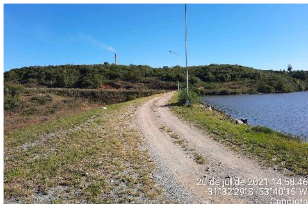
Foto 15: Coroaamento – Faixa transitável.
