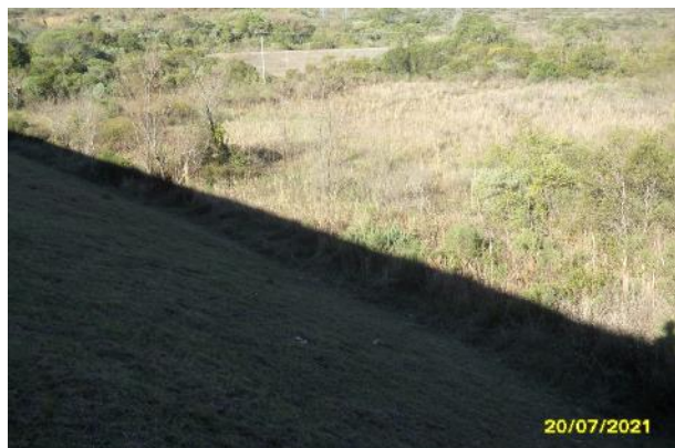
Foto 22: Região ao pé da barragem com presença de muita vegetação.
