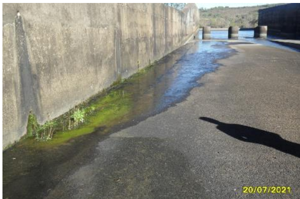
Foto 66: Muros laterais – Muro lateral esquerdo, na face junto ao canal rápido.
