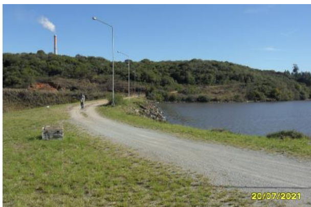
Foto 13: Coroamento – Vista geral.
