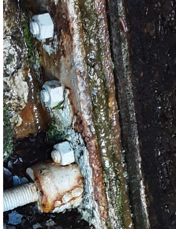
Figura 60. Anomalias nas comportas do vertedouro
