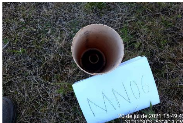
Foto 29: Medidor de nível d'água 06
