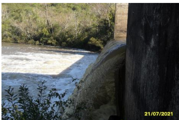
Foto 60: Bacia de dissipação – Vista do final da viga terminal ( end-sill ).
