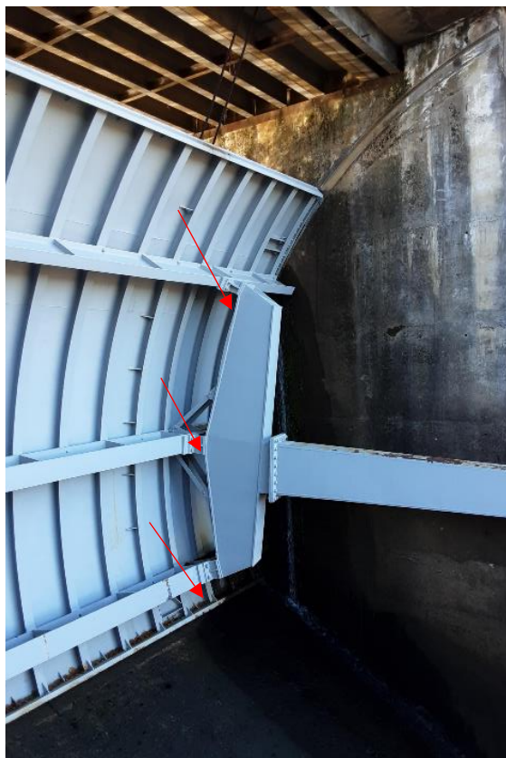
Foto 76: Comporta 1 – Indicação da posição dos parafusos analisados.
