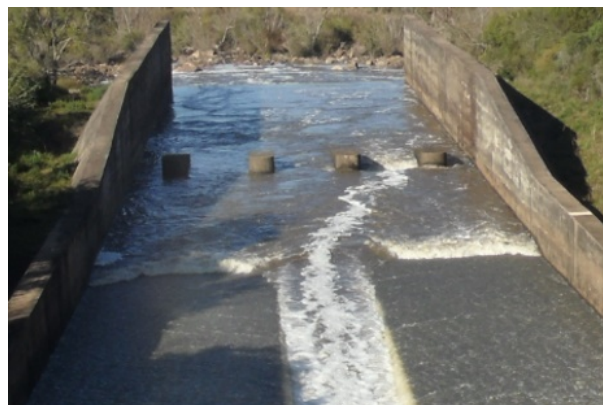
Foto 59: Bacia de dissipação – Aproximação da estrutura.
