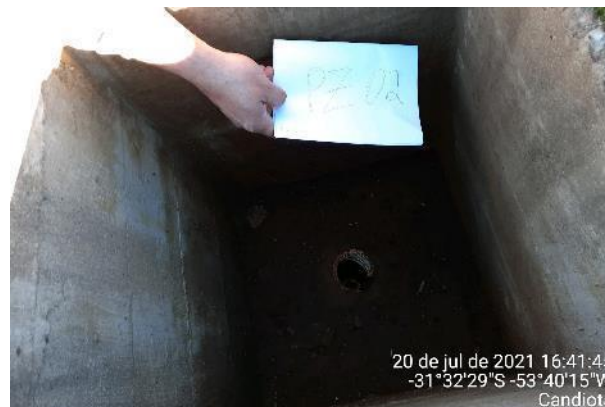
Foto 25: Piezômetro 02 – Condições internas.
