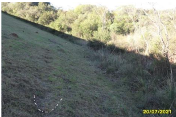
Foto 17: Talude de jusante – Presença de afundamento no talude indicado com linha pontilhada.
