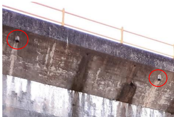
Foto 45: Bloco do vertedouro – Pontos de lançamento e manchas de escoamento pluvial
