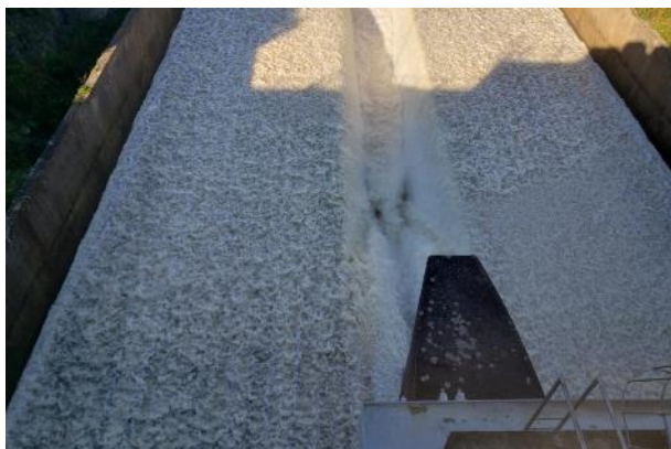
Foto 84: Canal de descarga – Em operação, junto com a abertura parcial (25 cm) de ambas as comportas.
