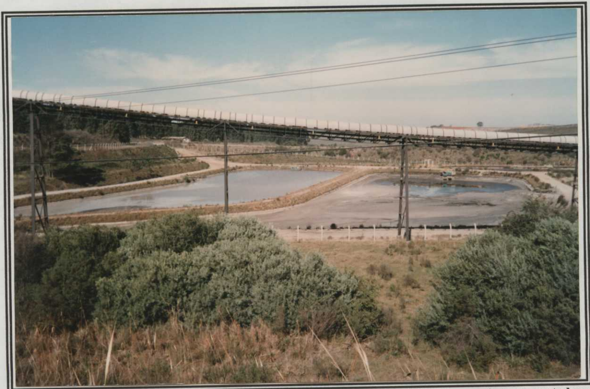
Foto 13 - Sistema de tratamento de águas de pisos e de equipamentos. Vista da correia transportadora proveniente da mina.
