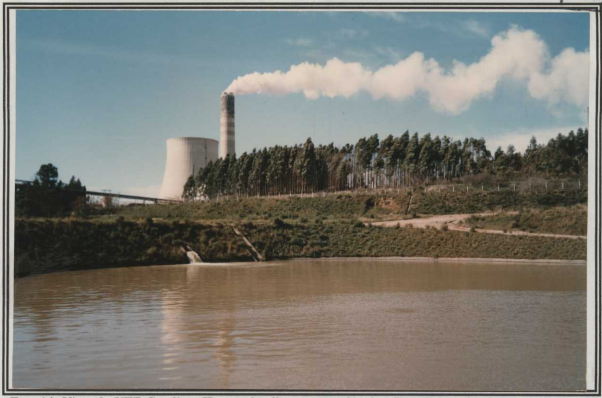
Foto 14 -Vista da UTE Candiota II, com detalhe para a saída do efluente da primeira para a segunda lagoa do sistema de tratamento de águas de pisos e de equipamentos.
