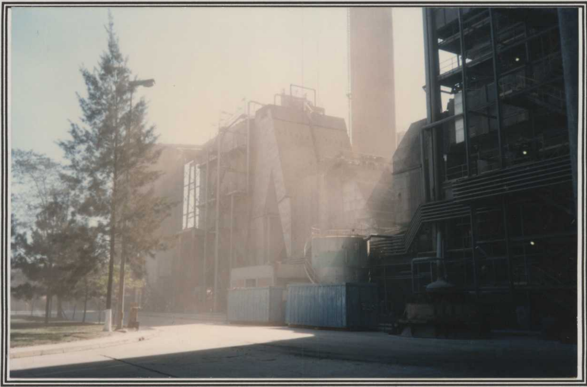
Foto 5 - Caldeira e filtro eletrostático.
