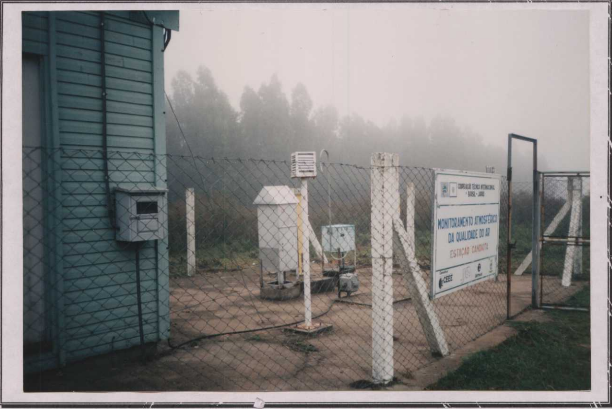
FOTO 02. Estação Candiota de monitoramento da qualidade do ar
