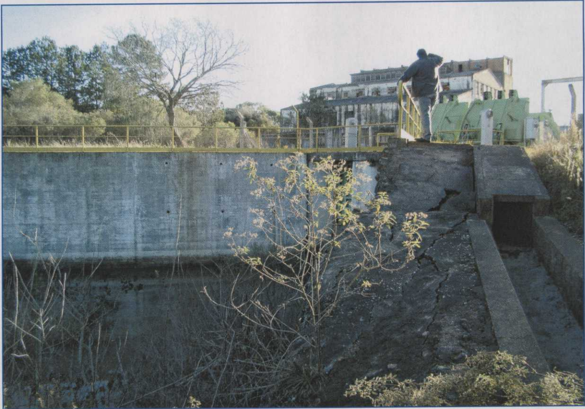
Figura 11. Vista da Entrada do Poço de Bombeamento do Canal de Adução.
