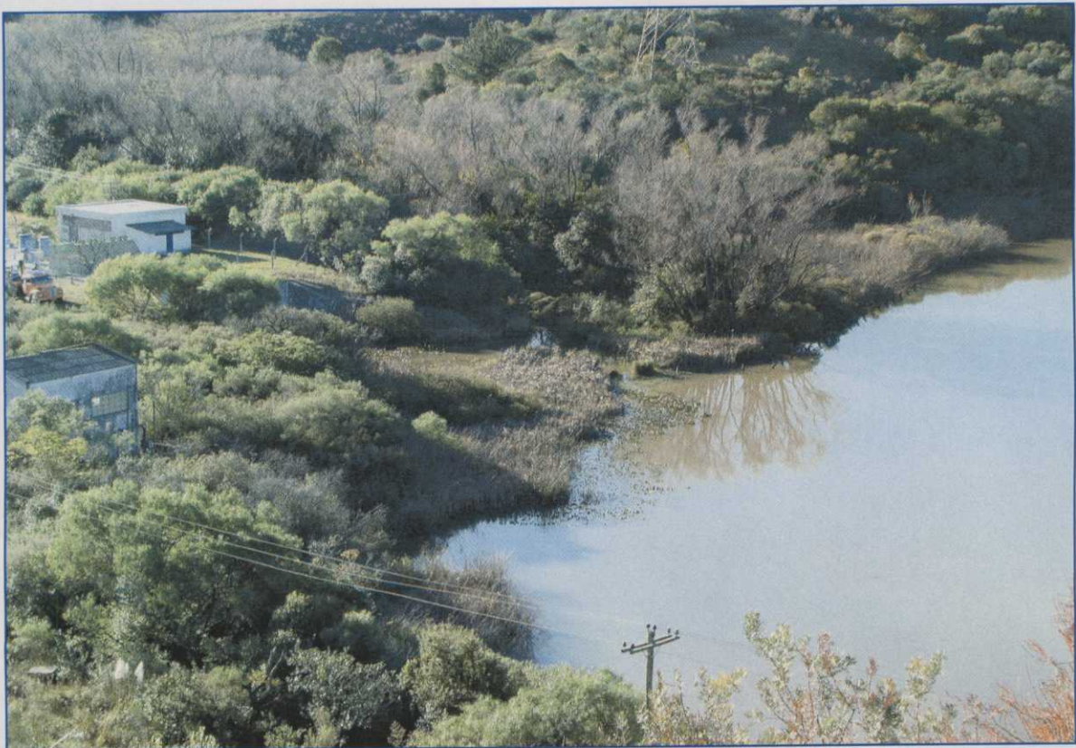
Figura 4. Vista do Canal de Adução.
