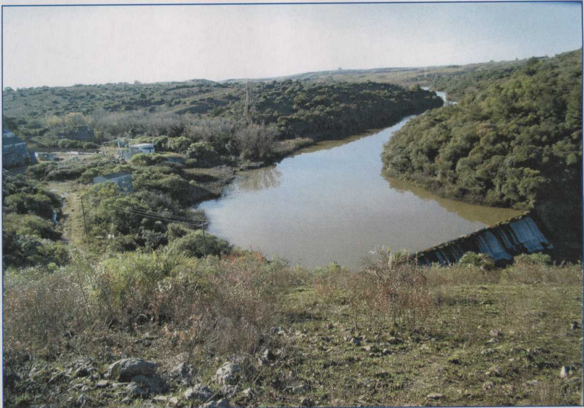
Figura 1. Vista geral da Área da Barragem I.
