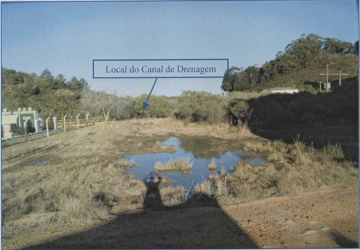
Figura 17. Vista do Local da Bacia de Sedimentação e Canal de Drenagem.
