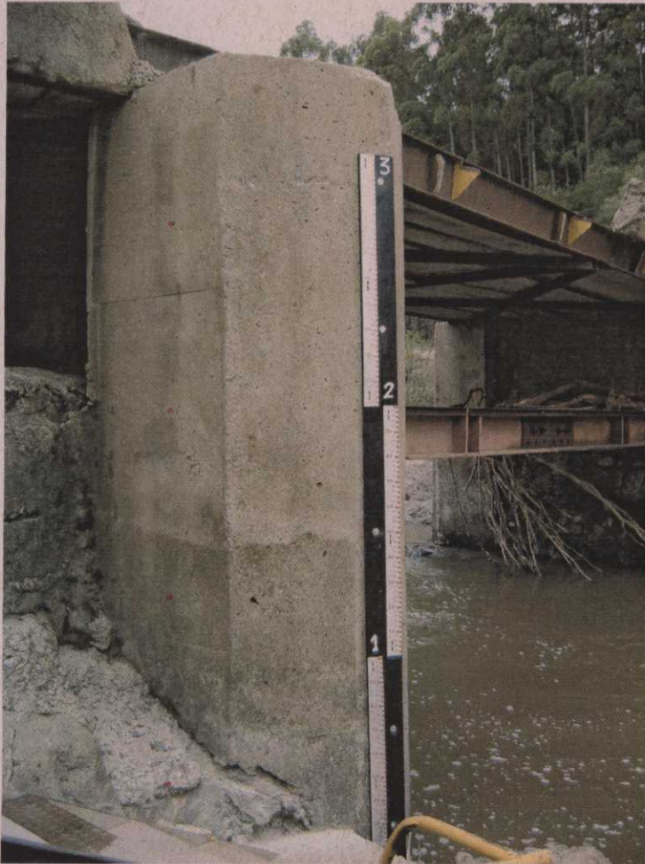
3. Règua instalada no ponto Arroio Candiota Jusante - ACJ.
