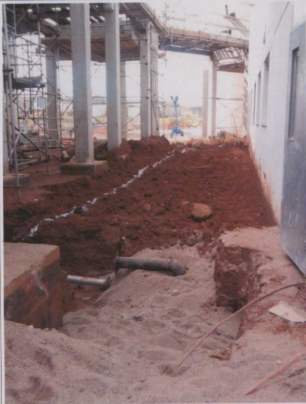
A.62. Montagem e Construção.
