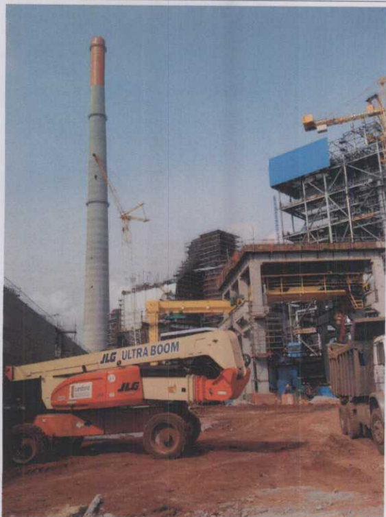
A.64. Montagem e Construção.
