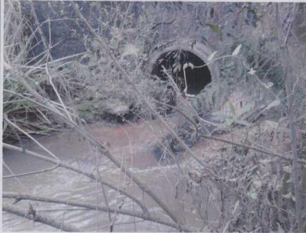
A.47. Emissário da drenagem profunda da fundação da Torre Seca da Fase B
