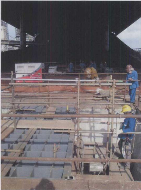
A.25. Ao fundo o Pátio de Armazenamento de Carvão. Abaixo a Moega de Alimentação da Tremonha Subterrânea
