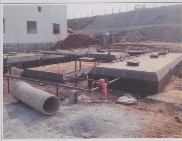
A.35. Sistema de Tratamento de Efluentes Sanitários.
