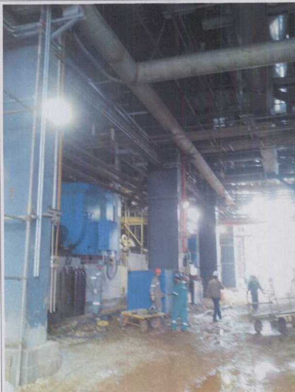
A.19. Montagem de dispositivos do Prédio da Caldeira.
