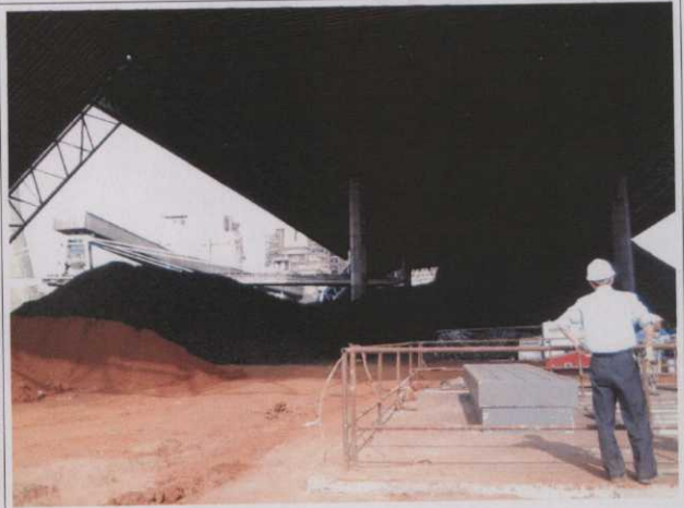
A.87. Pátio Coberto com estrutura metálica para armazenamento de carvão mineral proveniente da CRM.
