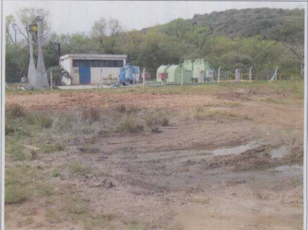
A.50. Captação de Água no Barramento I do Arroio Candiota
