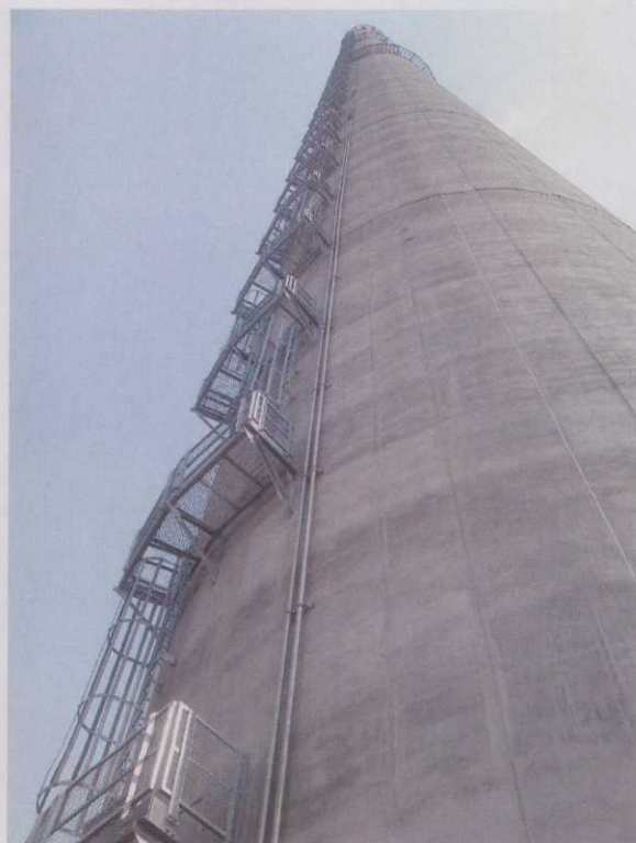
A.10. Escada e plataformas de acesso da chaminé.
