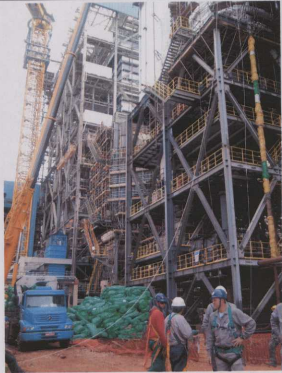
A.61. Montagem e Construção.
