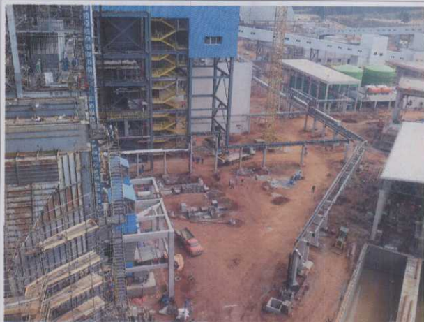
A.66. Montagem e Construção.
