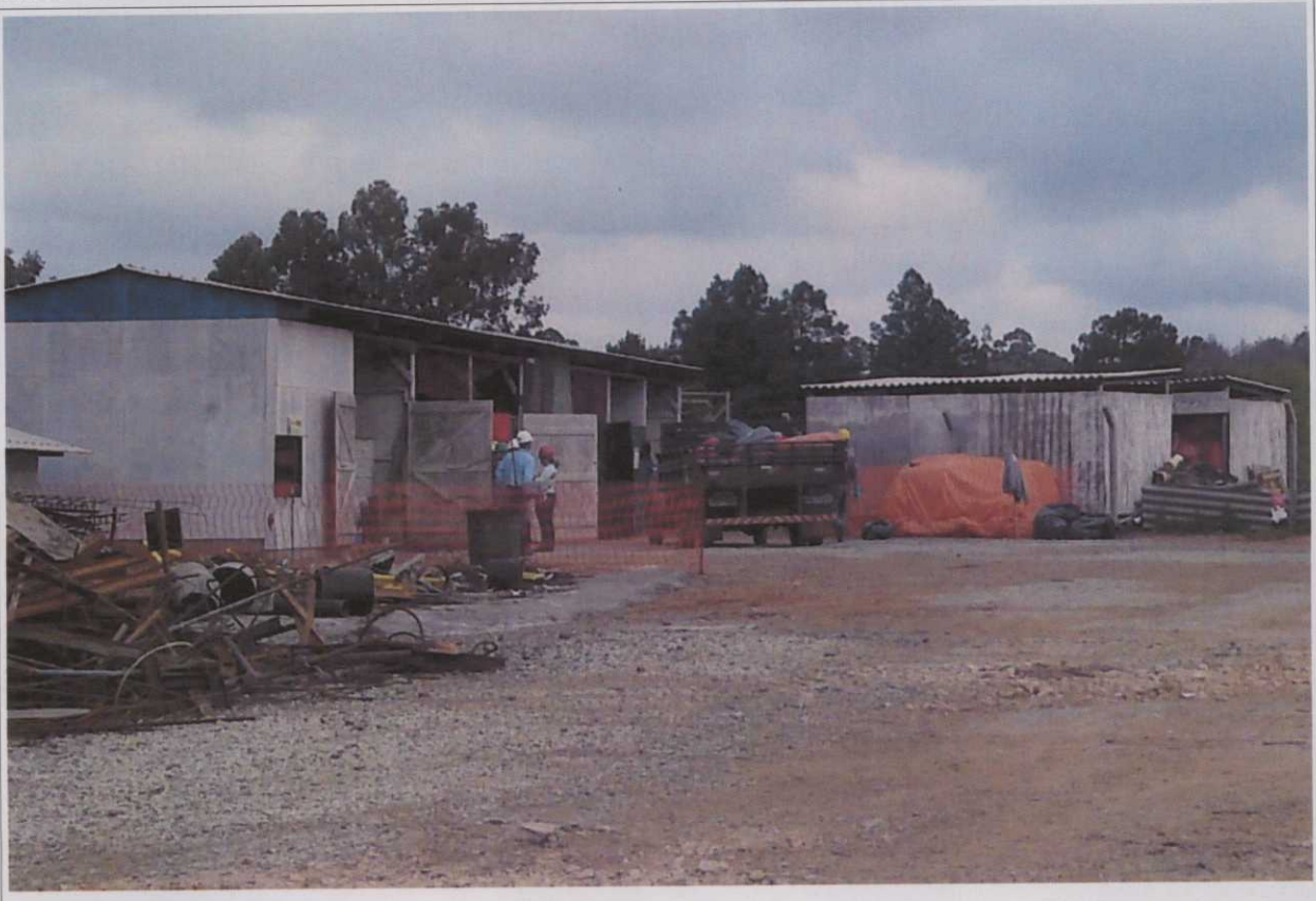
A.53. Central de Armazenamento Temporário de Resíduos Sólidos da obra.
