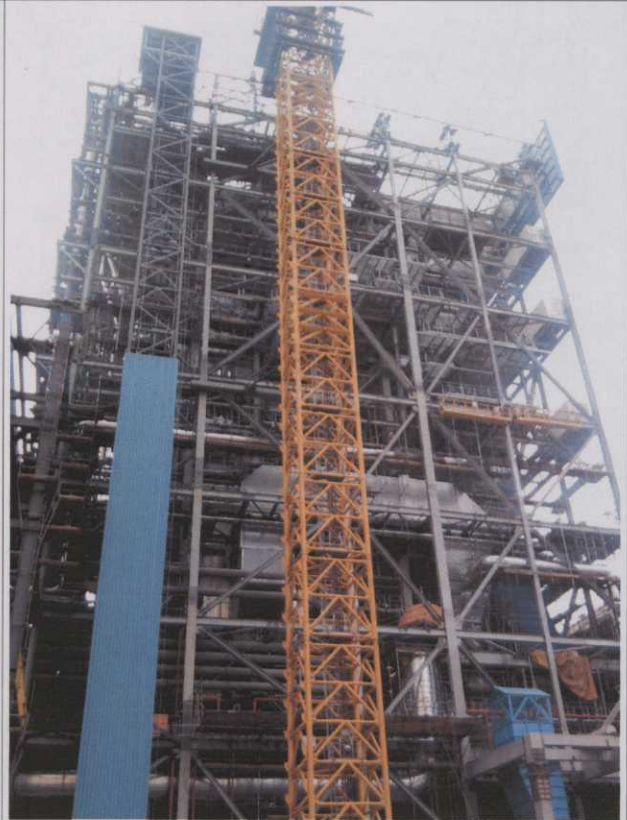
A.15. Prédio da Caldeira.
