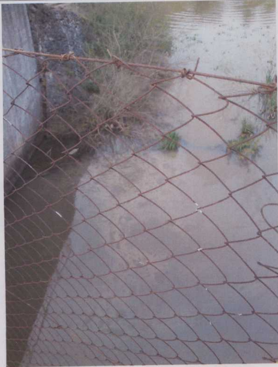
A.84. Área de captação de água.
