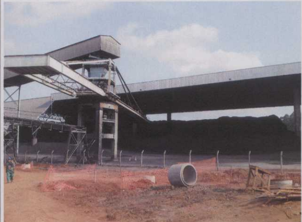
A.24. Pátio Coberto de Armazenamento de Carvão e estrutura de transporte de Carvão da Mina ao Pátio
