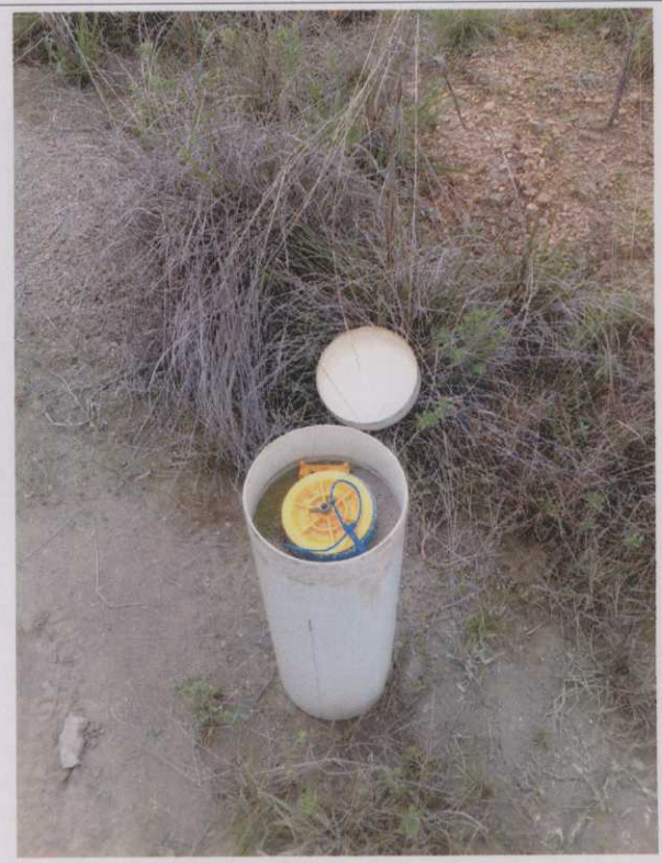
A.55. Poço de Monitoramento de Água Subterrânea - PM10
