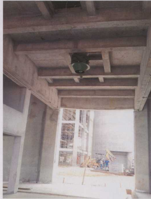
A.8. Sistema pneumático de liberação de cinzas dos silos para as caçambas dos caminhões
