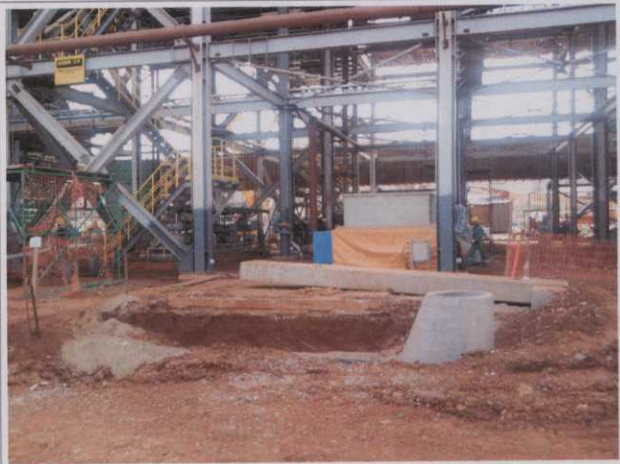
A.63. Montagem e Construção.
