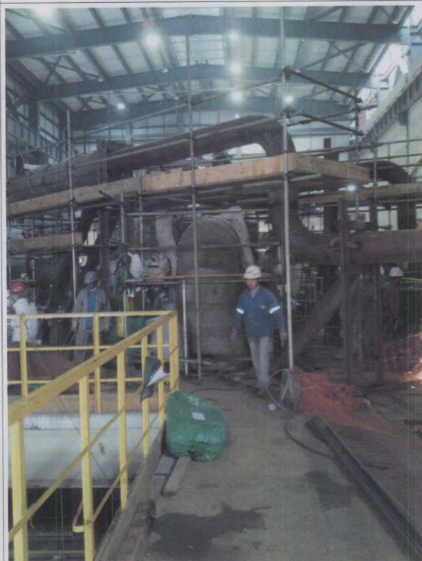
A.20. Prédio da Turbina.
