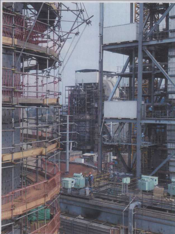
A.67. Montagem e Construção.
