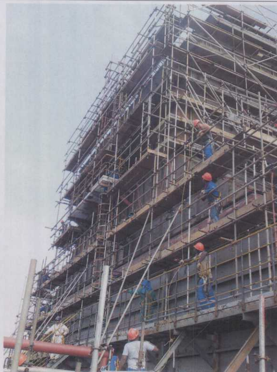
A.65. Montagem e Construção.
