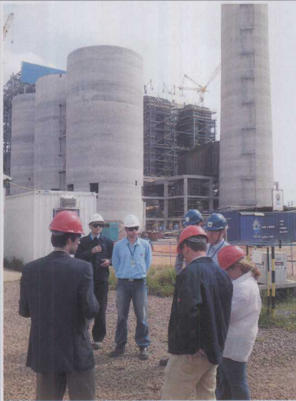
A.4. Entrada do canteiro de obras.
