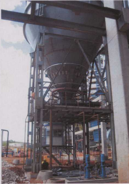
Foto B.13 – Tanque de dosagem
