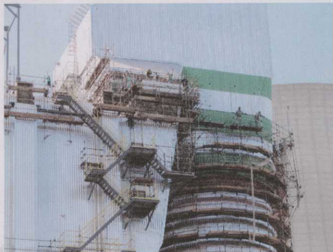
Foto 8: Prédio com andaimes.
