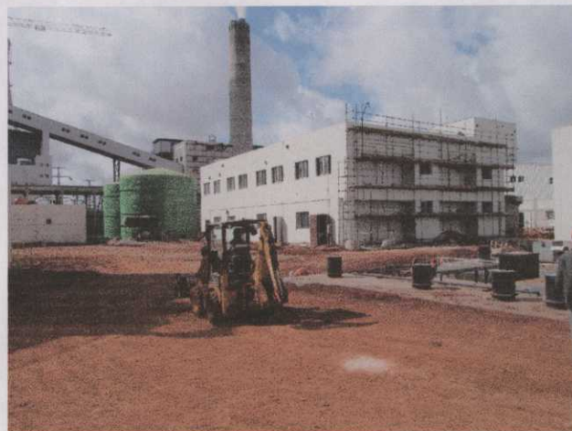
Foto 12: Trator circulando nas obras.
