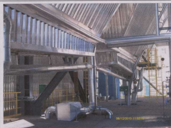
Foto 93 Tremonhas e tubulações iniciais do sistema de transporte de cinza - Precipitador Eletrostático 1
