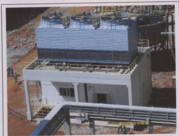
Foto 18 Estação de tratamento/resfriamento água cinza pesada
