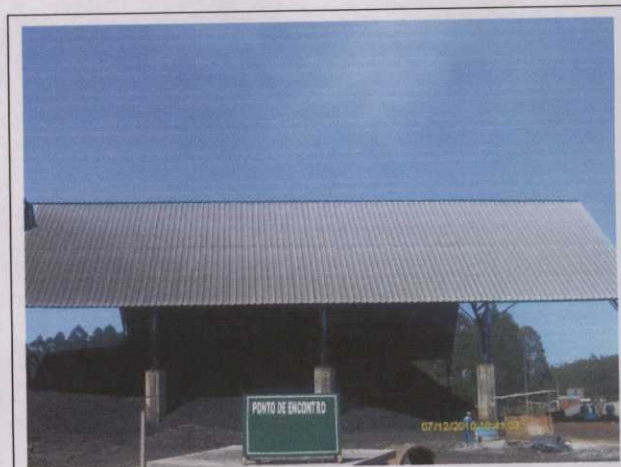
Foto 26 Ponto de Encontro próximo aos Clarificadores
