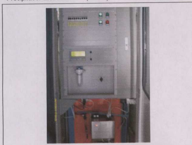
Foto 57 Analisador de gases do sistema de monitoramento contínuo dos gases de combustão no duto de saída do Precipitador Eletrostático 2 – monitoramento das emissões atmosféricas
