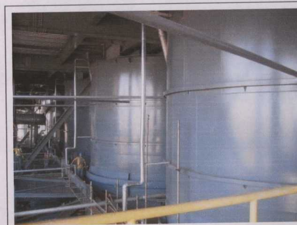
Foto 36 Silos do Carvão (vista lateral)
