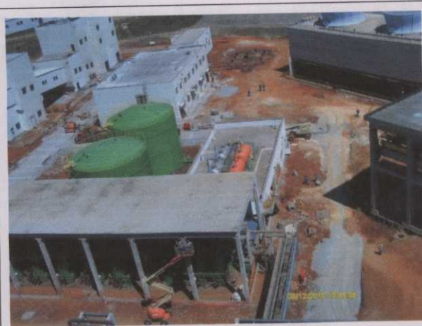
Foto 5 Vias de acesso às Áreas de Abastecimento de produtos químicos - em pavimentação
