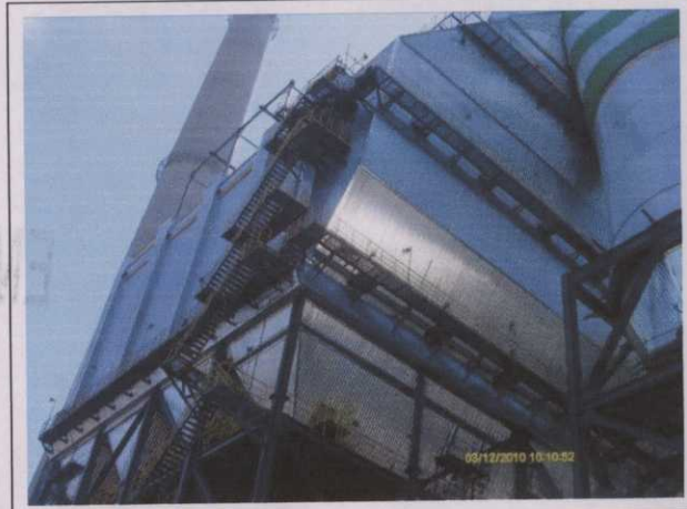
Foto 54 Precipitador Eletrostático 2 (ESP 2)
