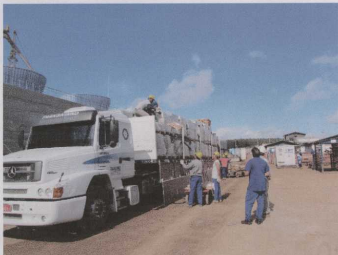
Foto 7: Descarregamento de pacotes de fibra de aço
