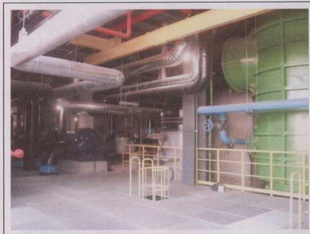
Foto 65 Tubulação Casa Máquina - com isolamento Térmico concluído
