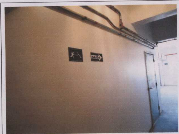
Foto 19 Acesso no Prédio de Controle sinalizado
