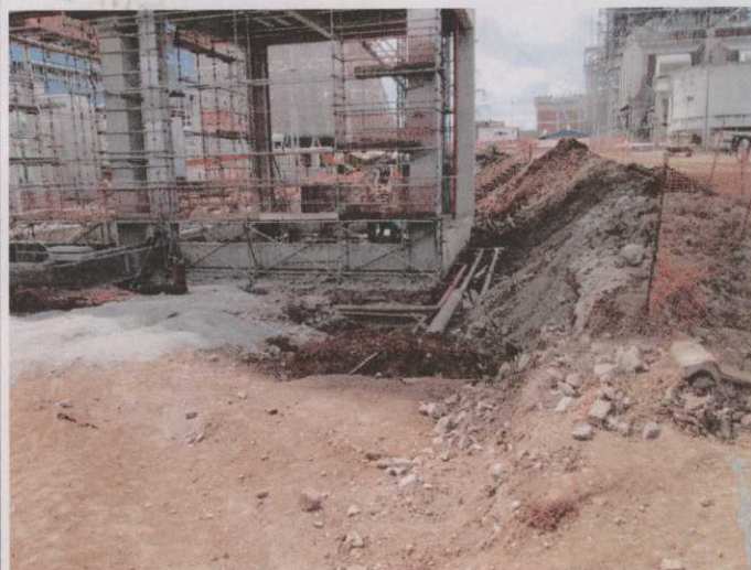
Foto 22: Prédio em construção.
