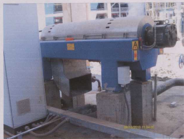
Foto 80 Centrífuga de separação da lama da Estação de tratamento de efluentes industriais
