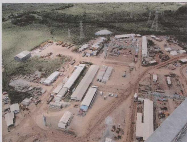
Foto 27: Canteiro de obras.
