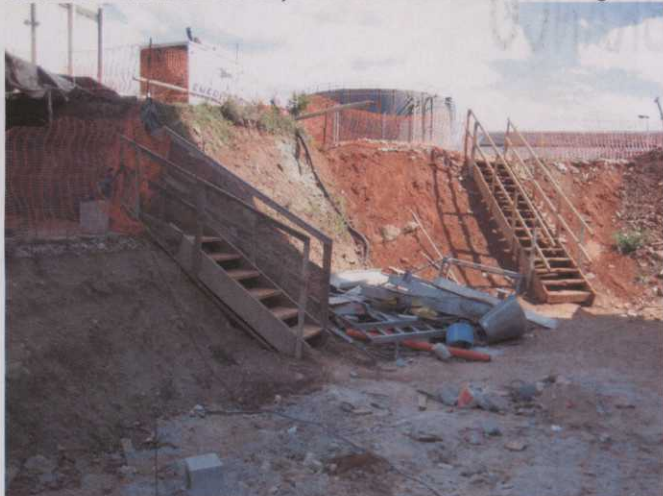
Foto B.45 – Talude sem contenção e arruamento sem obras de drenagem
