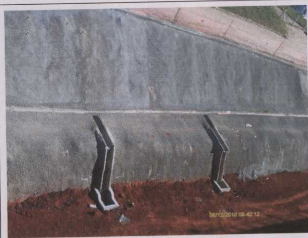
Foto 3 Instalação da drenagem superficial para escoamento das águas pluviais do talude – Concluída
