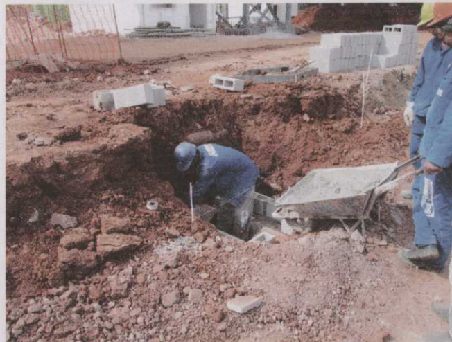
Foto 16: Obras no sistema de drenagem.
