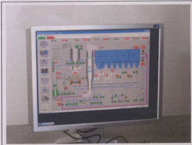
Foto 62 Monitor da sala de comando do FGD
