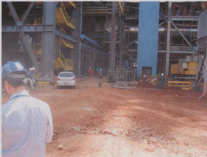
Foto B.43 – Obras ainda em construção
