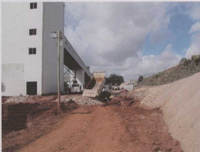
Foto 13: Caminhão descarregando pedras para arruamento.
