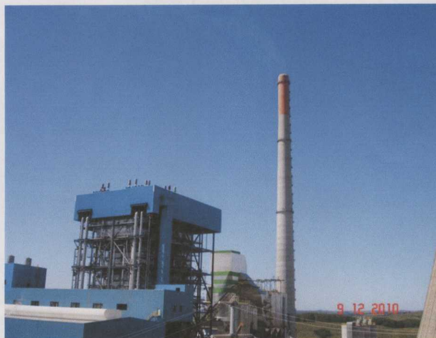
Figura 3 – Vista da chaminé – 210 MW
