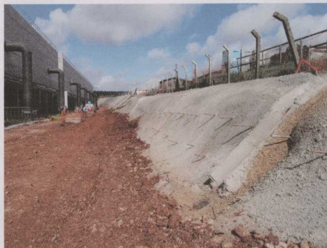
Foto 10: Sistema de drenagem superficial ainda não finalizado.
