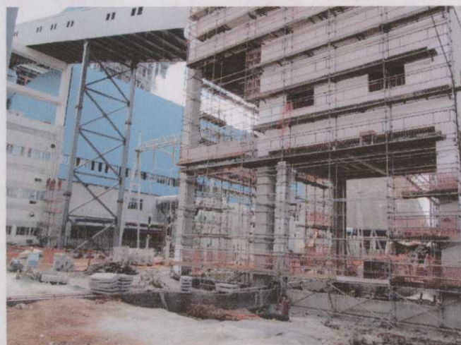
Foto 23: Andaimes em prédio em construção.
