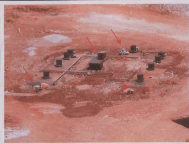
Foto 81 Estação de Tratamento de Efluentes Sanitários (setas indicam os medidores de turbidez e vazão)
