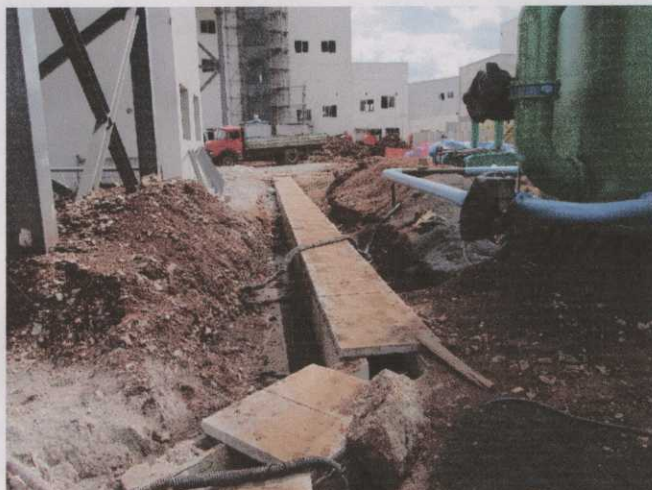
Foto 18: Canaletas ainda descobertas.
