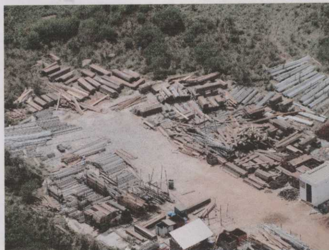
Foto 28: Entulho no canteiro de obras.
