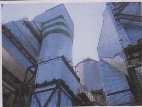
Foto 47 Dessulfurizador (listras verdes a esq.) e ESP1 (dir.)
