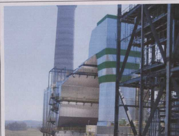
Foto 49 ESP1, Dessulfurizador (listras verdes), ESP2 (a esquerda) e chaminé ao fundo
