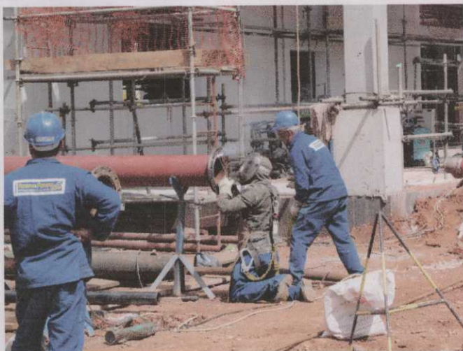
Foto 25: Trabalhadores efetuando soldagem.
