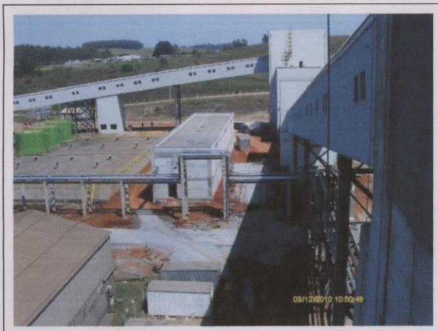
Foto 66 Casa de Bombas (prédio ao centro)
