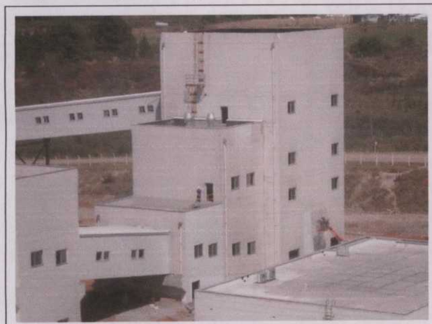
Foto 87 Sistema de transporte de Carvão e ao centro, a Torre dos Britadores de Carvão
