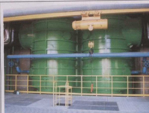
Foto 44 Condensador
