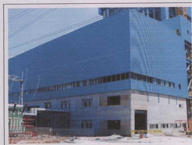
Foto 40 Casa da Turbina - fechamento concluído
